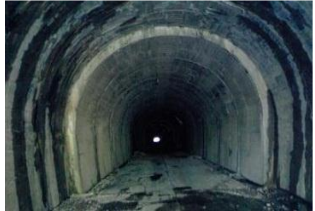
福島側坑口から数十メートル入った坑内の状況。中央の白い点は米沢側の坑口である。
