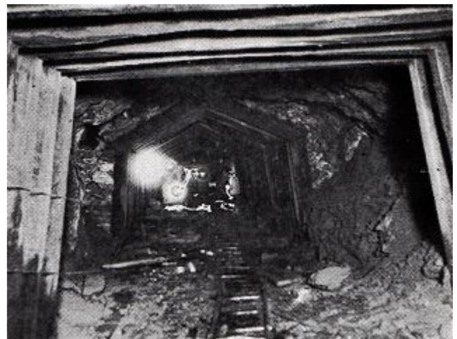
(『工事誌』から転載) 旧栗子隧道内部の様子である。
