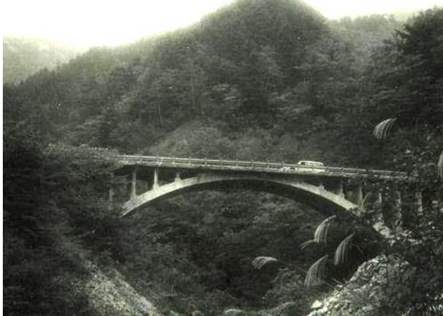
高い位置にある新沢橋、下流から望む。 高欄が設置され安全に米沢方面に向かう車両。 大滝会榎木新吉氏撮影・提供(昭和36年9月26日撮影)
