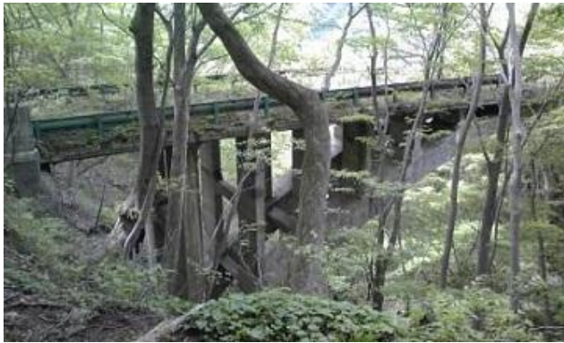
橋梁のアーチ部、橋面、高欄(ガードレール)、親柱などが見える。
