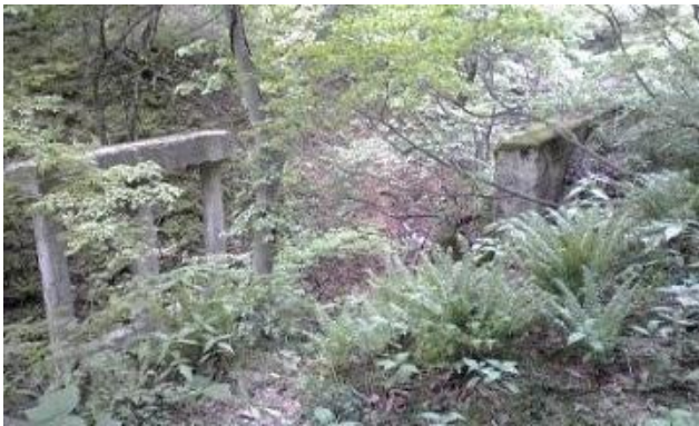
その遺構である福島側の左岸橋台(注2)と左岸側橋脚(注3)が見える。
