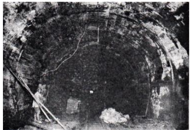
(『工事誌』から転載) 昭和の大改修工事中(本文写真⑥参照)
