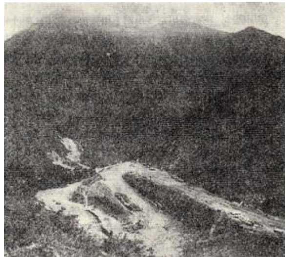
参考写真—4 杭甲坂ヘアピンカーブ群 (栗子隧道福島側)
