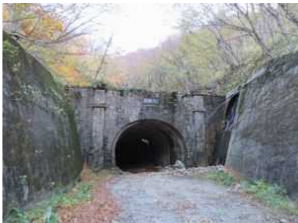
【参考写真-14③】 〈北口 山形側坑口〉 二ツ小屋隧道・山形側坑口 R011104
