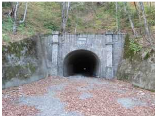
【参考写真-14④】 〈南口 福島側坑口〉 二ツ小屋隧道・福島側坑口 R011104 二ツ小屋山が当時郡境。山形側は伊達郡茂庭村（字杭甲山、與平沢、兎澤沢、上小川）であったが明治 22 年 4 月この4字が信夫郡中野村に編入された。
