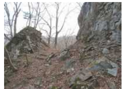
【参考写真－23 ⑦】 掘割、福島側から望む。
