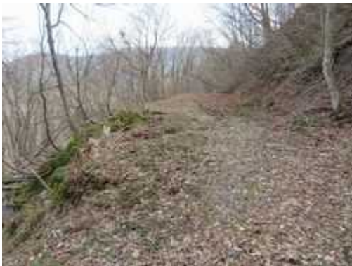
【参考写真－18⑧】 中間のカーブ手前（福島側）から米沢側を望む。
