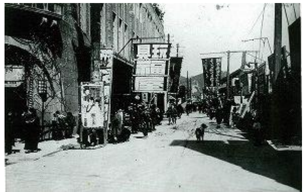
【写真-12】 本町交差点、旧福ビル(左建物)角から旧スズラン通り(旧万世大路)万世町方向を望む(昭和 7 年 3 月)。現在の街なか広場角からバセオ通りを望む構図(写真-3 参照)。当時の旧国道 5 号分岐点で戦後の新道路法に基づき旧国道 13 号の起点となった。スズラン通りは、国(内務省)直轄工事として道路工事(コンクリート舗装)が初めて実施された場所である。(昭和 6 年度失業救済土木事業)
