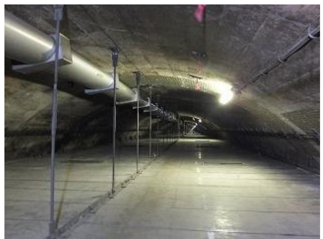
【写真-16】 東栗子トンネル送気ダクト送風中、金具取付のリボンがなびいている。天井版撤去（補修後：中空押出セメント板（当初軽量コンクリート版））。福島坑口50m付近から米沢側を望む。H250925
