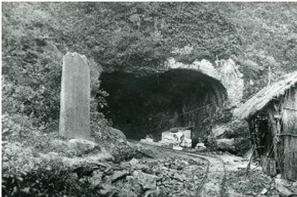
【写真-5】 明治期栗子隧道米沢側坑口（右）と「栗子隧道碑記」（左）、昭和9年「昭和の大改修」時（60m先の既設隧道の切詰め作業中）昭和9年
