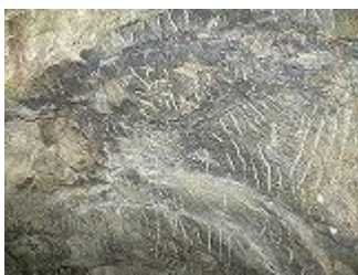
【写真-7】 明治期栗子隧道米沢坑口のノミ掘削跡 H231001
