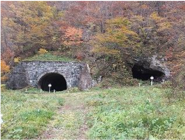
【写真-11】 並んで佇む「栗子隧道」(米沢側坑口) 右側初代:明治14年(1881年)9月完成)。左側2代目:昭和11年(1936年)8月完成 H251101
