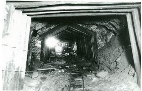
【写真-8】改修前の栗子隧道坑内、「昭和の大改修」栗子隧道改修工事中(昭和9年)。
