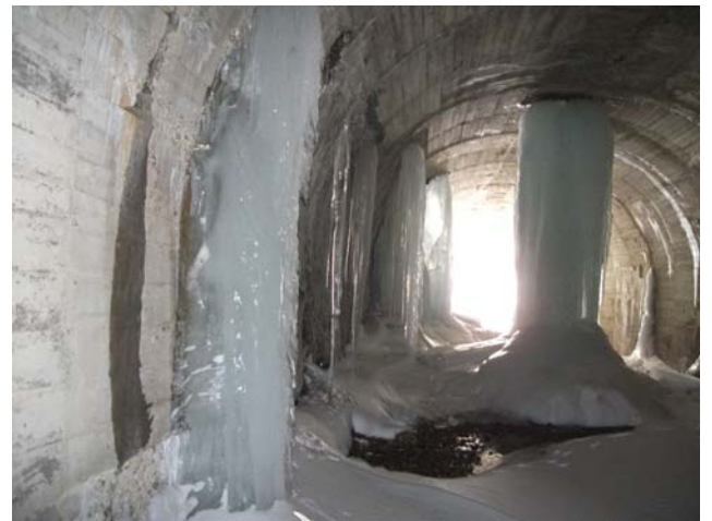
写真—11 坑内から米沢側坑口を望む
