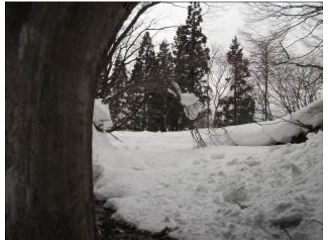
写真—19 福島側坑内から望む。左側下に氷結していない部分（排水溝）が見える、右側雪庇箇所上附近が旧ニツ小屋駐在所跡と思われる。
