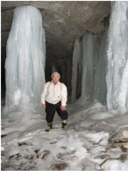
米沢坑口巨大氷柱
