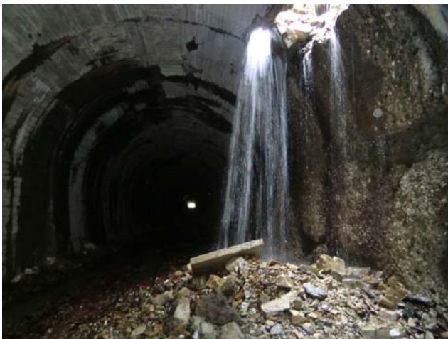
写真-13 (伊藤弘治様 平成22年11月撮影提供) 米沢側坑口 附近、大崩落 前掲写真-12 箇所
