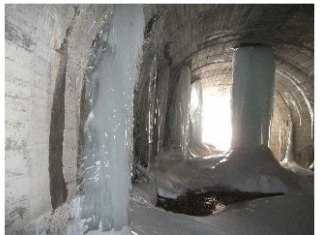
坑内から米沢側坑口を望む
