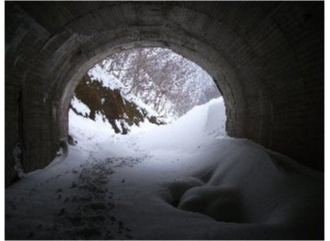
米沢側坑内から烏川橋方向を望む
