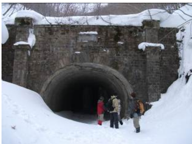
写真-17 ニツ小屋隧道米沢側坑門
