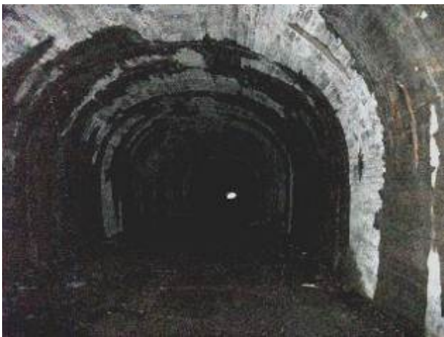
写真-9 平成22年(2010年)11月6日撮影、福島側坑口から約20m附近、1番目の内巻コンクリート箇所
