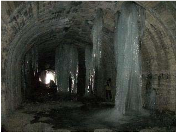
2箇所目の内巻き附近から福島側坑口を望む
