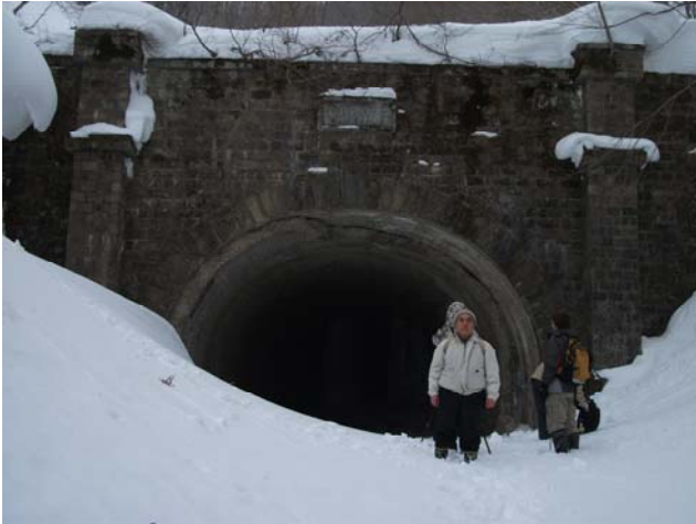
二ツ小屋隧道米沢側坑門にて
