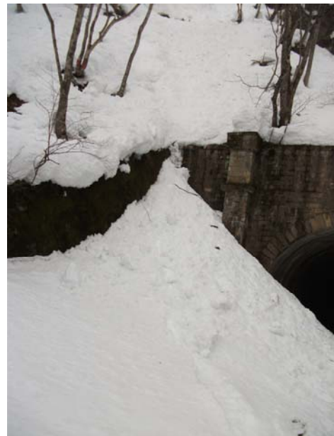
ニツ小屋隧道福島側坑門、映画「赤い殺意」雪の滑り台
