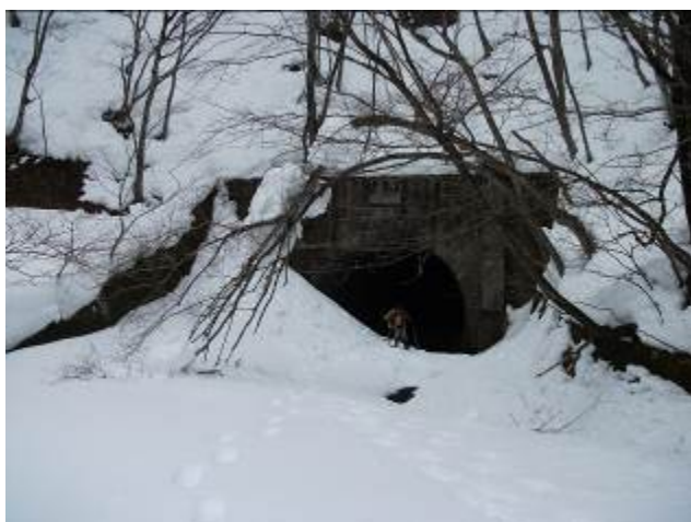
写真—7 雪に埋もれる二ツ小屋隧道福島側坑口
