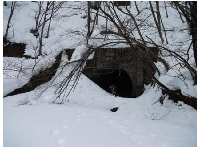
ニツ小屋隧道福島側坑口正面
