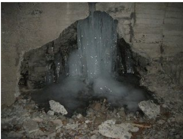
中央部附近、側壁崩壊・柱状石
