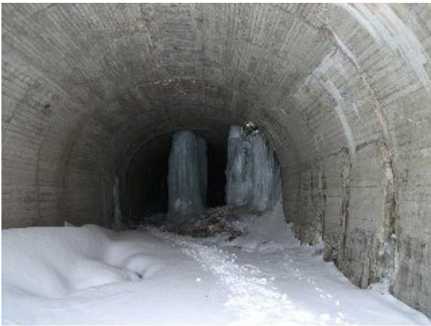
米沢坑口から巨大氷柱を望む
