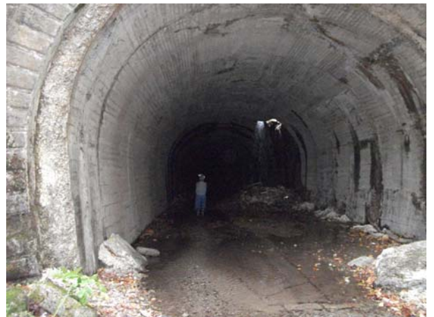
氷結してない時の二ツ小屋隧道米沢側坑口（平成22年11月撮影）
