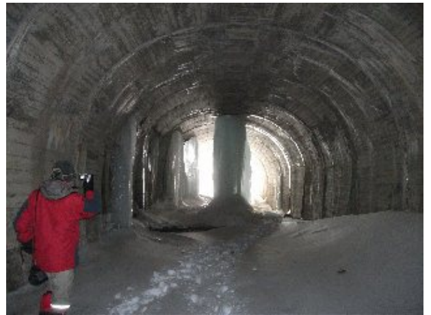
坑内から米沢側坑口を望む
