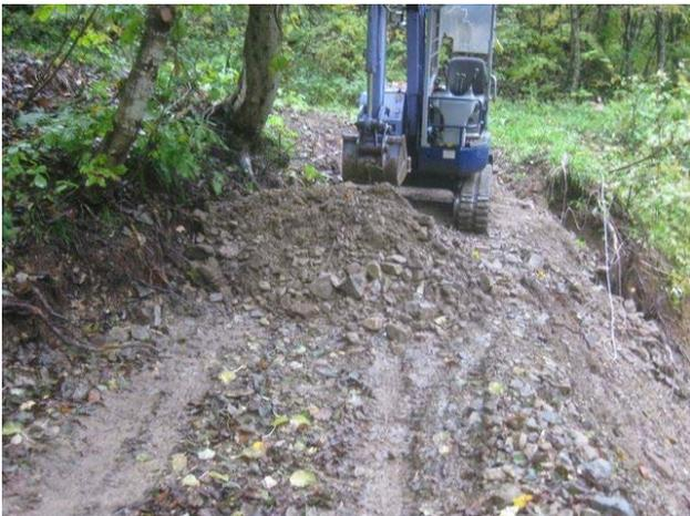
写真-4⑨ 烏川橋先崩壊箇所の補修
