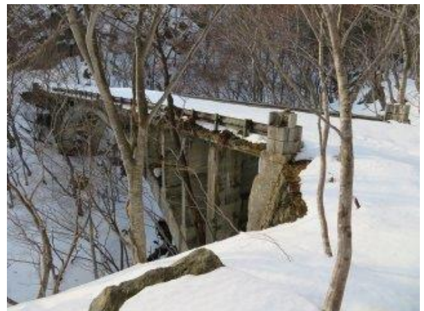
写真-3② 3代目新沢橋。 新沢左岸(福島側)下流側から望む。
