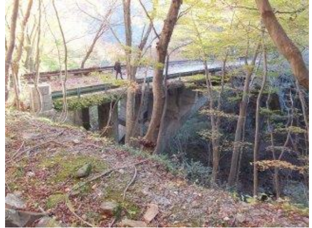
写真-2③ 新沢左岸(福島側)上流側から望む。
