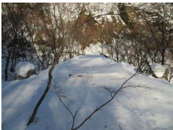
写真－1① 3代目新沢橋（「昭和の大改修」S11.12 完、L=42m、w=6m）。米沢側（右岸）から福島側（左岸）を望む。
