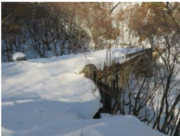
写真-3① 3代目新沢橋。 新沢右岸(米沢側)下流側から望む。
