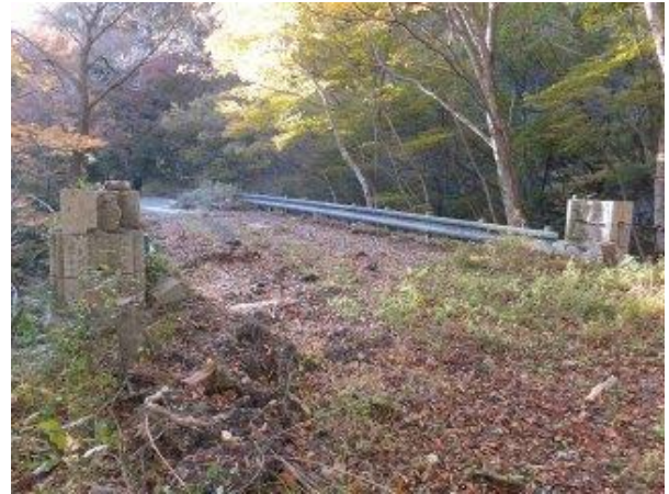
参考写真-2① 新沢橋を福島側(左岸)から望む。
