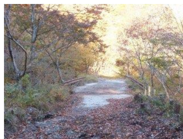
参考写真－1② 新沢橋、米沢側から望む。 H301103
