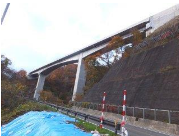
【写真－16③】 大滝大橋(H25.10 完、L=201m、W=10.5m)。左下国道 13 号現橋「長老沢橋(S39.9 完、L=40.8m、W=8.5m)」
