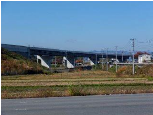
【写真－18③】 E13 東北中央自動車道 万世高架橋(H28.3 完、L=336m、W=11.5m)。国道13号沿い(下り側)FamiMa 米沢万世町桑山店前交差点付近から望む。
