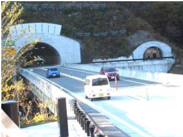
【写真－17②】 E13 栗子トンネル 福島側坑口。右は将来車線側・現在避難用トンネル(避難坑)(L=8,989m)。
