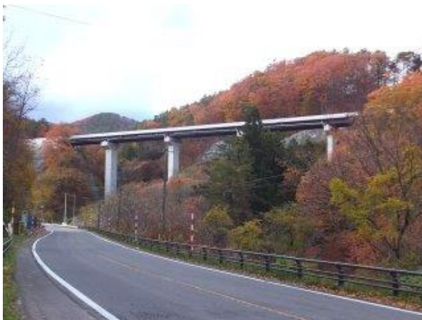
【写真－16①】 E13 新大鍋橋(H28.1 完、L=168m、W=10.5m)。左下国道 13 号現橋「大鍋橋(S39.8 完、L=25.7m、W=8.5m)」
