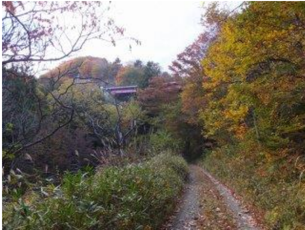
【写真－13①】 旧国道から3代目現国道13号西川橋（L=98.8m、W=8.0m、S39.9完）を望む。
