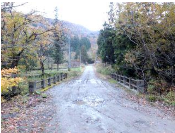
【写真－5③】 旧大滝橋、福島側から望む。 右奥の建物は大滝会事務所（旧ポンプ小屋）。 写真左奥の橋のたもとは榎木新松（新吉）家跡地、その奥の電柱間付近は木村要吉（義吉）家跡地および須田辰蔵（辰雄）家跡地、その道路向い側は太見吉佐（正一）家跡地
