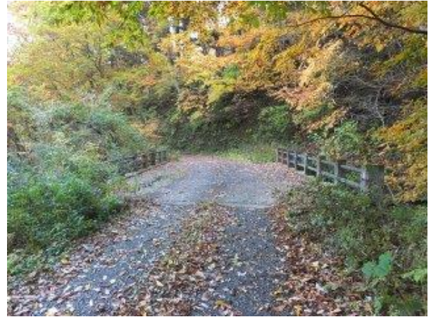
【写真－9②】 いら沢橋、米沢側から望む。
