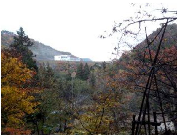
【写真－8⑤】 E13 東北中央自動車道防災センター (大滝チェーン着脱場)。 大滝分校跡(上)から望む。
