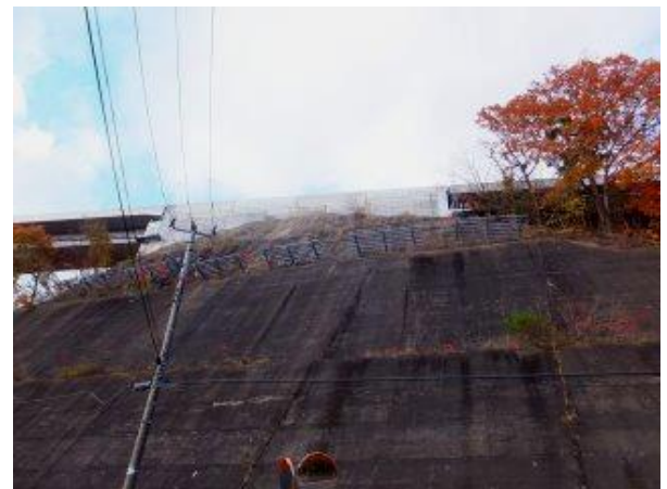
【写真－16②】 新大鍋橋(右側)と大滝大橋とのジョイント部。現国道 13 号から望む。
