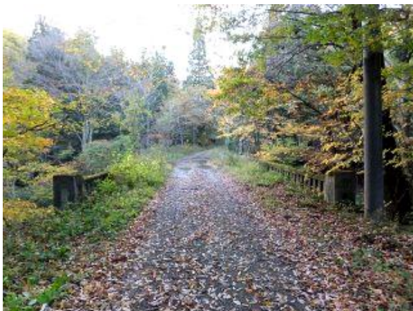
【写真－10①】 胡桃橋（S11.3 完、L=15.0m、W=6.6m）、福島側から望む。右側の電柱右奥は二階堂盛吉家跡地
