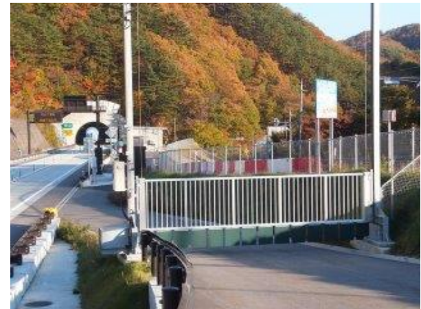
【写真－17③】 左側 E13 大滝トンネル(H19.6 完 L=353 m、W=9.5m) 右国道13号大滝第1トンネル(S40.3 完 L=200m、W=8.5m)
