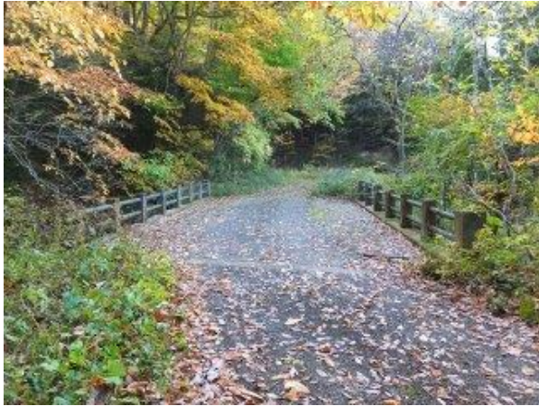
【写真－9①】 いら沢橋(S40.7 完、L=10.5m、W=5.5m)、福島側から望む。
