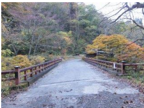
【写真－3①】 旧葭沢橋(S53.3 完、L=22.4m、W=6.7m)、福島側から望む。橋入口右奥は伊藤長三郎家跡地
