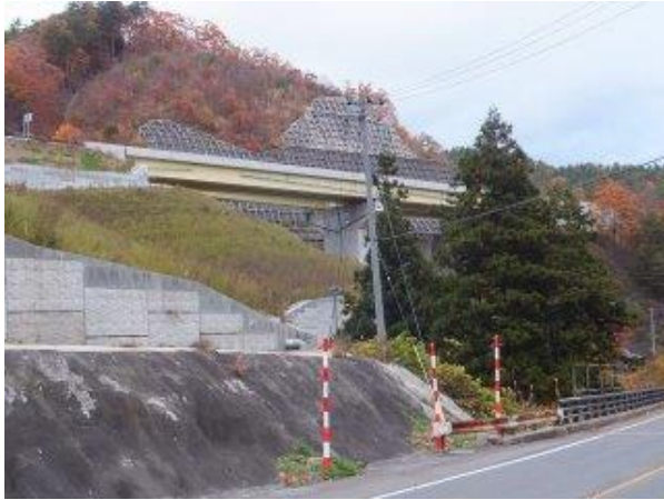
【写真－16⑤】 新大滝橋(H28.1 完、L=113m、W=10.5m)
