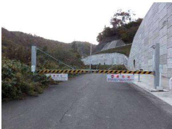
【写真－1①】 大滝集落入口 (旧国道 13 号、現福島市道長老沢線)、米沢側を望む。門扉は施錠されていない。出入り自由。
