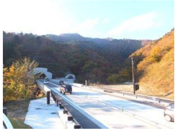
【写真－17①】 E13 新栗子トンネル (S27.3 完、L=8972m、W=9.5m) 福島側坑口
