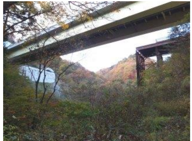
【写真－13④】 E13新栗子トンネル避難坑福島側坑口。手前新西川橋（H20.10完、L=77m、W=10.5m）。
