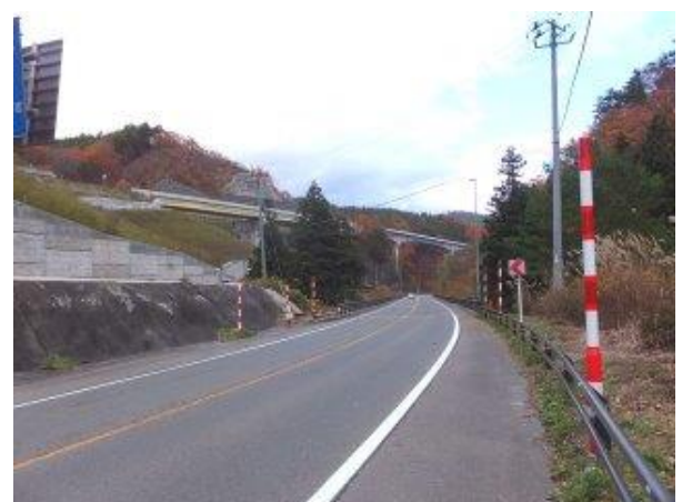
【写真－16④】 E13 新大滝橋(左側)と大滝大橋、国道 13 号の現橋は大滝橋(H2.3 完、L=165m)。
