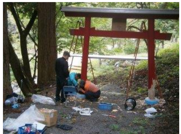
写真一2① 補修作業
