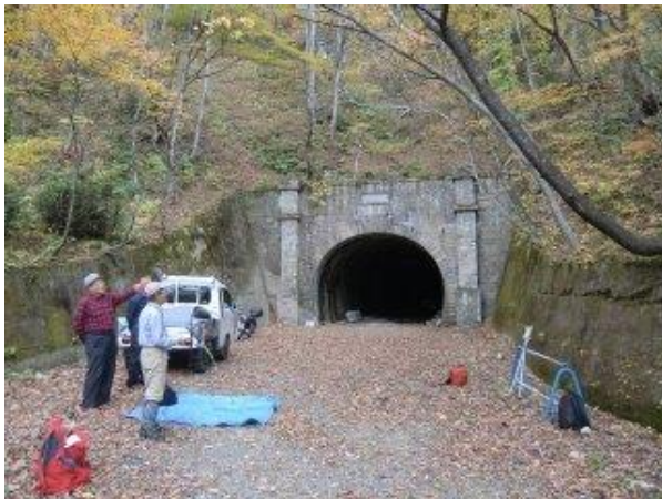
写真-10③ ニツ小屋隧道到着 (「昭和の大改修」2代目、L=384m、 W=6.5m、S9.12完)。
