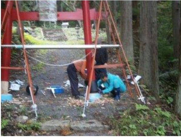
写真-2② 補修作業
