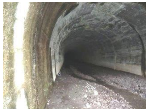
写真-8③ 栗子隧道福島側、坑内を望む。
