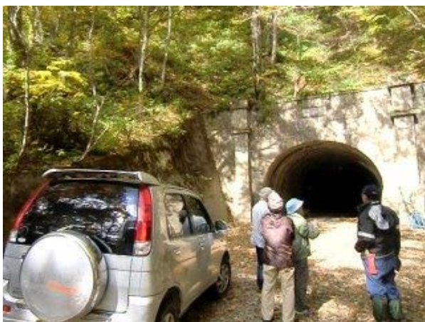
写真-5① ニツ小屋隧道到着
