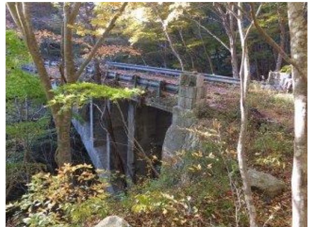
写真-11 新沢橋 (「昭和の大改修」L=42m、w=6m S11.12完)。福島側下流から望む。
