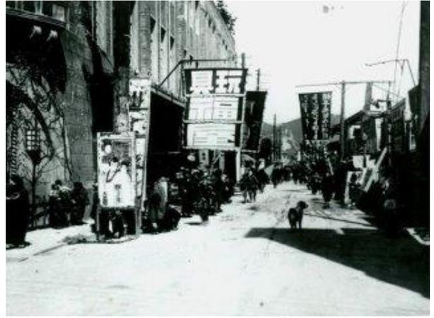
【写真-1②】 昭和8年頃の旧万世大路スズラン通り(現パセオ通り)。昭和6年我が国最初の国(内務省)直轄道路工事の一つ、特殊なコンクリート舗装を実施、表面が石面(石たたみ)のように見えた。左側旧福ビル(現まちなか広場)。
