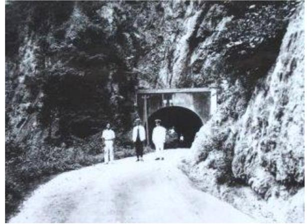
【写真-5②】 昭和 5 年に改修された高平隧道(コンクリート巻立、L=132.45m)。昭和の荷馬車輓きが松明かざして通る。昭和 8 年頃。
