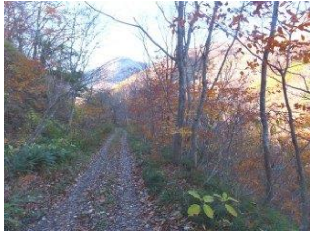
【写真-5①】 ニツ小屋隧道～烏川橋、(中間点)
