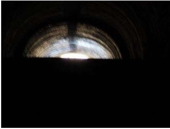
【写真-14⑥】 中央地平線は栗子隧道最高地点部。 (福島側から 400m 付近、H≒888m、 明治隧道貫通点付近)。 県境付近から坑口を望む。
