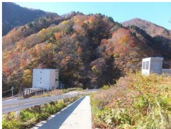
【写真一③】 栗子トンネル新（右側）・旧（左側、現在運用廃止）換気塔。連絡路入り口から望む。手前小径は管理用通路からの取付坂路。
