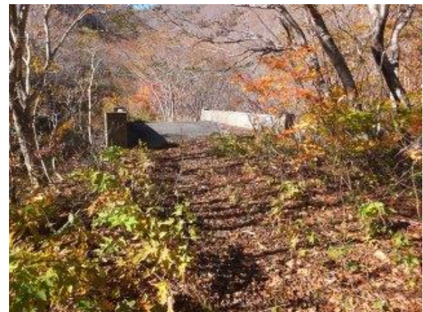
【写真-9⑥】 杭甲橋(S11.11完、L=11.7m、 W=6m)、福島側から望む。
