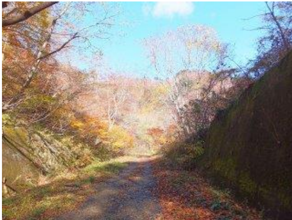
【写真-4⑤】 ニツ小屋隧道米沢側、 坑口付近から望む。
