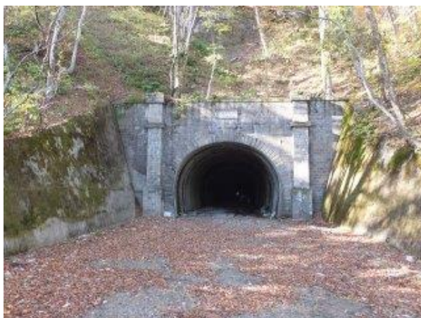
【写真-4①】 ニツ小屋隧道(S9.12 完、L=384m、W=6m)福島側坑口。
