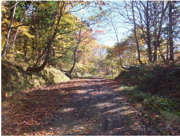
【写真-3 ③】 ニツ小屋隧道福島側、坑口付近から望む。
