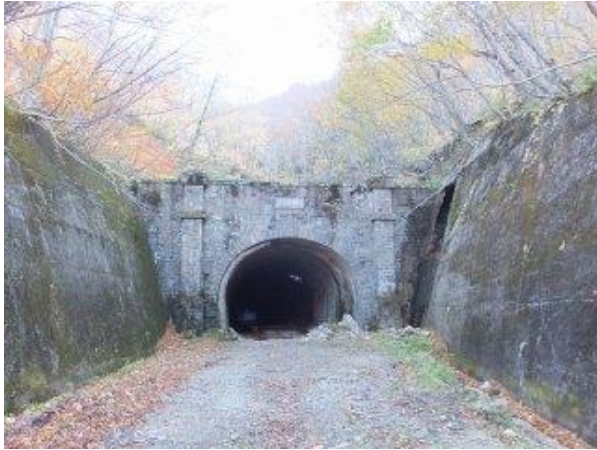
【写真-4③】 ニツ小屋隧道米沢側。
