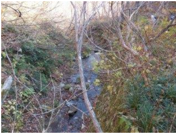
【写真一11④】 杭甲沢(3号～2号カーブ間左側)、 下流側を望む。 万世大路側に石積の護岸が見える。
