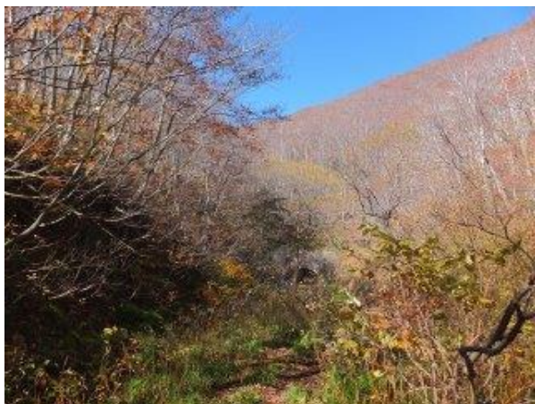
【写真-13①】 栗子隧道（福島側坑口）見ゆ。
