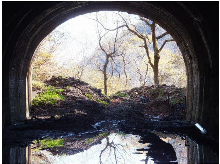
【写真-14⑦】 栗子隧道坑内から坑外を望む。
