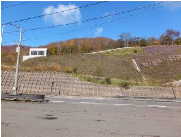
【写真一①】 旧国道への連絡路・新換気所管理用通路と旧工事用道路への取付道路（上段ガードレール部）。
