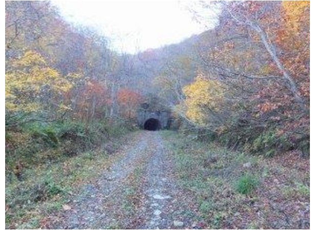
【写真-4④】 ニツ小屋隧道米沢側。
