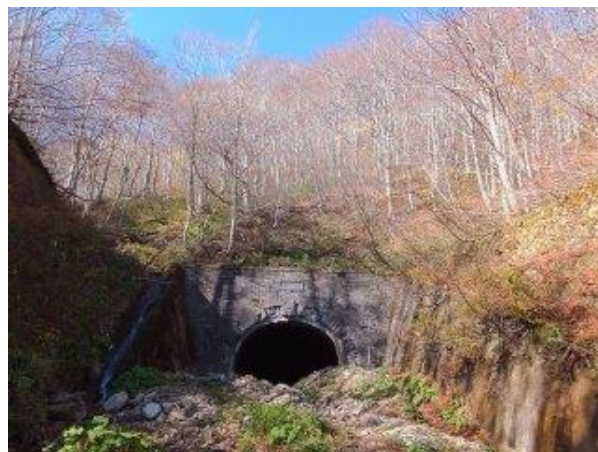
【写真-13②】 栗子隧道福島側。 左上林の奥は小杭甲。
