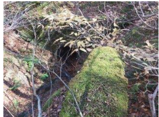
【写真-12②】 小杭甲橋の代替溝橋(暗渠、内空幅 2.2m、同高さ 1.7m、長さ 18.5m) S11 年完。手前は小杭甲橋右岸側橋台。
