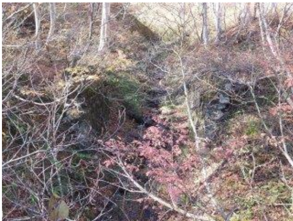
【写真-12①】 杭甲沢・小杭甲橋橋台遺構(推定 L=4m、W=5.5m)。昭和の大改修で溝橋(暗渠)に改築された。栗子隧道 137m 手前。
