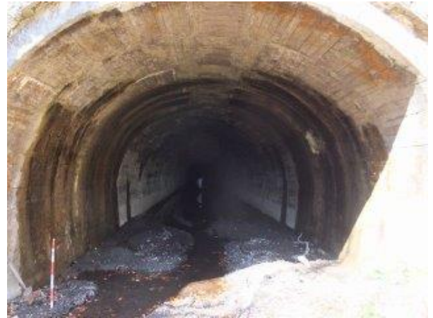
【写真-14①】 栗子隧道福島側坑口から坑内 米沢側を望む。
