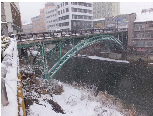
㉕ 3代目「十綱橋」(L=54m、W=6.8m 鋼アーチ橋) 大正4年(1915)9月完成、平成27年(2015)9月 100周年) 下流右岸飯坂線飯坂温泉駅から望む
