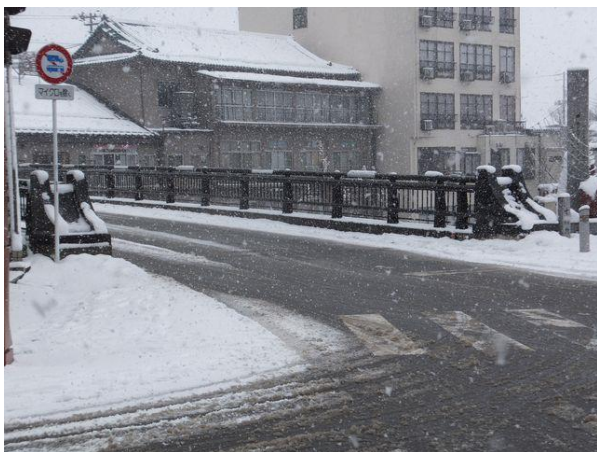
㉓ 3代目「十綱橋」(L=54m、W=6.8m)、 右岸飯坂温泉駅側から望む
