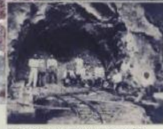
明治8年のニツ小屋隧道東口工事の様子
