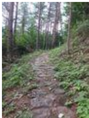
【写真-1①】 旧板谷(米沢)街道石畳 幅約 90 cm (3 尺) (荷車通行不可)
