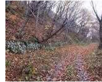
【間知石積擁壁】
