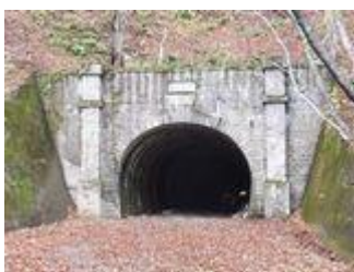
【写真-10①】 ニツ小屋隧道 福島側坑口 美麗なる坑門
