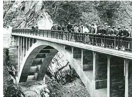
【「昭和の大改修」、第3代新沢橋】
