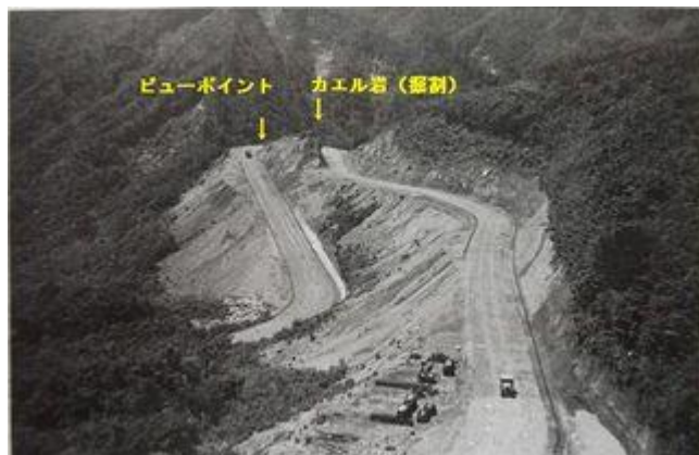
【写真-2】 「昭和の大改修」ニツ小屋隧道前の最初のヘアピンカーブ全景 昭和 9 年
