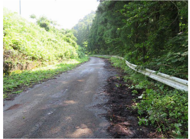
写真-9⑥ 除草作業終了、 吉田まんじゅ屋跡付近から福島側を 望む。
