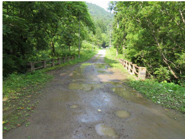
写真-8② 除草後(R元0623&0730実施) 大滝橋福島側から大滝地区を望む。
