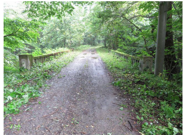
写真-3② 除草後(R元 0727 実施)。 胡桃橋を福島側から望む。
