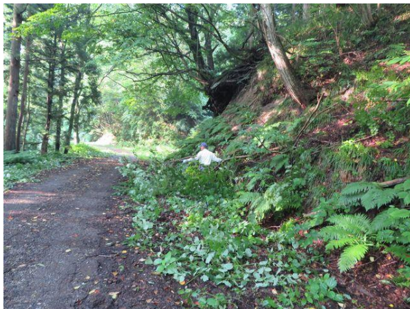
写真-10③ 入いら澤橋米沢側、枝払い
