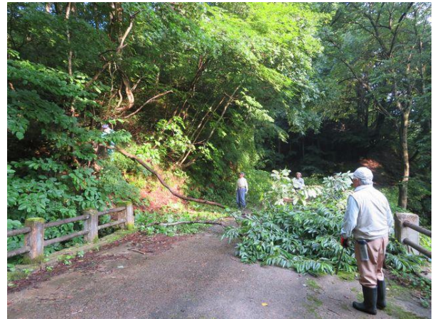
写真-10② いら沢橋米沢側、伐採枝払い
