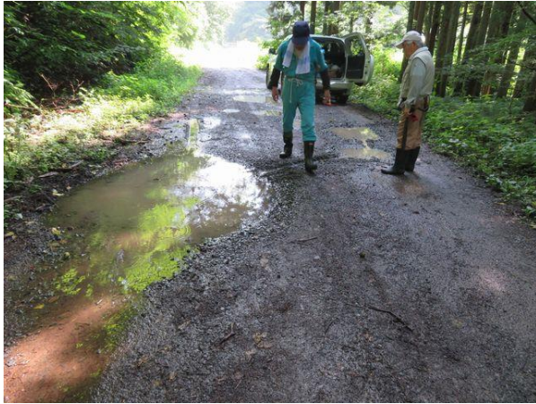
写真-13⑤ 水溜処理、 葭沢橋米沢側
