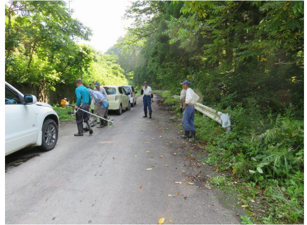
写真-13⑥ 作業終了。 吉田まんじゅ屋跡付近
