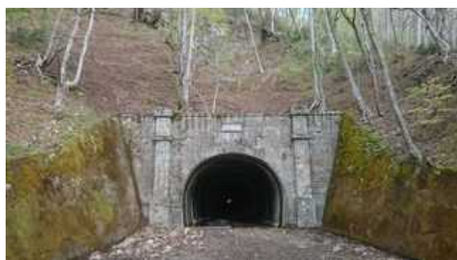
写真 15-2 ニツ小屋隧道 福島側坑口。
