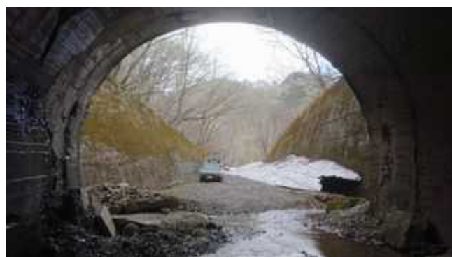
写真 16-2 米沢側坑口から望む。
