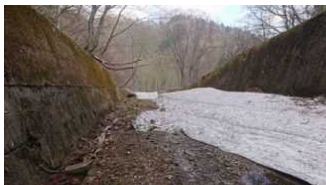
写真 16-3 米沢側坑口残雪状況。
