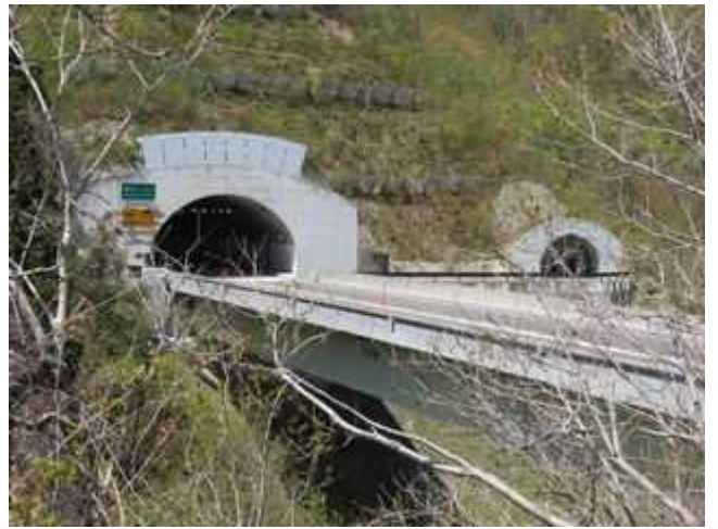
写真 14-4 E13 新栗子トンネル(L=8,972m)福島側坑口。 右側は避難坑。手前新西川橋(4 代目)。
