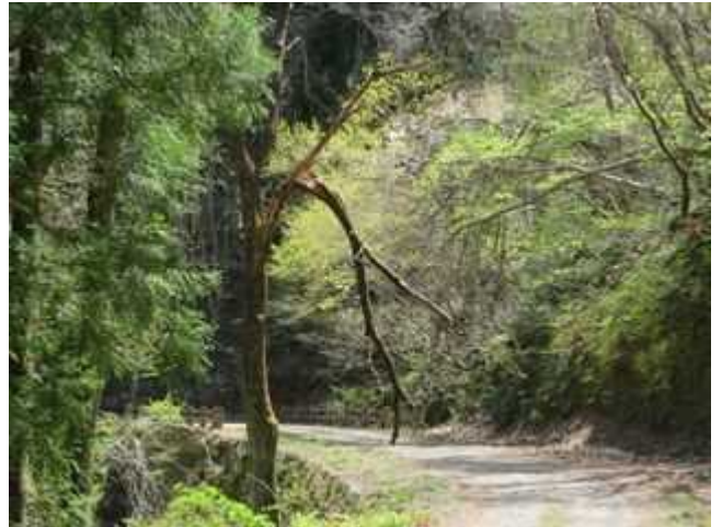
写真 7-2 入イラ澤橋付近からいら沢橋を望む
