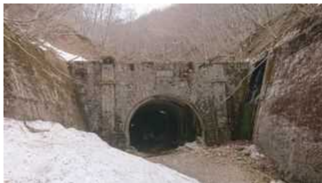
写真 16-1 ニツ小屋隧道米沢側坑口・残雪状況 R030416
