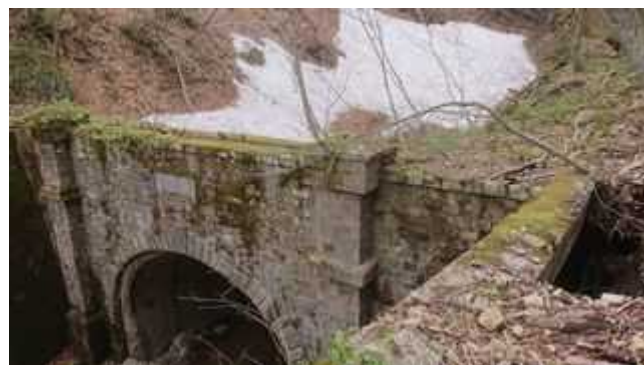
写真 17-2 米沢側坑口の上部の状況。-
