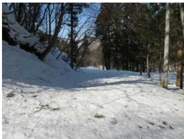
写真 3-4 入イラ澤橋付近から胡桃橋を望む。
