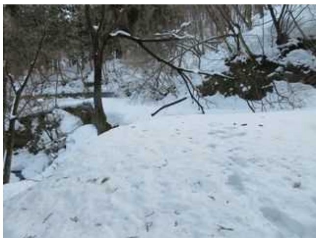
写真 3-2 入イラ澤橋からいら沢橋を望む。
