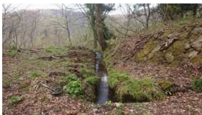
写真 15-1 ニツ小屋隧道福島側の排水溝流末の清掃。
