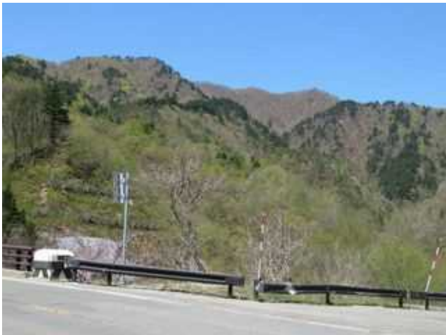
写真 14-1 現国道 13 号西川橋(第 3 代)福島側から望む。 親柱背後が E13 新栗子トンネル福島側坑口。中央奥が西川山。
