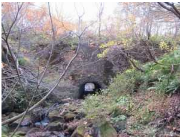
(写真-15⑦) 溝渠下流側全景。
