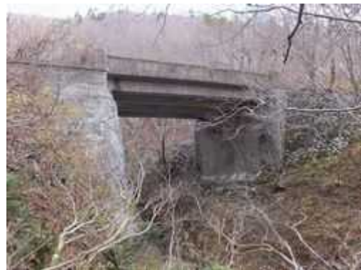
(写真-10⑤) 杭甲橋(鉄筋コンクリート桁橋)。 杭甲沢下流側から望む。 H291105
