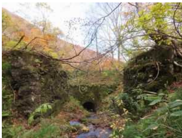
（写真-14③） 上流側から望む。左米沢側橋台。右福島側橋台、 中央は橋梁廃止に伴う代替施設溝渠工（第 3 種溝橋）。
