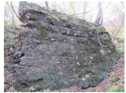
(写真-14⑥) 福島側橋台、正面。
