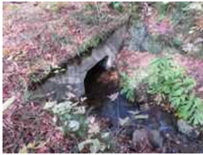
(写真-10②) 昭和の大改修横断水路、呑口。 大平橋から約 150m米沢側。
