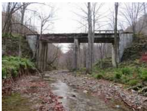
(写真-5⑧) 現橋(第3代)烏川橋、下流から望む。 (L=23.3m、W=6m S10.6~S11.9) R011104
