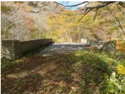
(写真-10④) 杭甲橋(L=-11.7m、W=6m、S11.11 完)。 福島側から望む。
