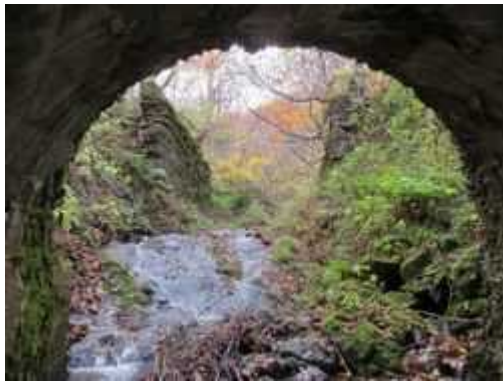
(写真-15③) 溝渠(「昭和の大改修」の正式名称「第3種溝橋」 幅2.24m、高さ1.7m、長さ18.5m)内部から 小杭甲橋遺構橋台を望む。
