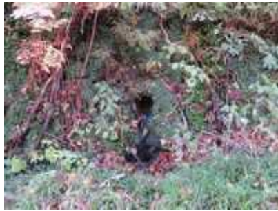
(写真-12⑧) 第5段目道路、石積中間付近。水抜き穴健在。
