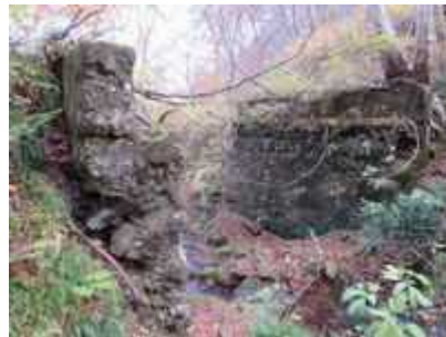
(写真-14⑪) 左米沢側橋台端部(上流側)。 パラペット(上の部分)は全部コンクリートのように見える。
