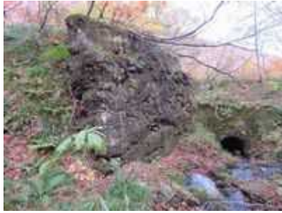
(写真-14⑦) 米沢側橋台、上流から望む。
