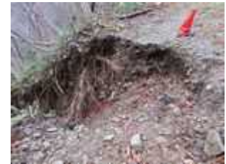
(写真-5③B) 道路崩壊(H28.8.4 豪雨)で不通。
