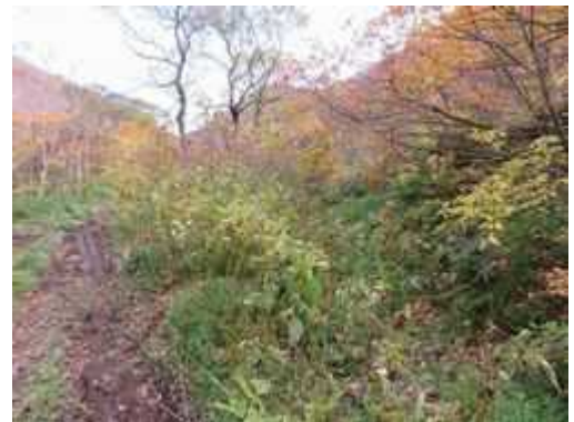
(写真-15①) 右側、初代万世大路跡。写真奥の小杭甲橋から手前約40m、旧工区境付近。左側、旧国道13号。福島側を望む。
