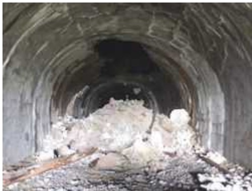
(写真-23③) 米沢側坑口から 100 数十メートル先の崩落箇所を望む。 崩落時期は不明。 H281011
