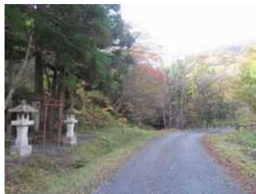
(写真-24②) 福島側(曲がり角付近)から大滝橋を望む。
