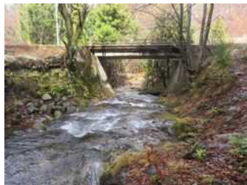
(写真-26 ②) 大滝橋(L=10.6m)、上流側から望む。
