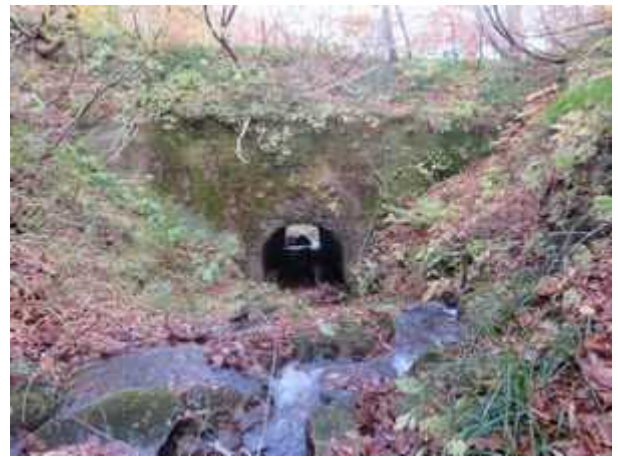
(写真-15②) 溝渠(第3種溝橋)、上流側(呑口)から望む。
