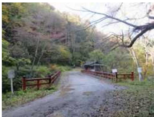
(写真-24①) 葭沢橋を福島側から望む。
