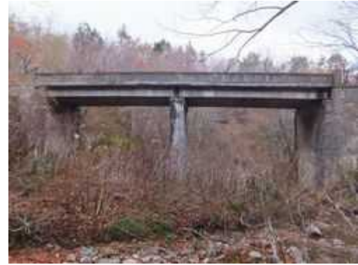
(写真-9⑥) 大平橋(鉄筋コンクリート桁橋)。 杭甲沢(大平沢)上流側から望む。 H291105
