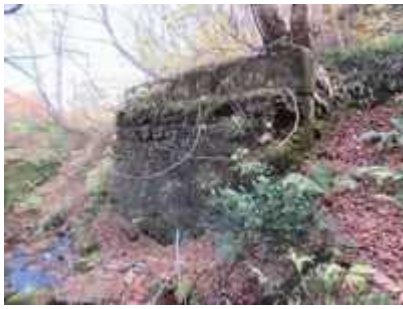
(写真-14④) 福島側橋台、上流から望む。
