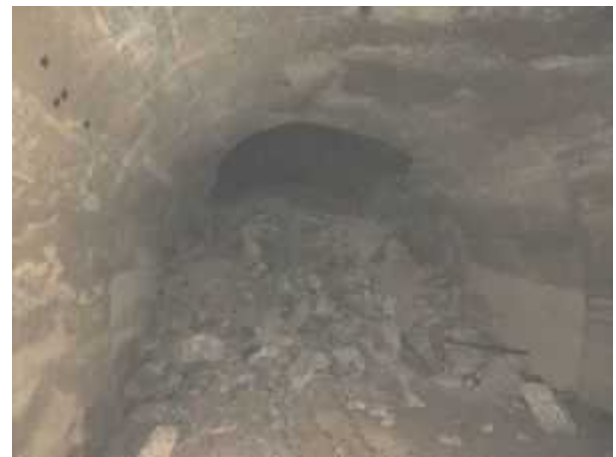
(写真-21⑩) 手前の大崩落箇所、米沢側から望む。 左上の黒点はコウモリ。
