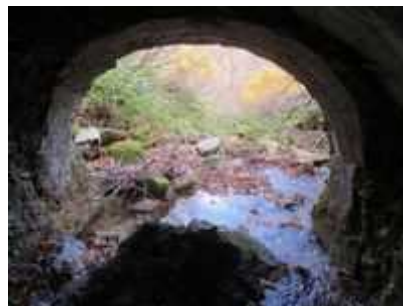
(写真-15⑤) 溝渠下流側(吐き口)を内部から望む。
