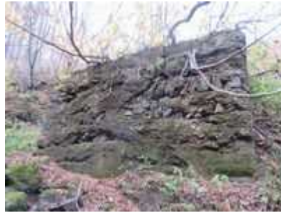
(写真-14⑧) 米沢側橋台、下流から望む。
