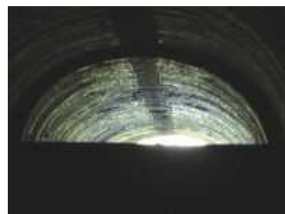
(写真-19 ③) 県界付近から福島側坑口を望む。 黒い水平線は最高点 888.3m(福島側坑口から約 400m)、明治隧道貫通点 (M13.10.19)。 R020529
