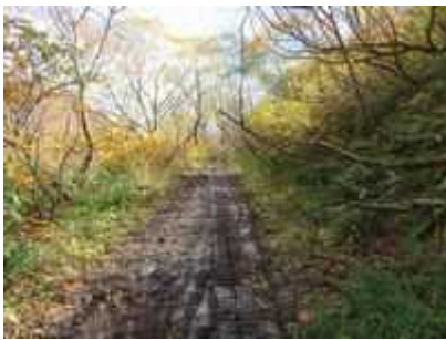
(写真-12⑩) 第6段目道路、福島側(第5号カーブ側)から第6号カーブ方向(米沢側)を望む。
