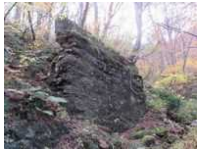
(写真-14⑤) 福島側橋台、下流から望む。
