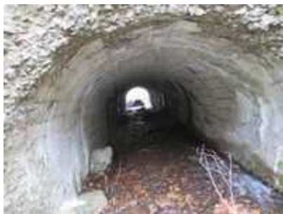
(写真-15④) 溝渠内部を上流側から望む。
