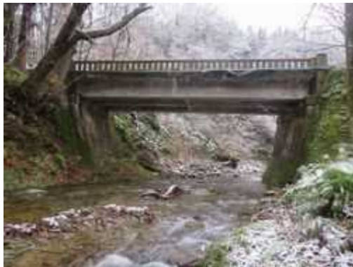
(写真-26 ⑪) 胡桃橋、小川下流側から望む。
