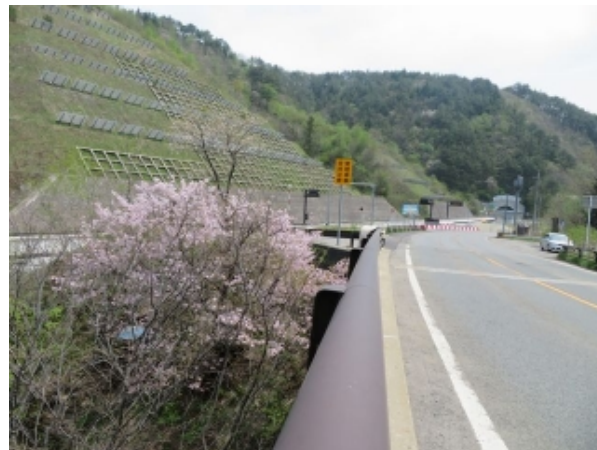
(写真-14 ②) 現道国道 13 号現橋西川橋から福島側(E13 大滝トン ネル)を望む。 左側にシロとピンクの山桜 2 種。
