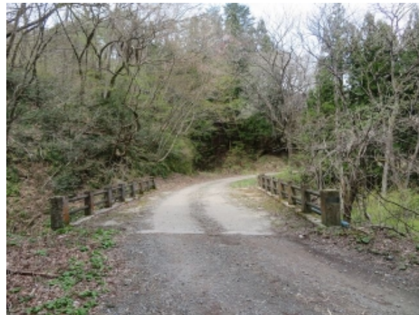
(写真-2④) いら沢橋、米沢側を望む。 020428
