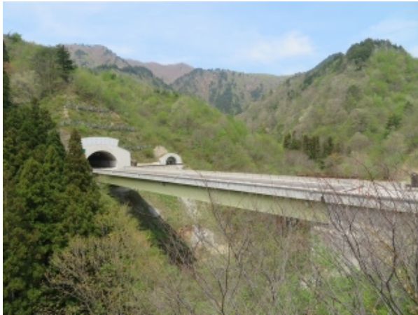
(写真-15③) E13 新栗子トンネル(標高 394m)、右は避難坑。 手前の橋は新西川橋(4代目)。 写真奥西川山。
