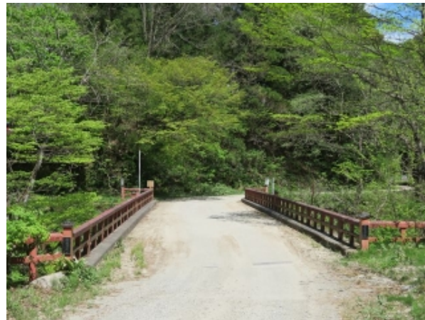
(写真-17②) 葭沢橋、福島側を望む。
