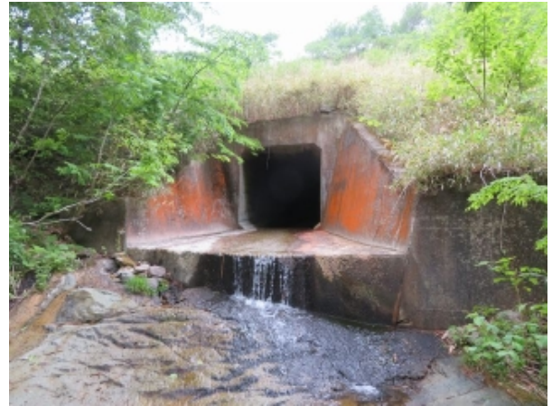
(写真-26④) 新沢カルバート(函渠部)吐口を望む。
