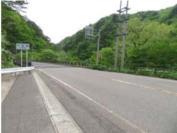
(写真-24①) 国道13号大路橋米沢側、右側下り口。 福島側を望む。
