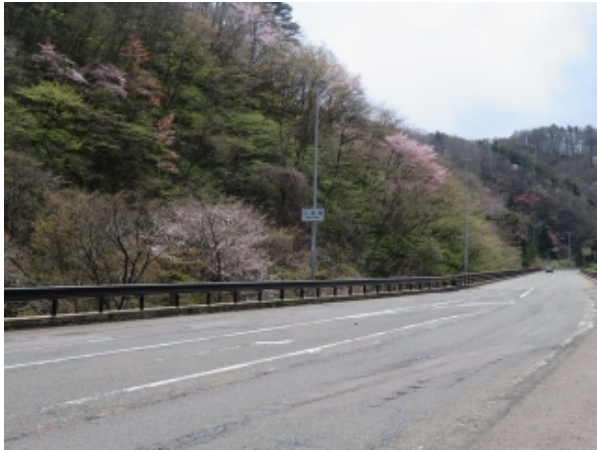
(写真-1①) 大滝集落入口付近。現国道13号・大滝橋手前、 写真右側が入口。山桜花盛り。米沢側を望む。
