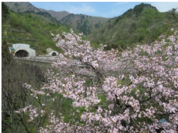
(写真-15①) E13 新栗子トンネル福島側坑口を望む。
