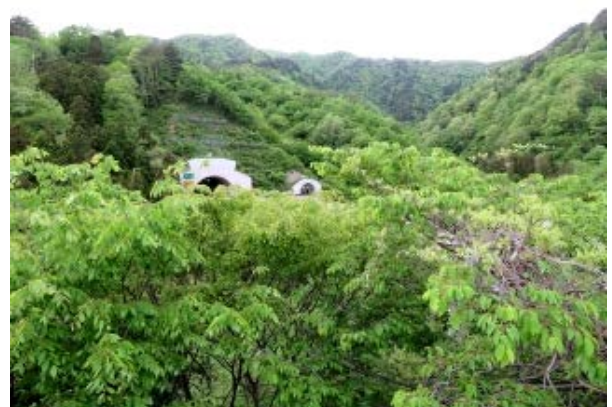
(写真-20②) 5月17日 E13 新栗子トンネル福島側坑口を望 む。山桜に代わって藤の花。
