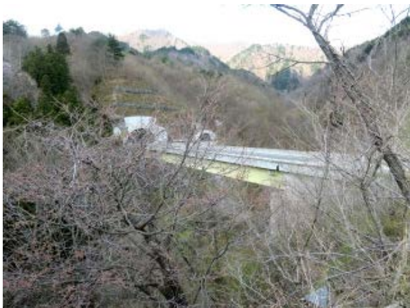
(写真-9①) E13 新栗子トンネル福島側坑口。手前は新西川橋 (4代目西川橋)。 手前の山桜はまだ蕾固い。
