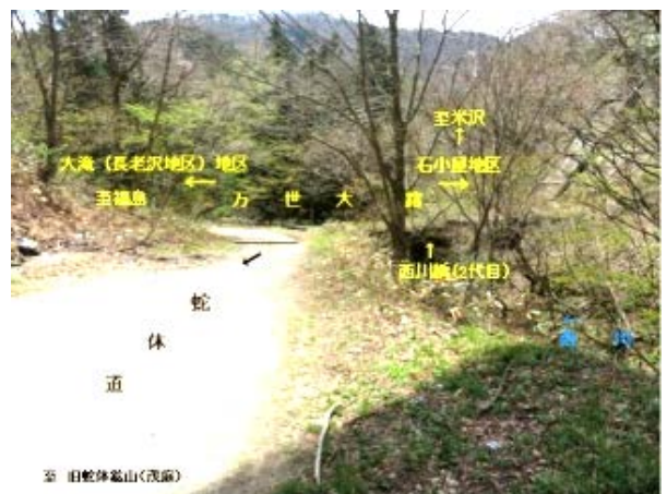
(写真-8②) 蛇体道側から旧万世大路・旧西川橋(右上)を 望む。 西川橋から左側が大滝(長老沢)地区、 右側が石小屋地区。
