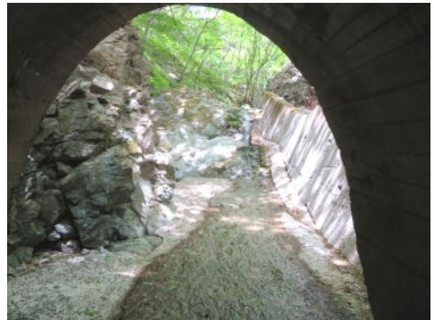
(写真-26②) 新沢カルバート呑口付近から上流部を望む。
