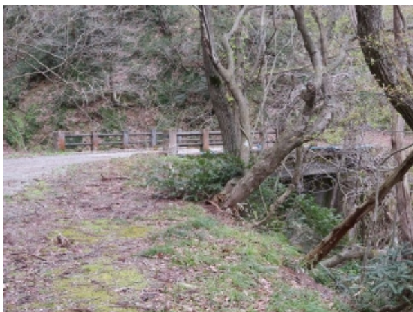
(写真-3③) いら沢橋、福島側から望む。
