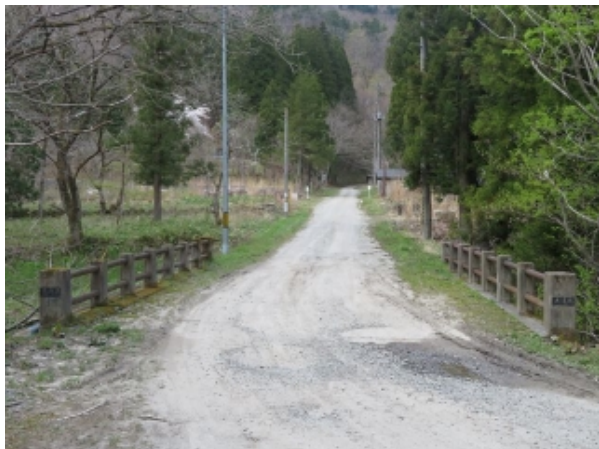
(写真-2①) 大滝橋から米沢側大滝地区を望む。
