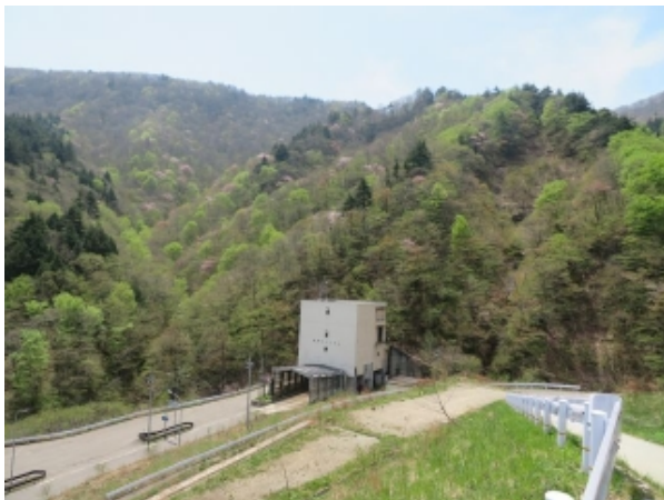
(写真-16①) 東栗子トンネル福島側坑口旧換気所(現在廃止)。 左上入モダ沢。
