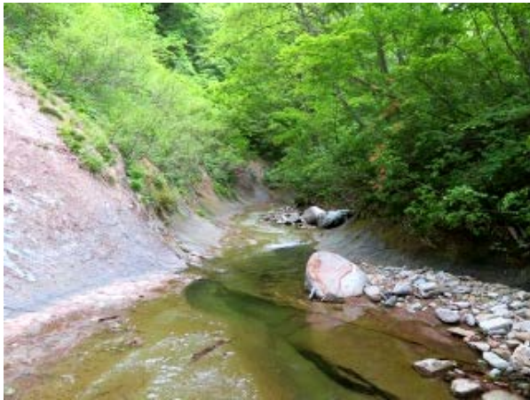
(写真-26⑤) 小川下流側から合流点(新沢カルバート)を望む。 右側、奥の転石箇所。
