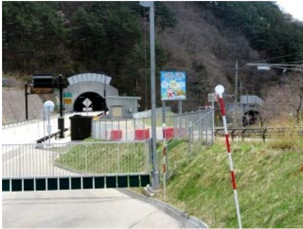
(写真-9③) 新旧大滝トンネル米沢側坑口 (左側 E13 大滝トンネル、 右側国道 13 号大滝第 1 トンネル)
