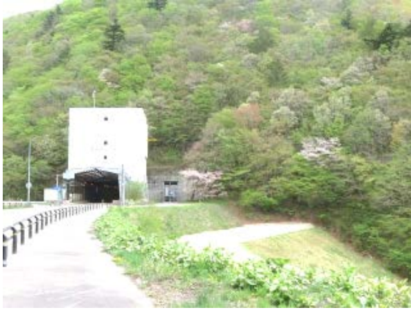
(写真-21①) 東栗子トンネル米沢側坑口、山桜満開。
