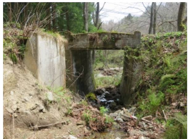
(写真-3④) 入いら沢橋、上流側から望む。
