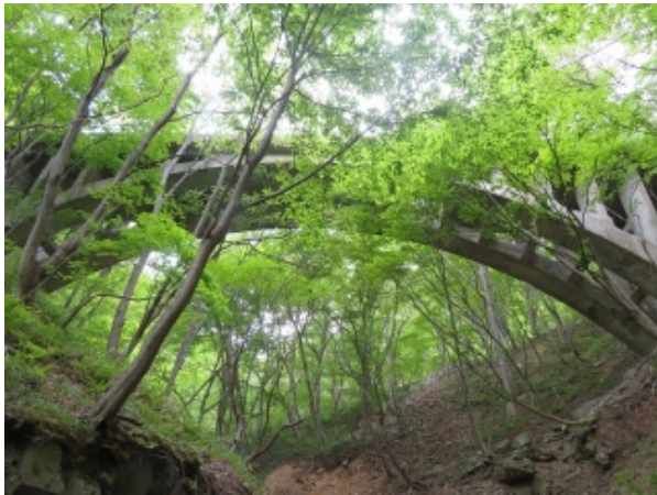
(写真-25③) 新沢橋(第3代)、新沢下流側の沢底から望む。
