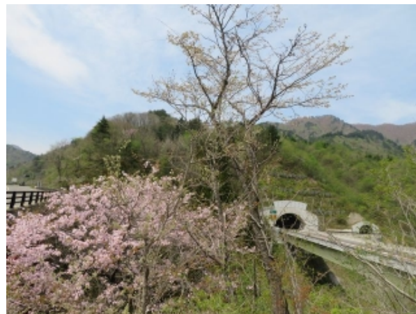
(写真-15②) E13 新栗子トンネル福島側坑口、右側は避難坑。 手前の橋は新西川橋(4 代目)。 左端は現国道 13 号現橋西川橋(3 代目)。
