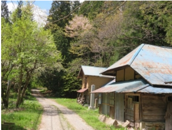
(写真-19③) せとの沢付近から米沢側を望む。 右は大滝御小休所。 上は高野家跡の名残の山桜。
