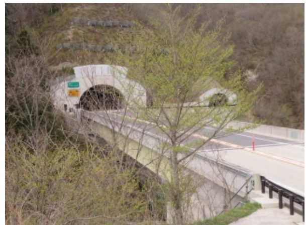
(写真-9②) E13 新栗子トンネル福島側坑口。 右は避難坑。
