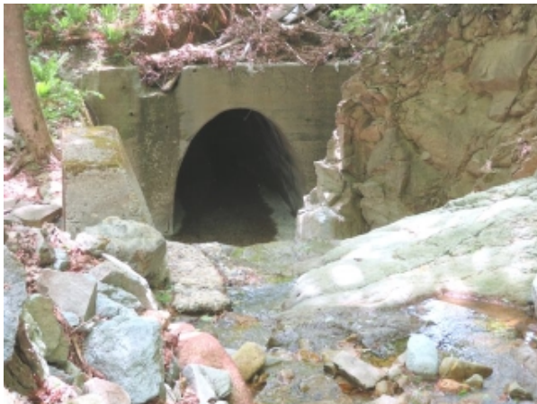
(写真-26①) 新沢カルバート(アーチカルバート部) 呑口。
