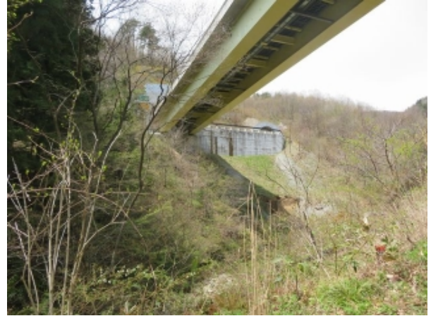
(写真-8④) 蛇体道からE13 新栗子トンネル福島側坑口を望む。 右側は避難坑。 手前の橋はE13 新西川橋(4代目西川橋)
