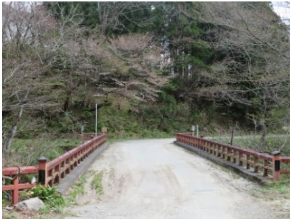
(写真-1③) 葭沢橋、福島側を望む。
