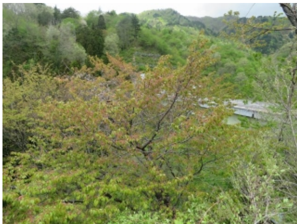
(写真-20①) E13 新栗子トンネル 福島側坑口を望む。
