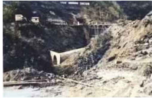
【参考写真 2-6】 工事中の東栗子トンネル福島側坑口(写真中央上)。手前小川に設置された溝渠(暗渠、アーチカルバート)。小川下流側から望む。昭和 38 年 9 月頃。(カラー化)この箇所を通過して「大滝ノ上」「十三滝」方面の炭窯に向う。
