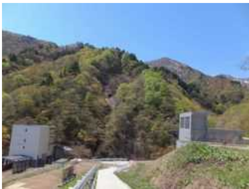
【写真 5-4】 写真右端の奥、葡萄沢山(967.3m)。左側建物、東栗子トンネル(L=2,376m)福島側坑口旧換気塔(現在廃止)。手前は坑口ルーバー(照明緩和区間)。右側建物、E13 新栗子トンネル換気塔。H300426 東栗子トンネルは葡萄沢山の下を通る。
