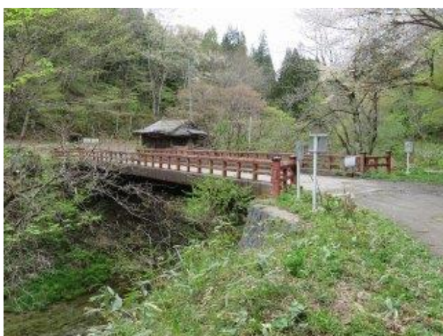
① 葭沢橋、米沢側を望む。
