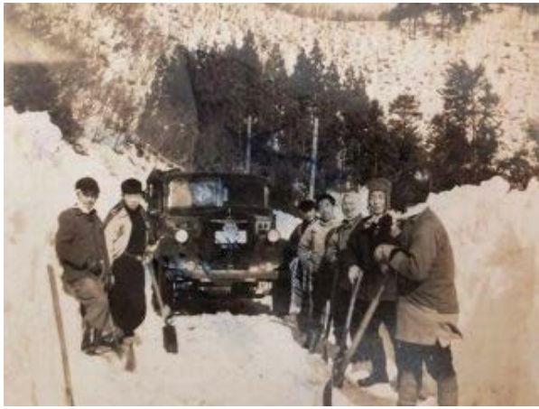
【写真-4①A】 除雪。 木炭出荷のトラック通路確保の為。 旧国道 13 号(旧大鍋橋付近)
