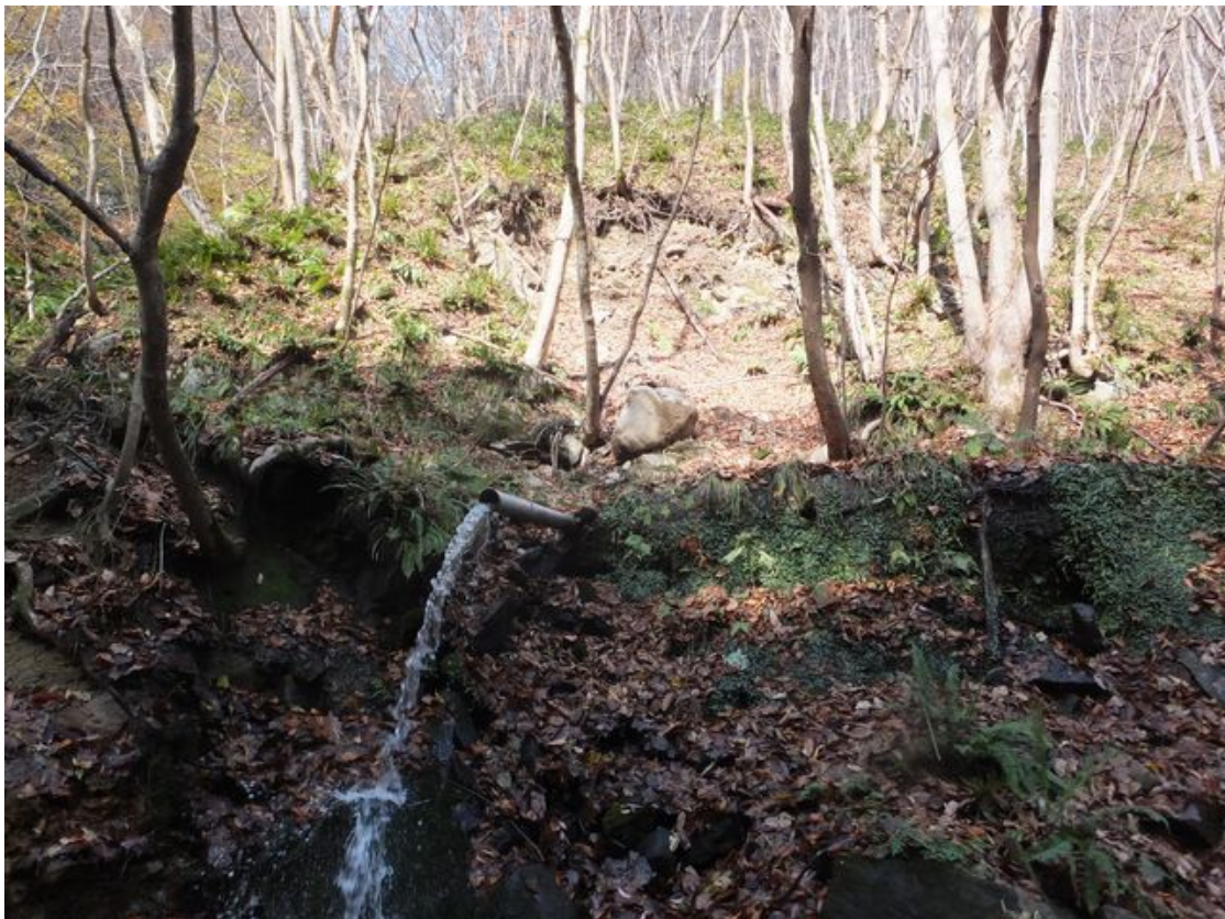
【参考-5③B】 写真中央転石(大石)箇所、閉塞された零番坑(通洞坑)跡。 その下、排水パイプで湧水を処理。 小川河原から望む。
