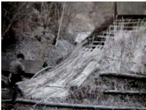
【写真-4③A】 屋根葺き(補修)専門職人、 茅は良質な大平産。
