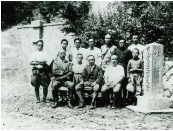
【写真-2①A】 昭和9年、後列右から3番目が佐藤武雄氏。 後の大滝分校教員（在任 S17.4～S28.3）。 当時内務省に委託された作業員賃金支払いの責任者。 前列中央は、内務省技手高橋忠太郎 二ツ小屋出張所主任（所長）。 左上改修された二ツ小屋隧道坑門（福島側）と右側移転された鳳駕駐蹕之蹟（移転時記念写真）。
