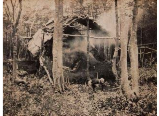
【写真-3②A】炭焼き小屋 木を焚いて窯を乾かしているところ。
