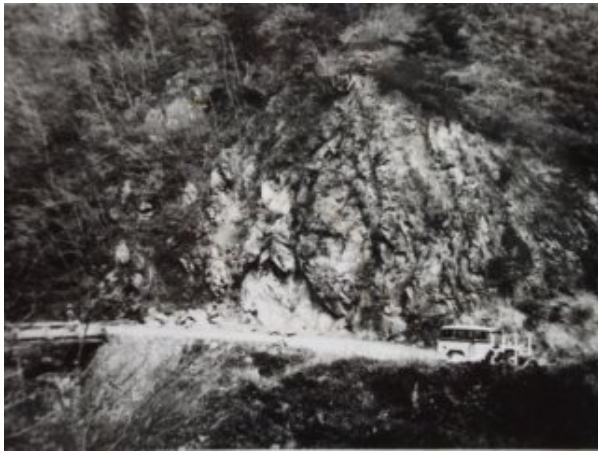
【参考-4①】 昭和 38～39 年度大滝道路改良工事 終点(建設省) 大滝第 2 トンネル米沢側坑口着工前 左旧猪橋、 右側旧国道あゆいまつ方面へ。
