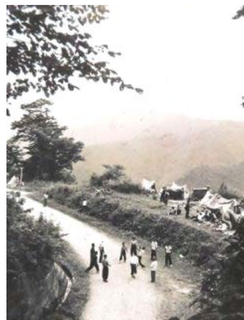
【参考-3②B】 ニツ小屋隧道・福島側坑口 合同キャンプ バレーボールを楽しむ。 昭和31年8月
