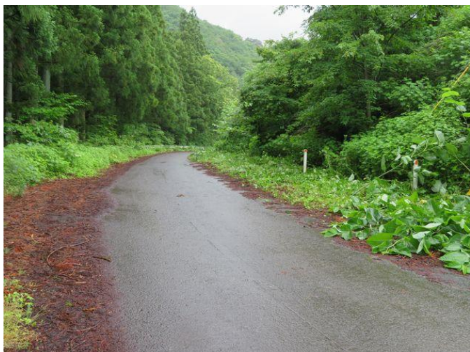
写真-13⑤ 大滝集落入口 国道13号大滝橋 アンダーパス箇所から米沢側 (吉田まんじゅ屋)を望む。 除草後。
