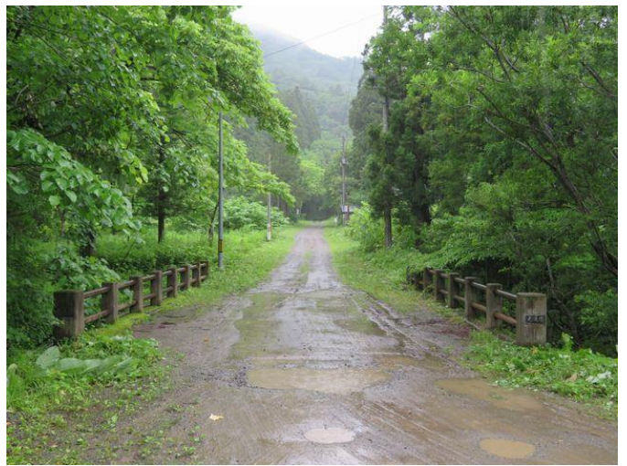
写真-6② 大滝地区、米沢側を望む。除草後。
