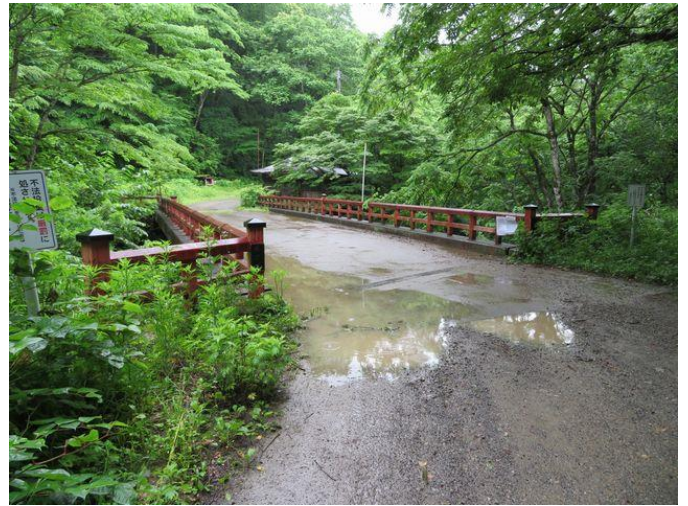
写真-14⑥ 葭沢橋 米沢側を望む。
