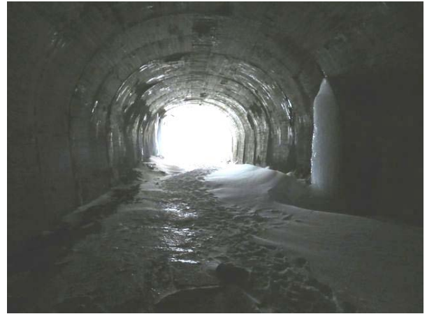
写真 14-3 第 6 号内巻(米沢側坑口まで続く約 80m) 米沢寄りから米沢側を望む。 左奥に坑口部巨大氷柱群が見える。
