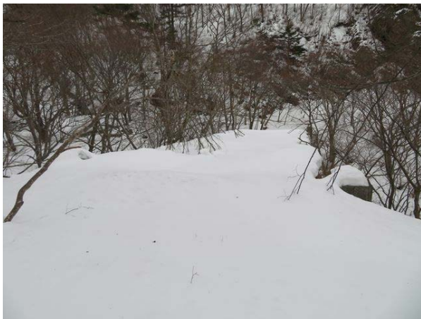
写真 17-4 新沢橋、米沢側から福島側を望む。
