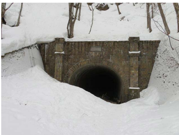
写真 4-1 ニツ小屋隧道福島側坑口到着。
