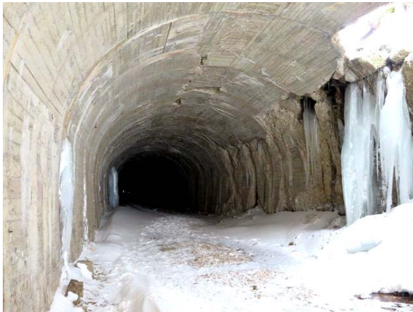
写真 15-2 米沢側坑口から福島側を望む。
