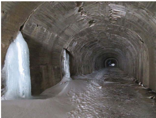
写真 14-2 米沢側坑口から約 100m 付近、第 5 号内巻区間 米沢側端部。中央につらら、氷柱は落下か、 氷塊が散乱。奥に第 4 号内巻区間の米沢側端 部と崩壊箇所をつららが見える。 米沢側から福島側を望む。
