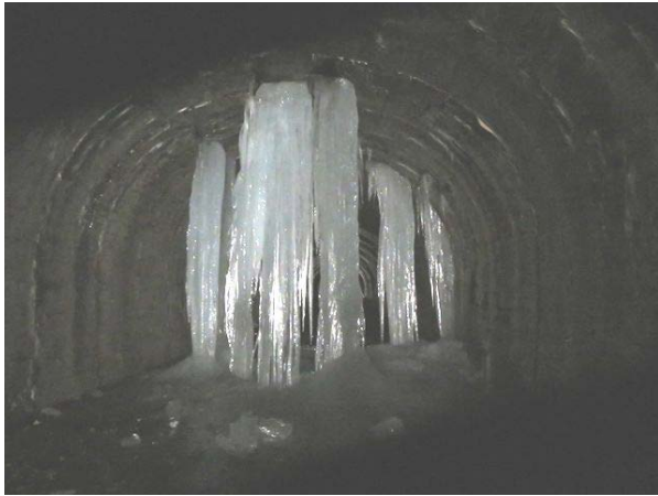
写真 9-1A 巨大氷柱群正面を福島側から望む (第 2 号内巻区間福島寄り)。
