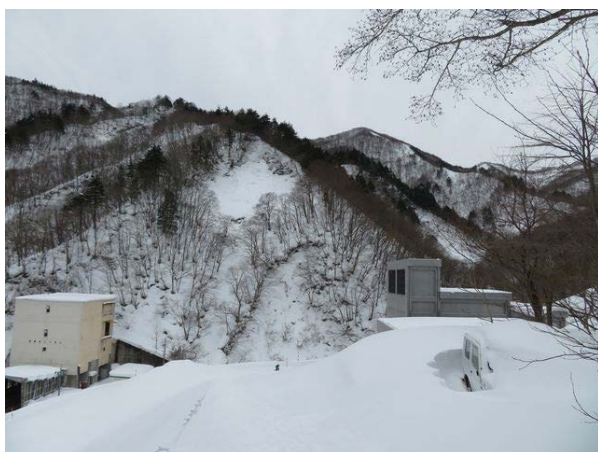
写真 1-3 手前取付坂路、ガードレールが雪に埋もれている。建物は新旧栗子トンネル換気塔。左側 R13 東栗子トンネル旧換気塔（現在廃止）、右側 E13 新栗子トンネル用、稼働中。右奥の山は葡萄沢山（直下が東栗子 T u）
