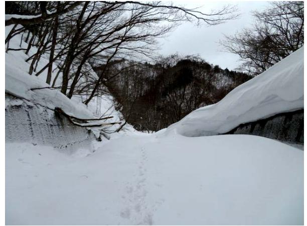
写真 16-2 坑口から米沢側を望む。 雪庇が発達しているのが分かる。
