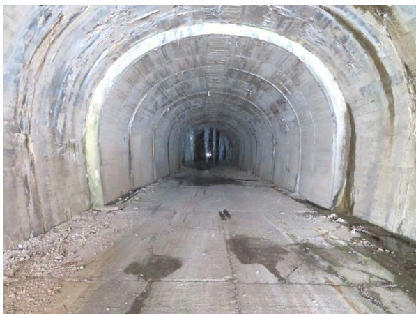
写真 5-1 福島側坑口から奥(米沢側)を望む。覆工段差は第 1 号内巻部。
