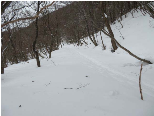
写真 3-5 ニツ小屋隧道前旧国道に到達。明治の七曲坂 第 6 号カーブ付近。第 7 段目道路(旧国道に 改修)、米沢側、隧道方向を望む。
