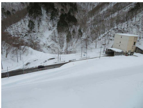
写真 1-1 国道 13 号東栗子トンネル福島側坑口、右側建物旧換気塔（現在廃止）。左側非常駐車帯、手前 E13（東北中央自動車道）新栗子トンネル換気塔管理用通路。
