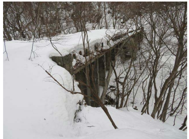
写真 17-5 雪の新沢橋(第3代)。 新沢右岸(米沢側)下流側から望む。
