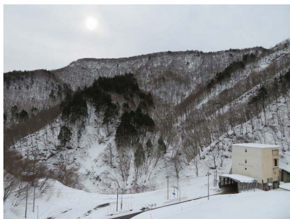
写真 1-4 連絡道路（旧工事用道路）から小川（国道 13 号）対岸のモダ沢地区を望む。峰の右側の反対側に“幻の大滝”がある。建物は旧換気塔。
