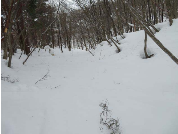
写真 2-5 旧国道 13 号到着、米沢側を望む(昭和の大改修で新設されたバイパス部起点付近)。右上明治の七曲坂第 1 号カーブ付近。左側にボランティアの小型バックホーが雪に埋もれている。
