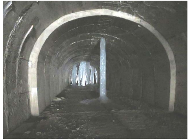
写真 8-2 第 2 号内巻箇所手前(福島側)から米沢側を望む。
