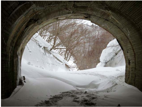
写真 16-1 坑内から米沢側を望む。
