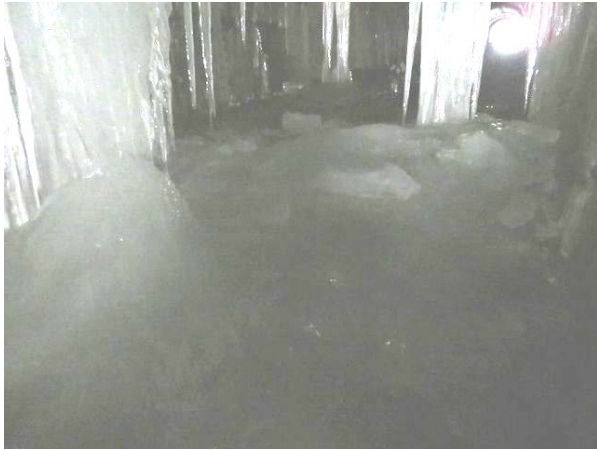
写真 12-5 南側氷柱背面の足元。米沢側から望む。
