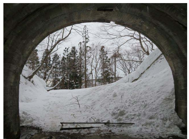
写真 4-2 ニツ小屋隧道福島側、坑口から坑外を望む。
