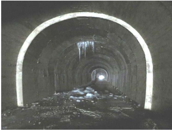
写真 14-2 米沢側坑口から約 100m 付近、第 5 号内巻区間 米沢側端部。中央につらら、氷柱は落下か、 氷塊が散乱。奥に第 4 号内巻区間の米沢側端 部と崩壊箇所をつららが見える。 米沢側から福島側を望む。
