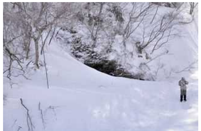
【参考写真No.2】 初代栗子隧道米沢側坑口 【H21.3.15】 おばら様提供
