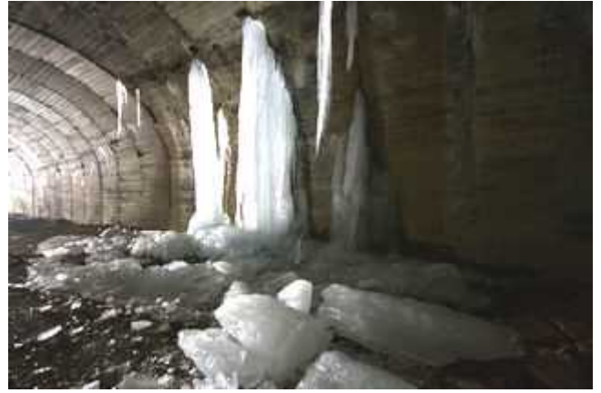
(写真 23・2 - 4) 第 1 号内巻区間(米沢側端部付近)から福島側を望む。
