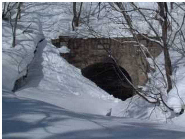
(写真 17・1-1) 福島側坑門。
