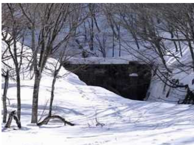
(写真 21・1-2A) 米沢側坑門。
