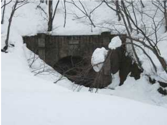
(写真 23・1 - 1A) 福島側坑門
