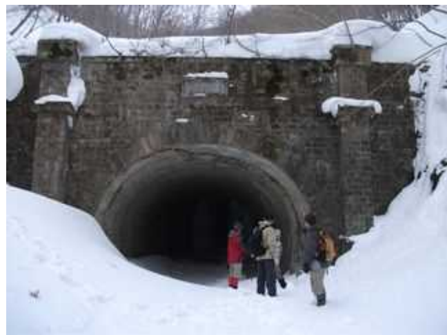
(写真 23・1 - 2 A) 米沢側坑門
