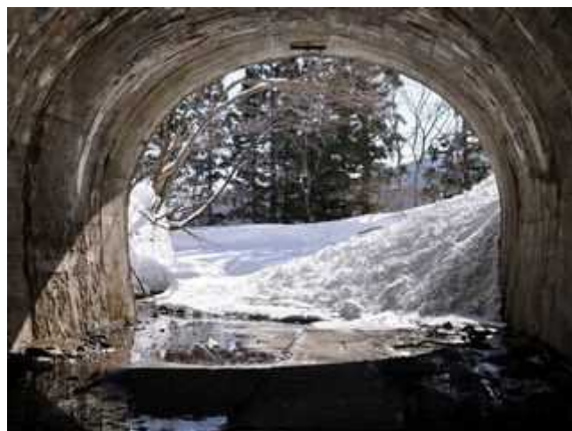
(写真 21・1-1B) 福島側坑口から坑外を望む。
