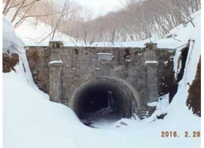
(写真 28・1-1B) 米沢側坑門
