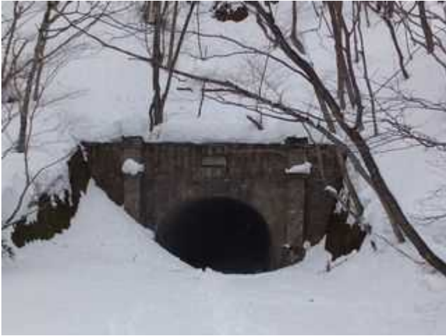
(写真 29・1 - 1A) 福島側坑門
