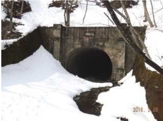
(写真 28・1-1A) 福島側坑門
