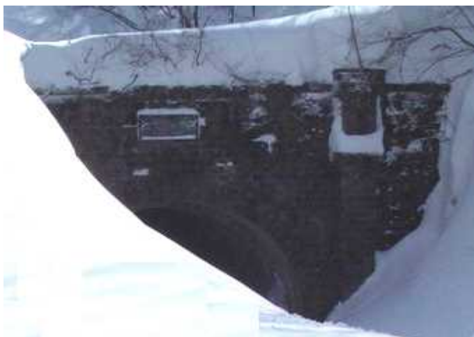
(写真 17・1-2) 米沢側坑門。
