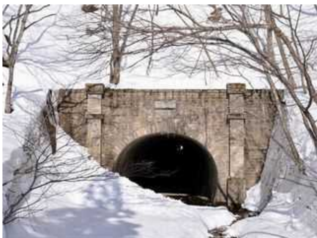
(写真 21・1-1A) 福島側坑門。
