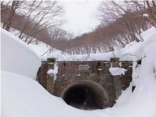
(写真 29・1 - 2 A) 米沢側坑門
