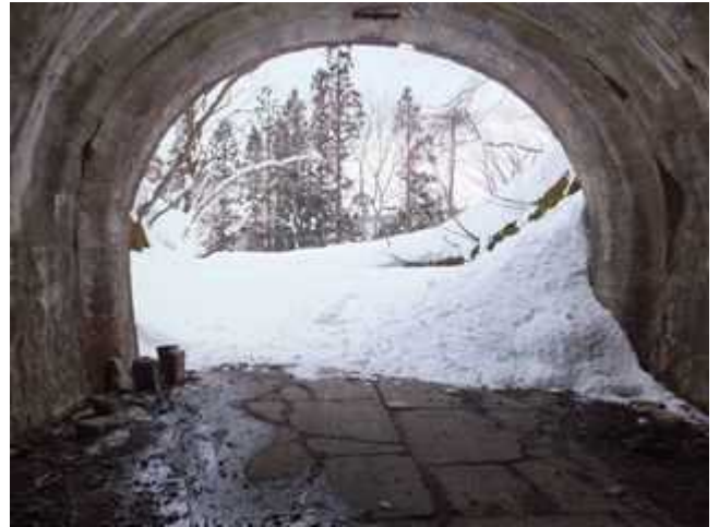
(写真 29・1 - 1B) 福島側坑口から坑外を望む。
