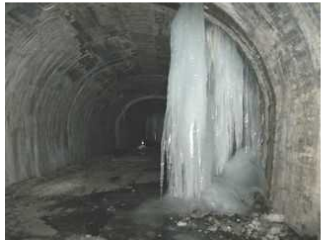
(写真 23・2 - 6) 第 1 号内巻区間米沢側端部(右側)。
