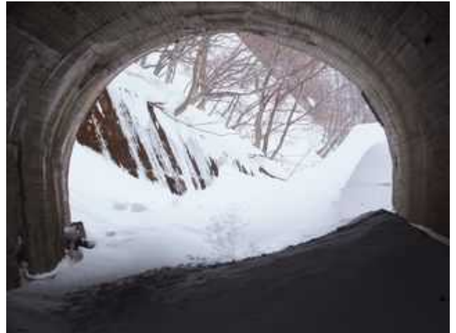
(写真 29・1 - 2 B) 米沢側坑口から坑外を望む。
