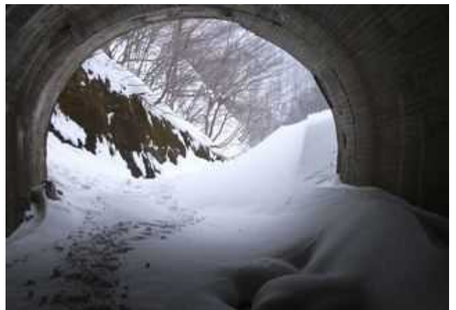
(写真 23・1 - 2 B) 米沢側坑口から坑外を望む。
