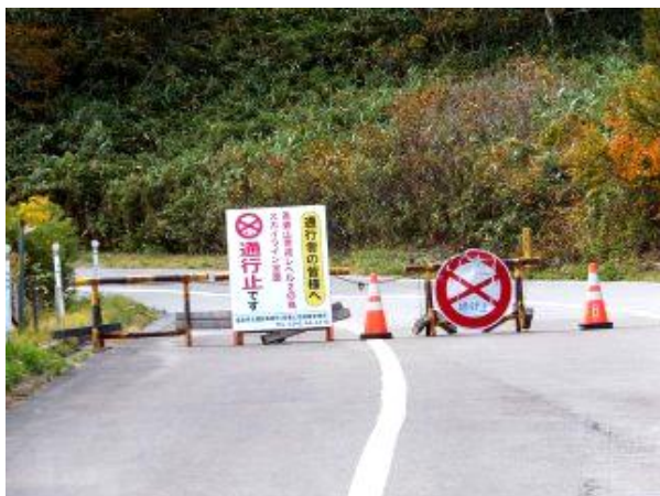
【参考写真-3⑤】 磐梯吾妻スカイライン通行止め (旧高湯ゲート～土湯ゲート L=28.7km) H30.9.15、13:00～(R元年5月31日再開通予定)。 噴火警戒レベル2に伴うもの。(旧土湯ゲート) H301007
