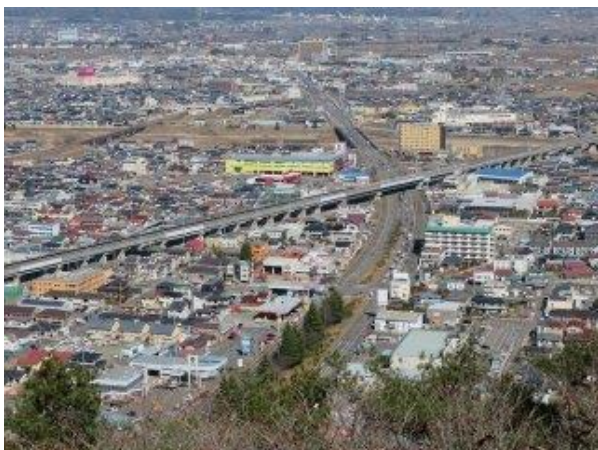
写真-14① 中央、国道 13 号信夫山バイパス、 左上東北本線、斜交東北新幹線、 何れも仙台方向を望む。
