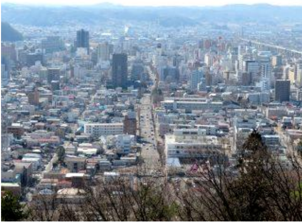
写真一8② 月山連絡道路(仮称)から福島市内(国道13号・信夫通り)を望む。信夫山トンネル直上付近。
