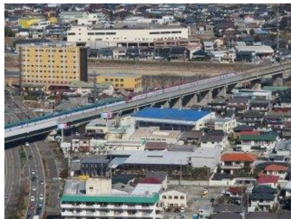
写真-14② 下り新幹線通過、国道 13 号を跨ぐ高架橋。
