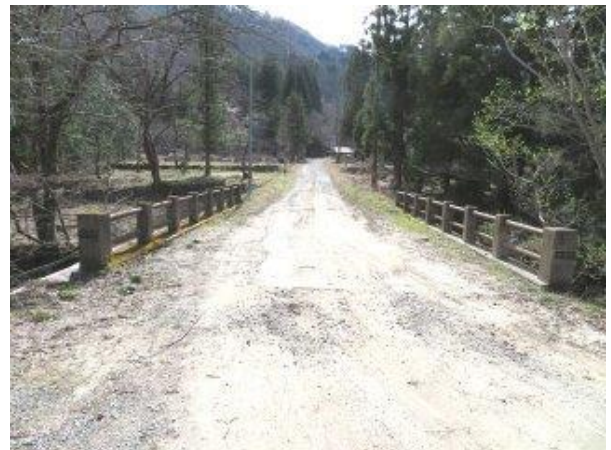
写真-8② 旧大滝橋から大滝地区を望む。
