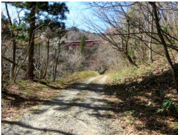
写真-10① 旧高野家物置付近から旧西川橋を望む。赤い橋は国道13号西川橋。
