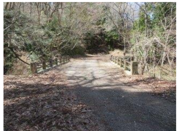
写真-8⑥ いら沢橋
