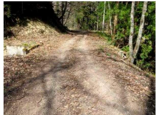
写真-8⑧ 入イラ澤橋、写真奥は胡桃橋。
