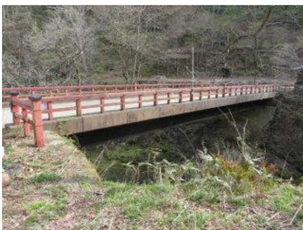
写真-7③ 葭沢橋
