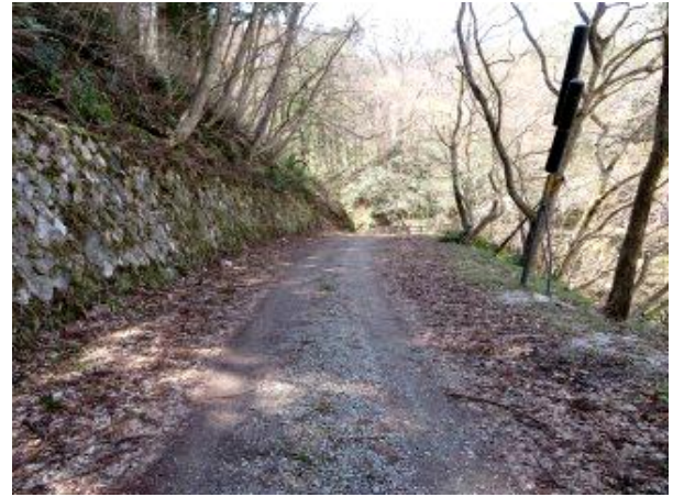
写真-8④ いら沢橋を望む。
