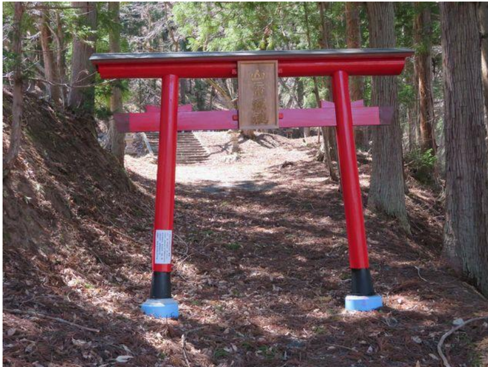
写真-6⑥ 補修の終了した鳥居(H30.10.3)。
