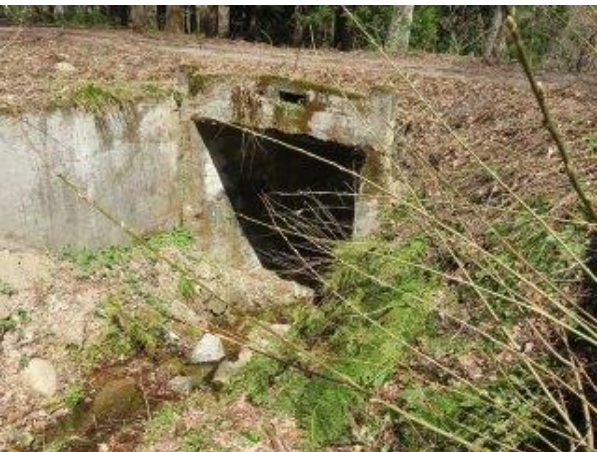
写真-8⑦ 入イラ澤橋
