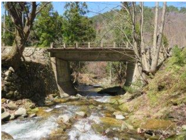
写真-8① 大滝橋
