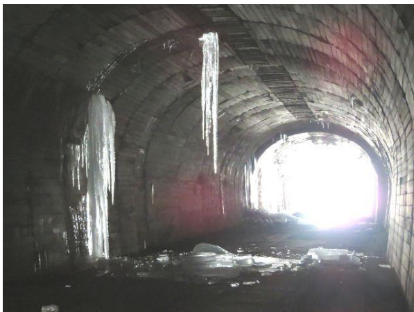
写真-9② 福島側坑口から3番目氷柱群、米沢側から望む。
