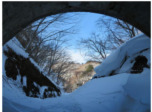
写真-16① ニツ小屋隧道米沢側坑口、坑内から望む。
