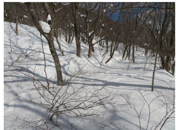
写真-4④ 明治期初代万世大路七曲、5 段目道路福島側を望む。左上、6 段目道路、その上は旧国道 13 号。
