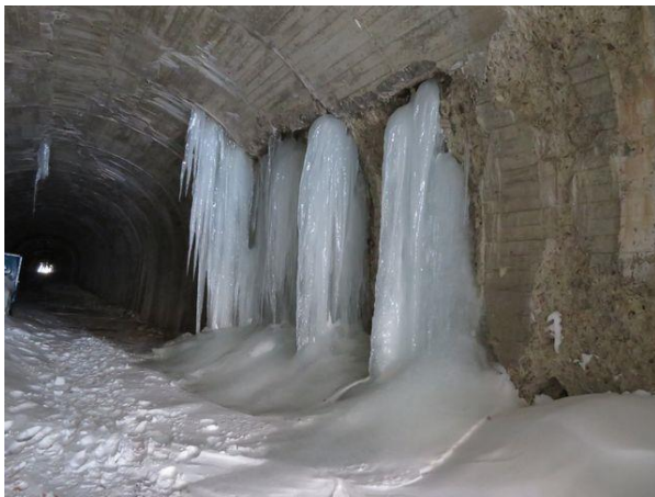
写真-15④ 米沢側坑口付近 巨大氷柱群福島側部分を望む。
