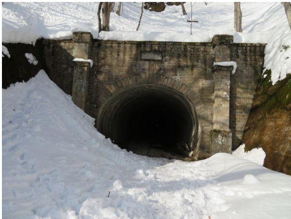
写真-6① ニツ小屋隧道福島側坑口
