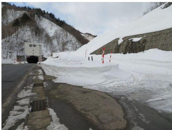
写真-1① 国道13号東栗子トンネル福島側坑口（旧換気塔）と新栗子トンネル換気塔管理用通路（右側）
