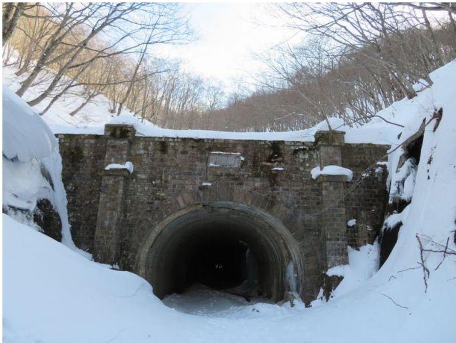
写真-16② ニツ小屋隧道米沢側坑口
