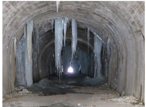
写真-6② ニツ小屋隧道坑内、福島側坑口から望む。
