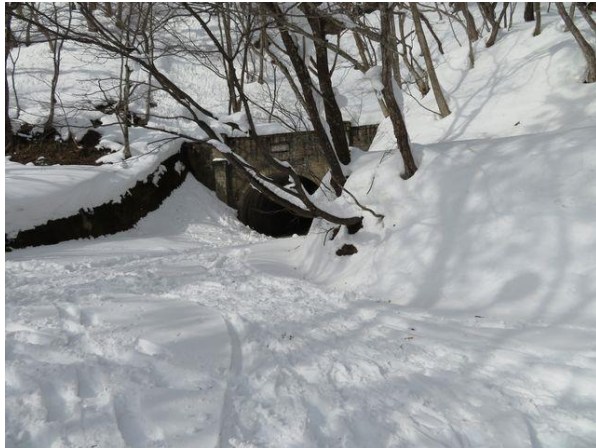
写真-5③ 二ツ小屋隧道到着。
