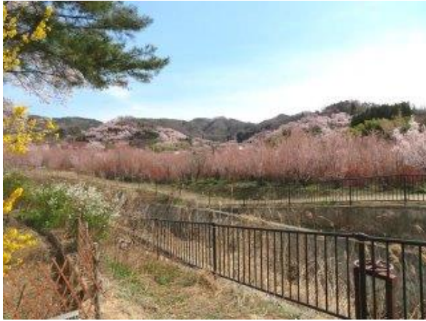
写真-17① 花の谷コース・復路終点駐車場 手前、金畑下橋(かなばたけした ばし・くるみ川)付近から望む。 (花見山全景)H310408
