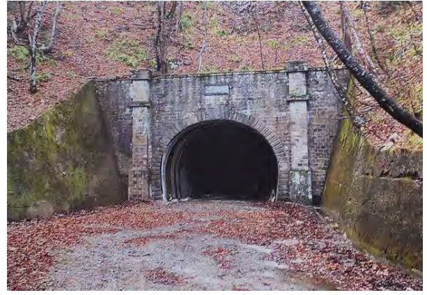
【写真－8①】 作業終了。ニツ小屋隧道福島側坑門 面壁。切石積(コンクリート練積)、 旧隧道内発生品(巻立石)を使用。
