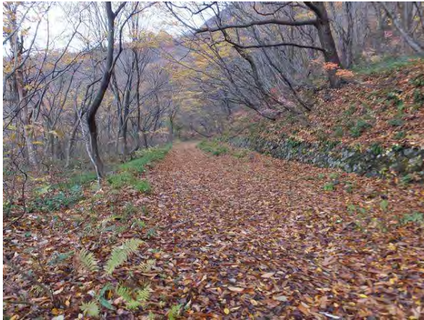
【写真－12②】 「七曲バイパス(仮称)」中間部石積箇所、米沢側から望む。
