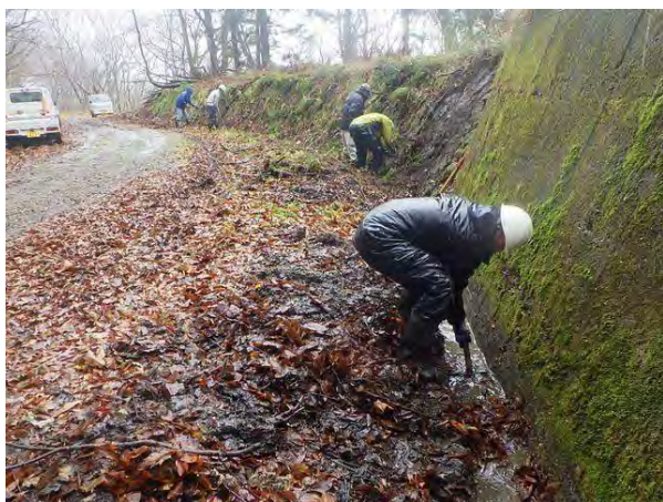
【写真－6④】 隧道前、左側・側溝清掃、 石積美化作業
