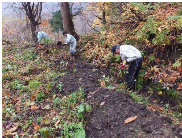
【写真-2①】 隧道前、左側・側溝流末部 清掃作業
