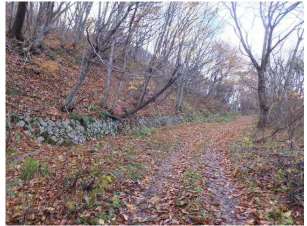
【写真－12①】 昭和の大改修「七曲バイパス(仮称)」中間部石積箇所、福島側から望む。
