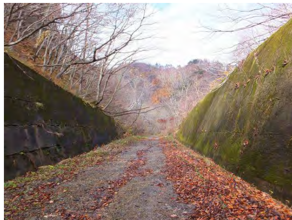
【写真－15②】 ニツ小屋隧道米沢側坑口から米沢側を望む。
