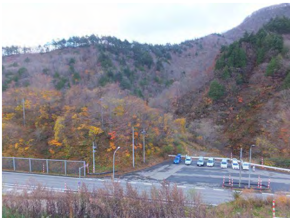
【写真－9 ①】 現国道 13 号東栗子トンネル福島側 駐車帯。取付坂路終点(頂上)付近 から望む。
