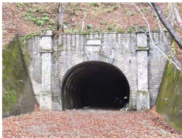
【写真－14③】ニツ小屋隧道福島側坑口
