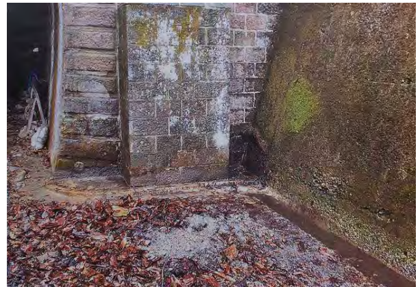
【写真－8③】 拱構(アーチ部) ・門柱基部土台石、出現(右側)
