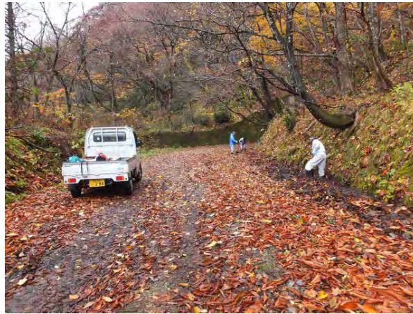
【写真-1②】 隧道前、右側・側溝清掃作業
