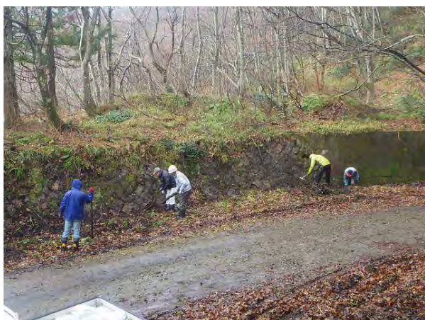
【写真－6②】 隧道前、左側石積美化作業
