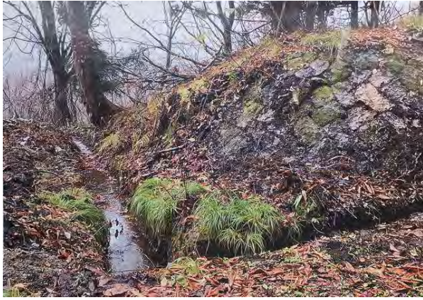
【写真－7②】 清掃完了。 左側袖石積端部と側溝流末部
