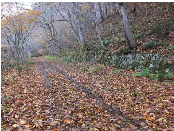
【写真－13①】ニツ小屋隧道福島側の見事な石積（昭和の大改修）、隧道側（米沢側）を望む。
