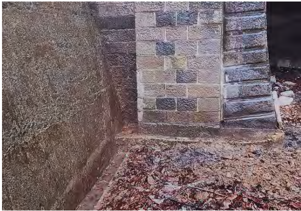
【写真－8②】 拱構(きょうこう:アーチ部) ・門柱基部土台石、出現(左側)。
