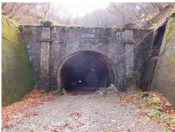
【写真－15①】 ニツ小屋隧道米沢側坑口
