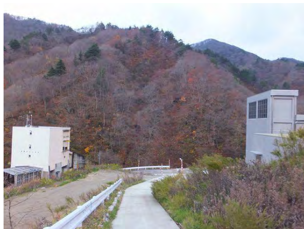
写真－9 ②】 新旧国道連絡路(手前取付坂路部 ・奥管理用通路部)。 建物、左側旧換気塔(東栗子 Tu 用、 現在廃止)・右側塔(E13 新栗子 Tu 用)。 取付坂路終点から望む。
