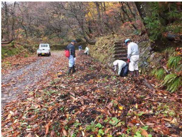
【写真-1①】 隧道前、右側・側溝清掃作業
