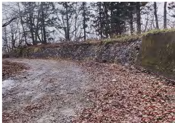
【写真－7①】 清掃美化完了。 二ツ小屋隧道福島側袖石積（左側）。
