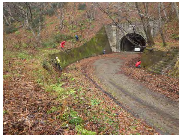
【写真－6①】 隧道前、環境整備・清掃作業
