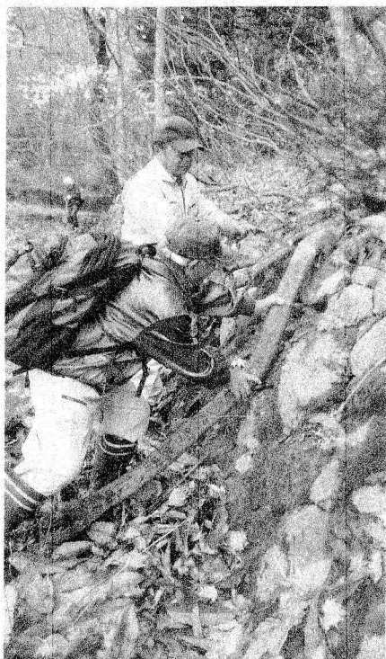
二ツ小屋隧道周辺で行われている整備作業
