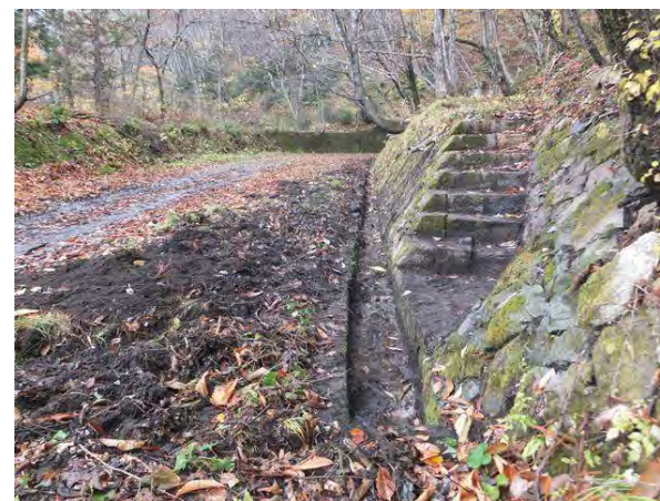
【写真-3①】 側溝清掃終了。「鳳駕駐蹕之蹟」 石碑東側石段。
