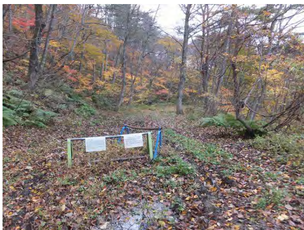
【写真－10①】 連絡路分岐点付近から旧国道 13 号（万世大路）福島側を望む。 明治期万世大路拡幅（盤下げ）区間。
