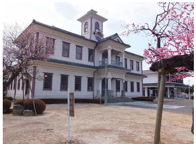
参考写真-5 旧伊達郡役所、明治16年10月完成（三島通庸県令、柴山景綱第2代伊達郡長）。 第5代郡長（M19・9～M22.11）は高木秀明（栗子隧道工事責任者）。国指定重要文化財（S52.6.27）H280323
