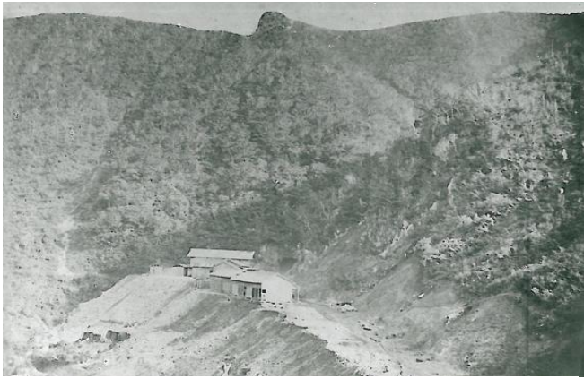
参考写真-4 「南置賜郡栗子隧道 西口(米沢側)。坑口(奥)と行在所(手前)が見える(「菊地新学山形県写真帖」明治14年)山形県立図書館蔵
