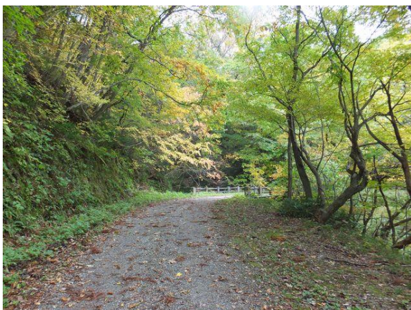
〔写真－4①〕 福島側より「いら沢橋」(L=10.5m)を望む。
