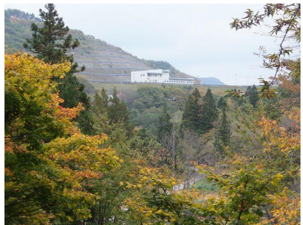
〔写真－3⑥〕 大滝分校跡から東北中央自動車道(E13) 大滝チェーンベース(防災ステーション)を望む。
