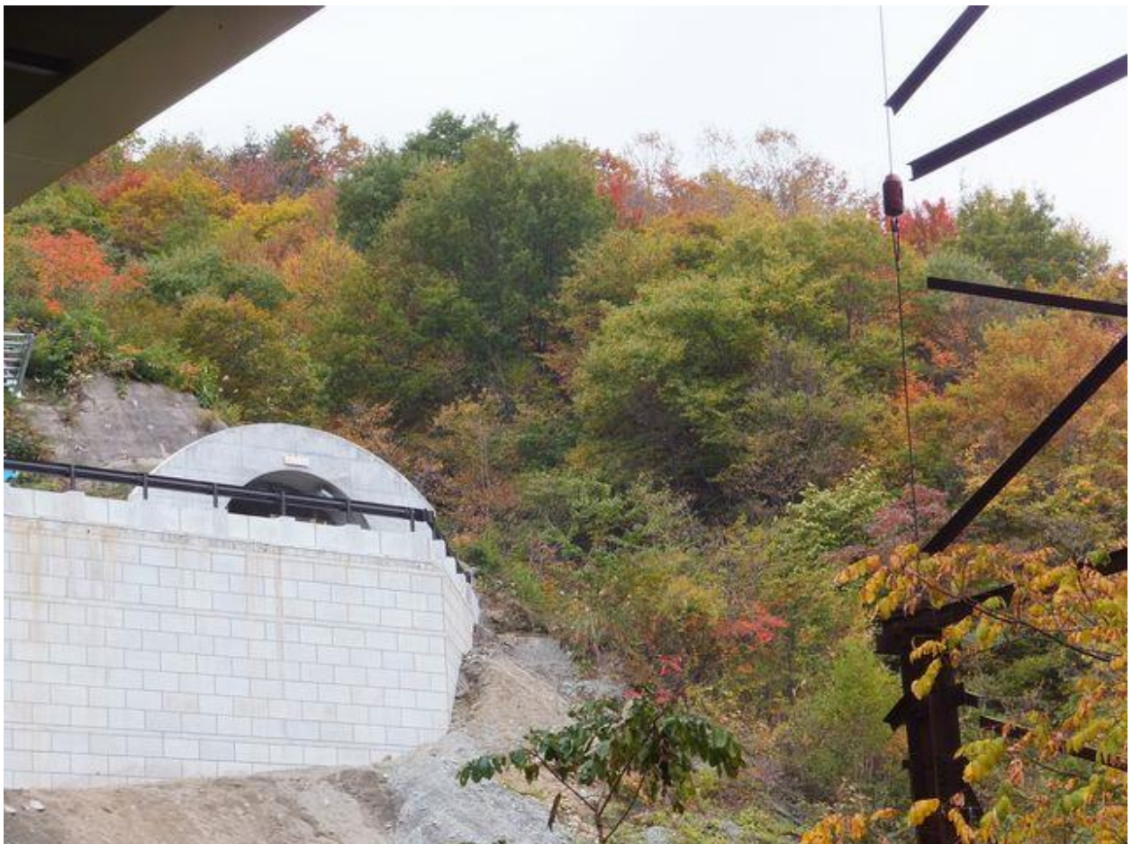
〔写真－6〕 東北中央自動車道（E13）、栗子トンネル避難坑福島側坑口。蛇体道入口（西川橋付近）から望む。
