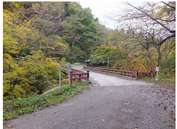
【写真-2①】 大滝集落入口「葭沢橋」(L=22.4m)
