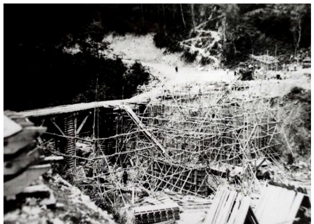
参考写真—11 昭和10年10月頃(推定)、手前は烏川橋橋脚躯体コンクリート打設、奥は米沢側橋台施工中。左側は工事用仮橋、中央上(米沢側)の道路は烏川倉庫への運搬路(工事用道路)。仮橋の上に軌条のようなものが認められる。
