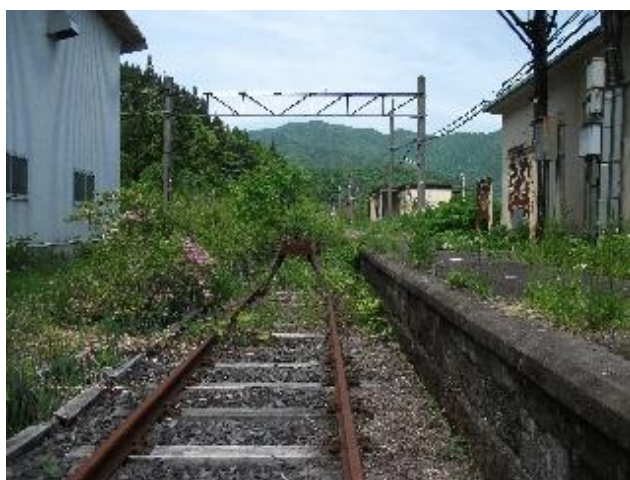
写真—36 旧板谷駅ホーム、中央の建物が駅舎、線路は真っ直ぐ延び小高い丘に達する。中央の高い山は葡萄沢山か。
