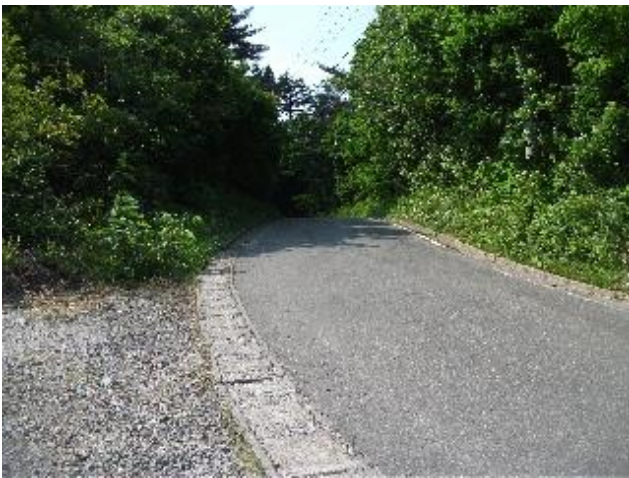
写真一38 旧県道154号頂上(鞍部)付近、板谷側から国道13号方向を望む。
