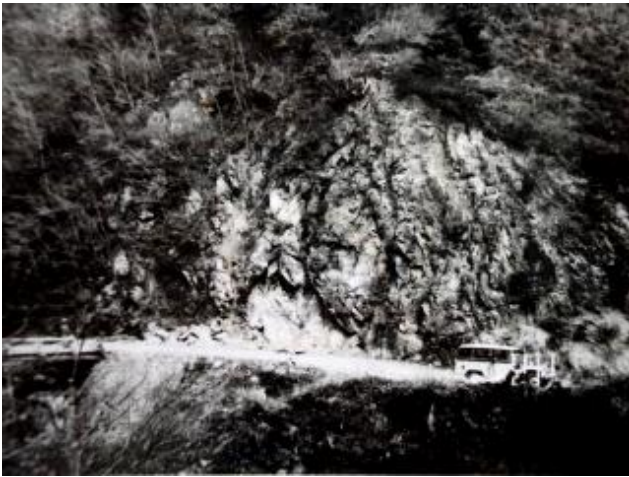
参考写真—19 写真正面大滝第2トンネル米沢側坑口の着工前、旧万世大路左米沢側で、木桁橋旧猪橋が見える。右、大滝集落に至る。
