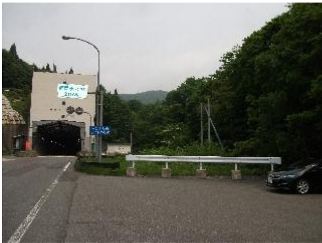
栗子トンネル駐車帯から明通区間起点付近を望む
