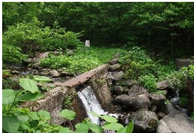
写真—42 取水用ダム（袖ヶ沢本線）、板谷地区への補償工事として設置。
