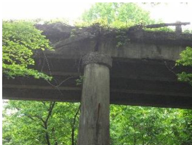
烏川橋下流側、高欄状況
