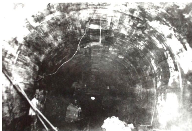
参考写真—12 昭和 9 年 10 月、巻立竣功箇所（福島側坑口から 20 数メートル付近）、中央白丸点は米沢側坑口。切り掛け現場が中央に見える。
