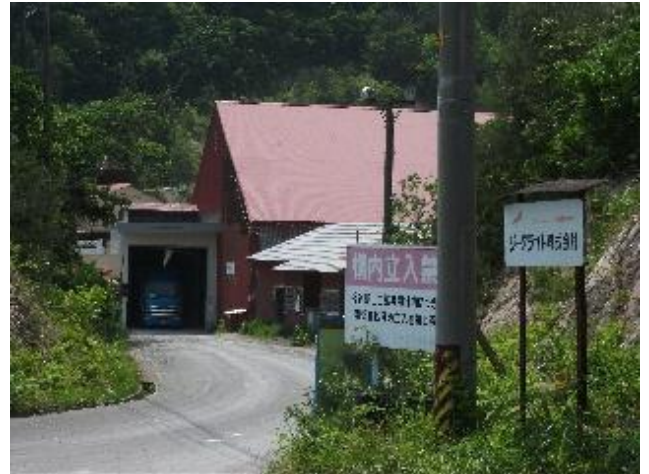
ジークライト工場、旧山形県道 154 号から撮影
