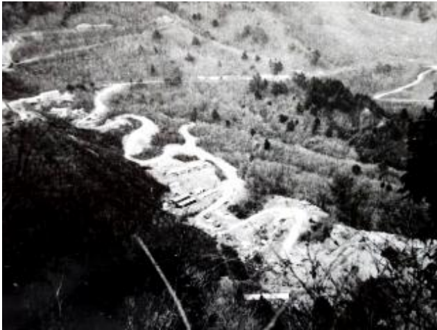
参考写真—17 大滝運搬路、上に旧万世大路が見える。その左側現在のビューポイント、カエル岩(掘削り)も見える。
