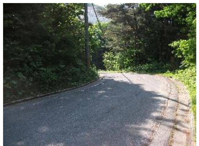
旧県道 154 号、鞍部から国道 13 号方面へ下る
