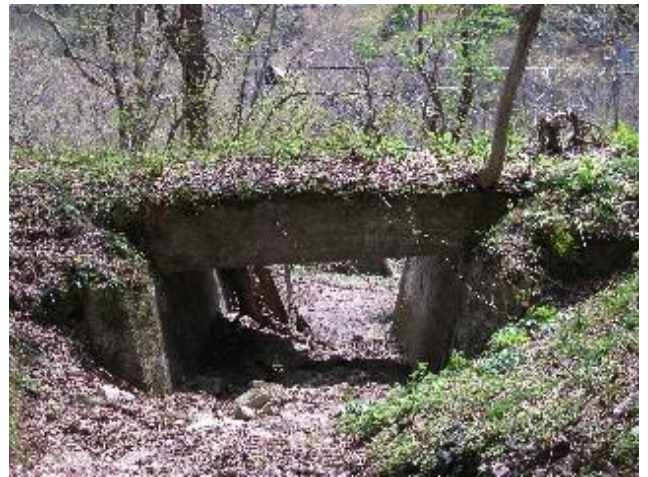
写真—49② 旧日向橋、上流側から望む。拡幅補強されたコンクリート橋部分。左福島側、右米沢側。
