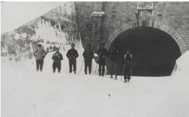
参考写真—24 昭和10年春(4月頃)、ニツ小屋隧道福島側坑口、右から二人目野瀬正人福島国道改良事務所主任(事務所長)、左から二人目星菊助書記(『改修史』編者)
