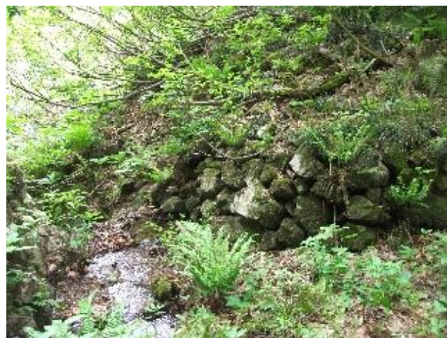
運搬線路仮橋跡、石積橋台(右岸)
