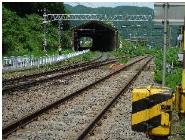
写真—35 旧スイッチバック箇所、現板谷駅側から福島方向を望む。左スノーシェットの奥に旧板谷駅ホーム、右は奥羽本線。
