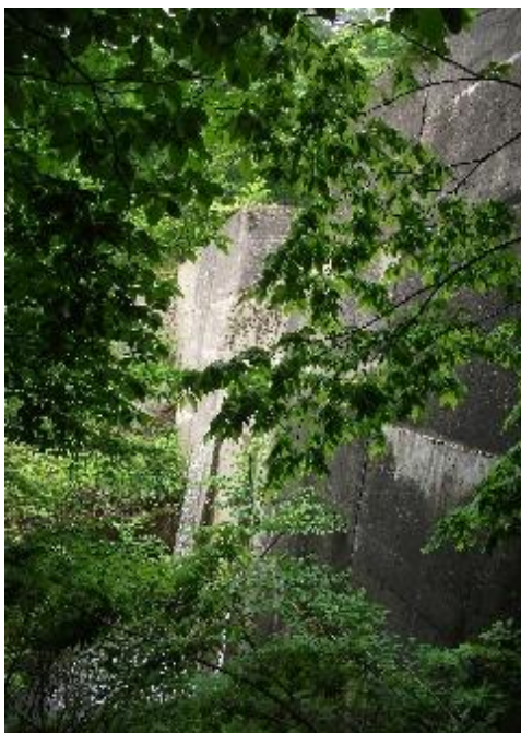
砂防ダム、下流左岸から望む
