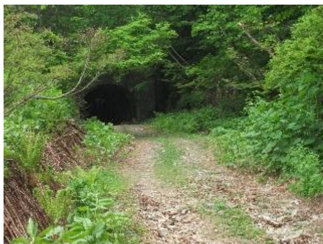
運搬線路、ニツ小屋地区終点(ニツ小屋隧道米沢側)を望む
