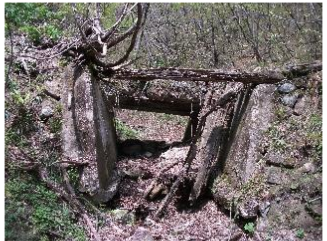
写真—49① 旧日向橋。日向暗隅沢（ヒナタクラスミサワ）に架かる。下流側から望む。上流側（奥）半分がコンクリートスラブ橋、ほとんど落橋している下流側（手前）半分は木造土橋。「栗子国道改築工事」の運搬路としてコンクリート橋部分が拡幅補強されたものと思われる。左米沢側、右福島側。
