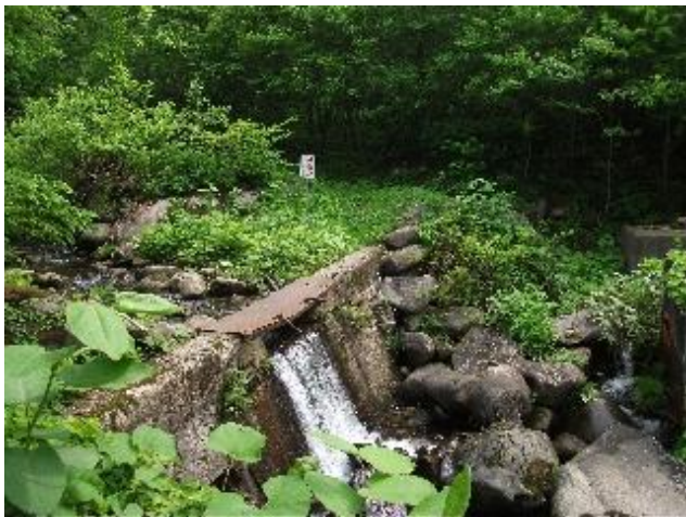
取水用ダム(板谷地区用)、明通区間へ
