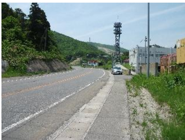
国道 13 号、運搬線路板谷地区、栗子国道出張所付近を福島側から望む。この辺りを運搬線路は走っていたと思われる
