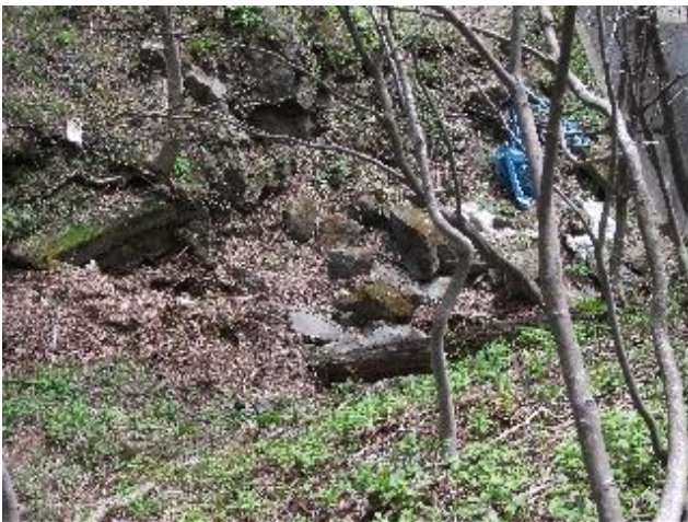
写真—48 旧猪橋、木主桁の残骸が見える。左側は、橋台の一部と思われる。右現国道13号猪沢橋。
