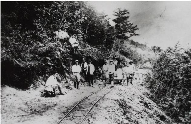
参考写真-8 昭和8年、運搬線路「二ツ小屋区間」烏川右岸、二ツ小屋隧道側から烏川橋方向を望む。軌条は 6 kgレール、材料運搬用のトロッキが見える。
