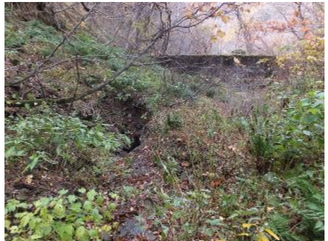
参考写真-39② ニツ小屋隧道米沢側坑門背面全景。左側、沢水が流入する覆工コンクリート崩落箇所。右上は坑門の面壁 H261102
