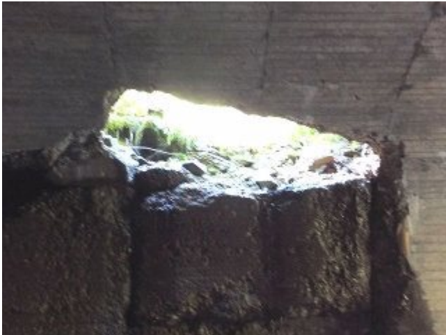
写真-18① 米沢側坑口付近明り巻崩落箇所、今回はほとんど流水がない。増水時について参考写真-39①参照。
