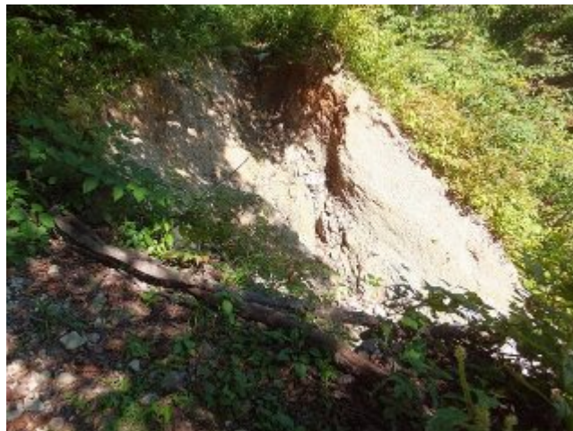
写真-24 烏川橋先（米沢側へ100m箇所）ヘアピンカーブ箇所の崩壊箇所。福島側から米沢側を望む。道路全幅にわたって崩壊。
