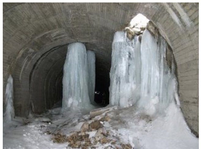
参考写真-39③ 覆工崩壊箇所には巨大氷柱。H230206
