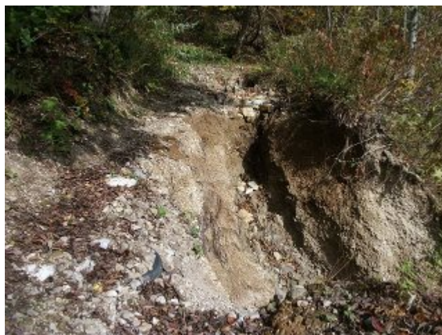
参考写真-52② 烏川橋先のヘアピンカーブ箇所（崩壊後）陥没状況、福島側から望む。①写真の約1年後 H241030
