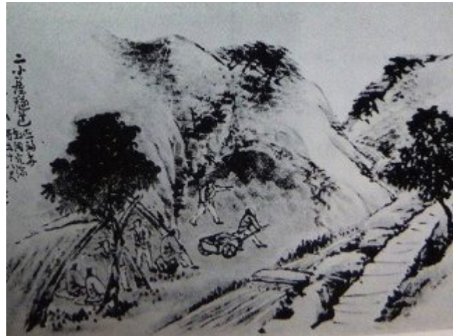
参考写真-36①(再掲) 初代(明治期)二ツ小屋隧道米沢側工事中、右側から沢(仮称白竜沢)が流れ下っている。明治14年7月菅原白龍画。『栗子トンネル工事誌』から転載。
