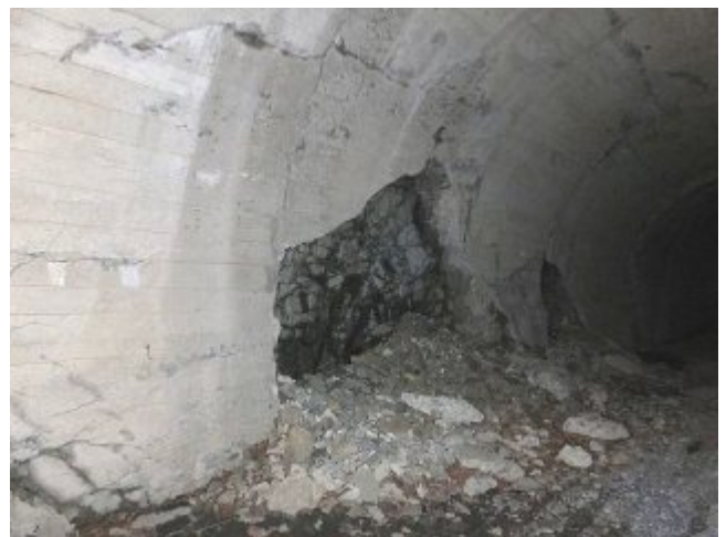
写真-20② 中間点付近左側覆工(巻立コンクリート側壁部)崩壊箇所
