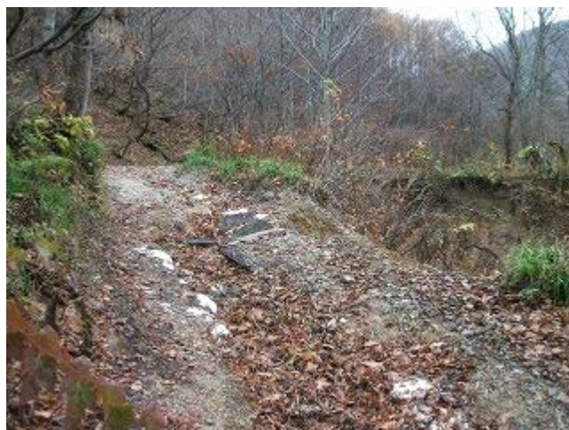
参考写真-52① 烏川橋先のヘアピンカーブ箇所（崩壊前）。当該箇所は以前からの難所で、ご奇様な方がグレーチング（鉄格子側溝蓋、写真中央）等を敷設した。その隣の路肩が僅かに浸食されている。今回の崩落箇所である。H231113
