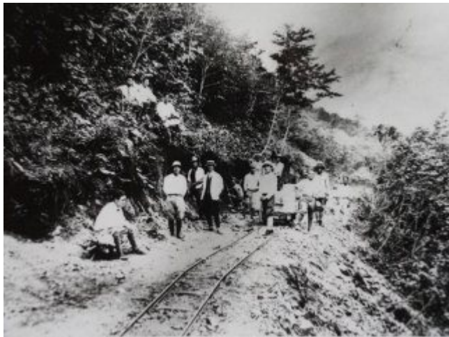
参考写真-27 ニツ小屋隧道(米沢側)～烏川橋間に敷設された材料運搬線路とトロッコ。昭和 8 年 7 月頃
