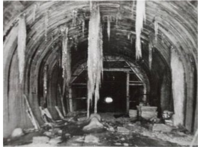
参考写真-31① ニツ小屋隧道補修状況(内巻コンクリート、福島県施工)。昭和28年1月27日撮影
