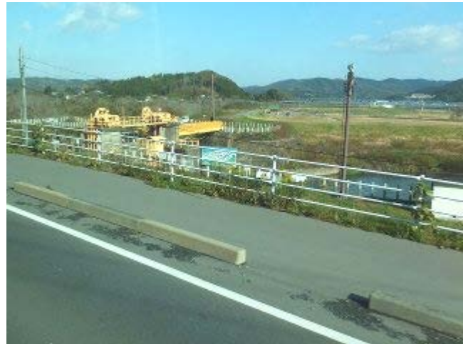
参考写真-26 北上川分流施設群。左端脇屋間門その隣り同洗堰(昭和7年竣工)。左上旧北上川(石巻湾へ)、手前新北上川(追波湾へ)。平成16年(2004年)「選奨土木遺産・北上川分流施設群」。右上鉄道トラス橋 H261110
