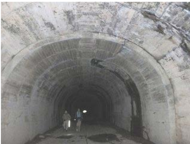
写真-18② 福島側坑口から約55m付近、第2号内巻(巻立コンクリート補修箇所、段差箇所)
