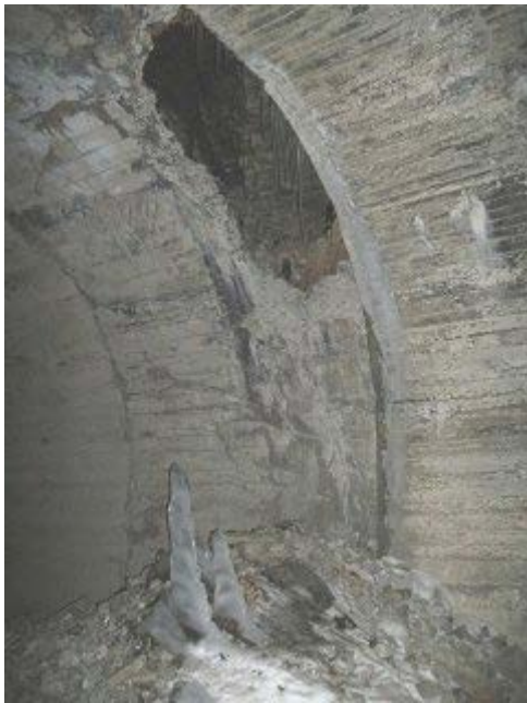
参考写真-34 3年前の崩落状況。水筈も見える。H230206 撮影
