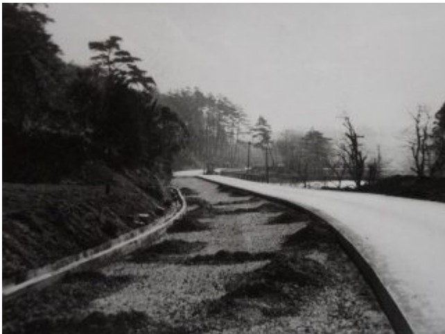
参考写真—45 S33年度国道4号「福島道路舗装工事」コンクリート舗装施工中(建設省直営)。安達郡安達村(現二本松市)渋川地内、昭和34年2月
