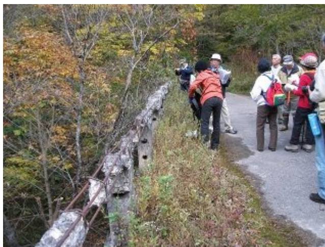
参考写真-49② 崩壊している烏川橋高欄(上流側)、笠木部分の損傷が激しくコンクリート部分がなくなっている。支柱に見える穴は中棧(鑄鉄ガス管)撤去跡=戦時供出。 H241030
