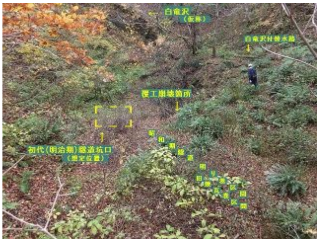
参考写真-38 ニツ小屋隧道米沢側坑門背面・明り巻部全景。人物が覆工崩落箇所を覗いている。頭の上に見えるのが白竜沢付替水路。坑門付近から望む。H261102
