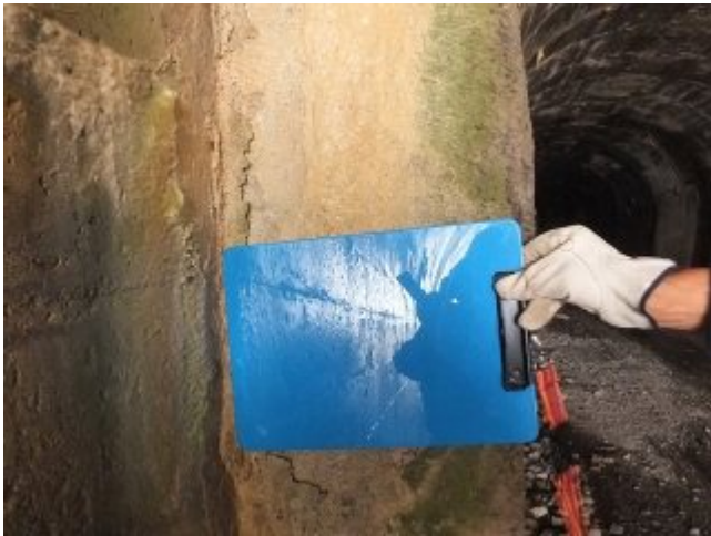
参考写真-32 ニツ小屋隧道第1号内巻(仮称)、厚さ30cm(クリップボード幅32cm)。 H261102
