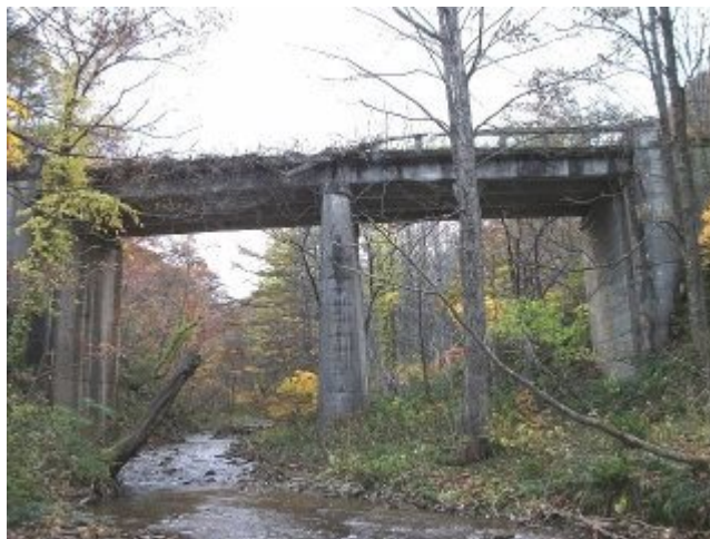
参考写真-49① 烏川橋、烏川下流側から望む。高欄崩壊(中棧の鑄鉄製ガス管は戦時供出)。左福島側(右岸)、右米沢側(左岸) H221104
