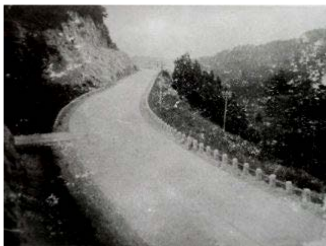
参考写真-43① S12、旧国道4号信夫郡杉妻村(現福島市)伏拝地区「杉妻第二道路」コンクリート舗装工事終了(S11改良済み)。現在の伏拝交差点北側200m付近。路側は鉄筋コンクリート(柱)駒止(ガードレールの前身)。昭和40年にガードレールに設置替え。
