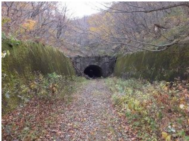
参考写真-40 ニツ小屋隧道米沢側坑口全景。完成後約80年後の姿。参考写真-37参照。H261102
