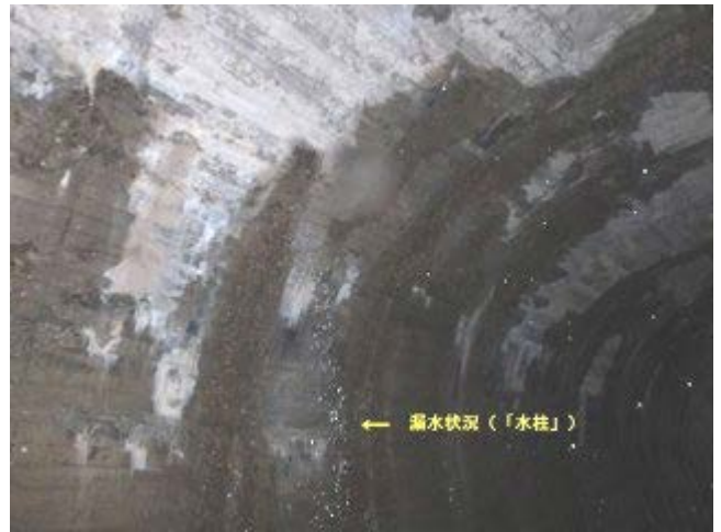
参考写真-33 ニツ小屋隧道 福島側坑口付近 吹き出している漏水。完成後の漏水は「氷柱」だったと云うからもって規模が大きかったであろう。 H251027
