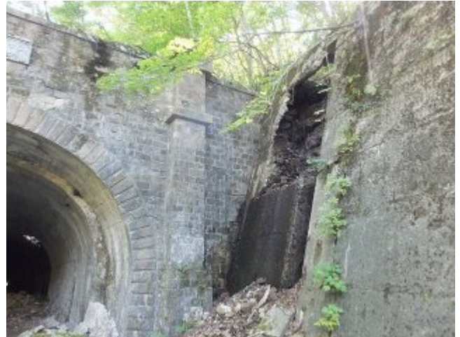
写真-21 米沢側坑口。内巻補修コンクリート剥落、明巻崩落（左側）、坑口袖擁壁の崩壊等の崩落状況
