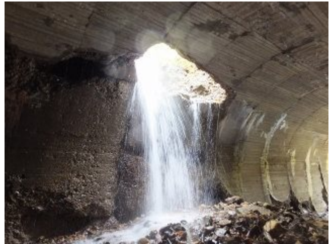
参考写真-39① 覆工崩壊箇所から流れ落ちる沢流(白竜沢流末)。福島側から米沢側を望む。H251027
