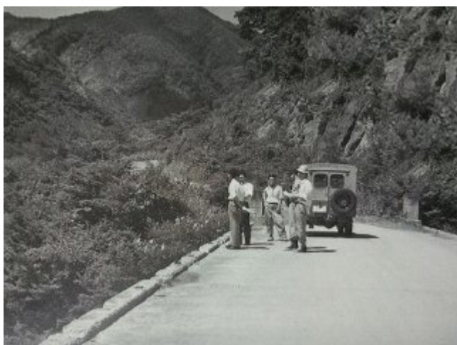
参考写真-42② 無高欄状態の新沢橋(昭和16年頃戦争のため鑄鉄製高欄供出)。昭和31年夏、福島工事事務所小林泰夫調査課長(左二人目)、山谷外行技術員(右二人目)等による調査。
