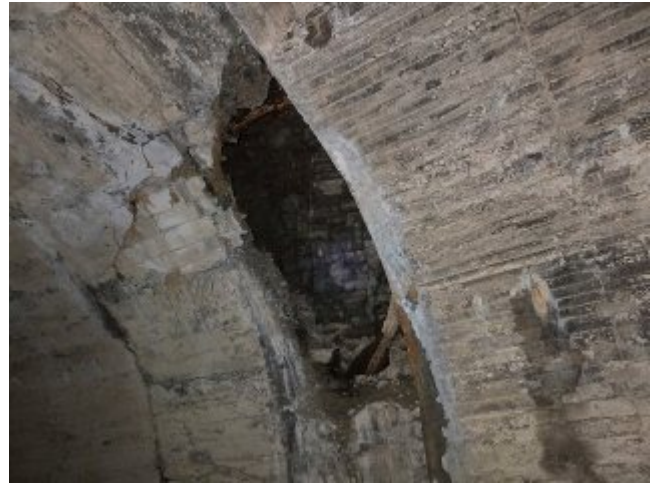
写真-20① 中間点付近左側覆工(巻立コンクリートアーチ部)崩壊箇所。
