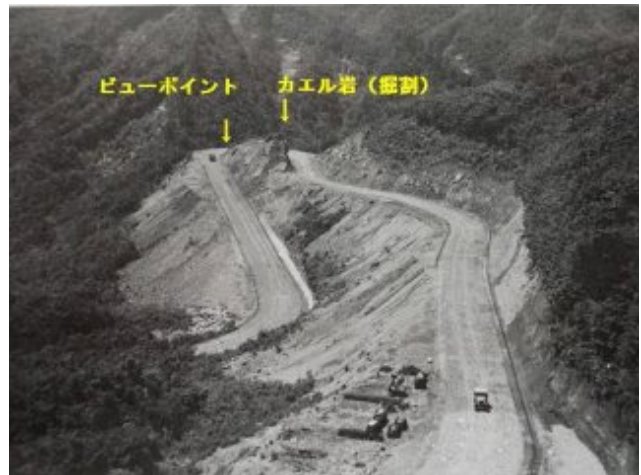
参考写真-17 「昭和の大改修」(S84～S123)二ツ小屋隧道福島側七曲バイパス箇所、最初のヘアピンカーブ全景、掘割箇所(カエル岩) 昭和9年頃撮影
