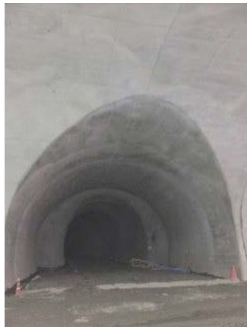
参考写真-6 本トンネル側換気坑(斜坑)入口。コンクリート巻立部、シングル鉄筋、ファイバーコンクリート。本体はコンクリート吹付(t=20cm)のみ。換気坑掘削開始 H25.07.22、終了 H25.09.30 (L=326m 清水・大豊特定建設共同企業体施工分)。H260328
