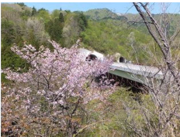
参考写真-1 本体が完成した(新)栗子トンネル(左側 L=8,972m)と山桜。H26.322 貫通。右側は避難坑。H270429
