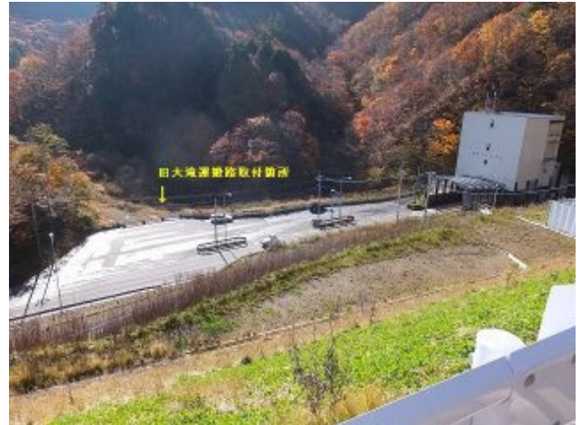
参考写真-11② 東栗子トンネル福島側坑口付近。左側旧大滝運搬路終点部取付け箇所(ガードレール仮設置部分)、右東栗子トンネル旧換気塔。新取付坂路(旧大滝運搬路)終点付近から望む。H261102
