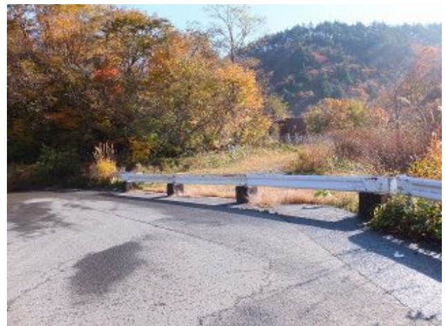
参考写真-11③ 旧大滝運搬路終点(国道13号本線取付け箇所) H261102
