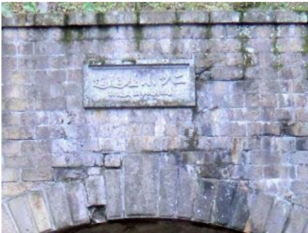
参考写真-24 第2代目ニツ小屋隧道福島側坑門。坑門面壁は切石積、トンネル坑口はアーチ石積で拱頂に楔石が見える。中央に東北地方整備局第8代坂本丹治局長揮毫の「トンネル銘板(額石)」 H221106
