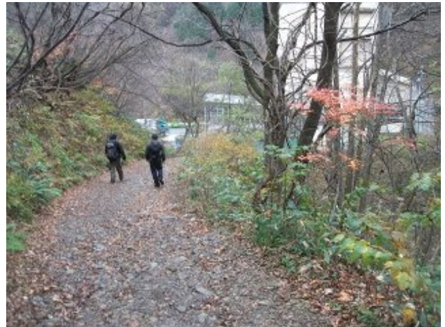
参考写真-5 林道(旧国道連絡路)上り口から少し進んだ所から上り口側を望む。東栗子トンネル福島側換気塔とその左側にローバー(L=13m、トンネル開口部緩和照明区間)が見える。H231113
