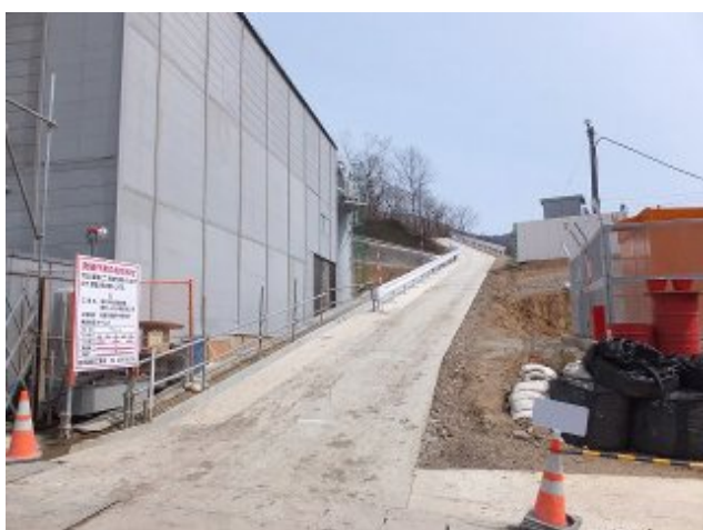
参考写真-9 取付け坂路全景。手前左側換気坑工事現場作業ヤード入口付近から旧大滝運搬路(旧万世大路への連絡路)を望む。 H260420
