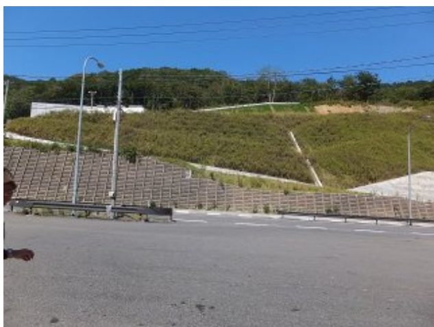
写真-1② 現在の旧万世大路(旧国道13号)連絡路(東北中央自動車道栗子トンネル換気坑工事用道路(完成後管理用道路))。左側の仮設建物箇所が換気坑作業ヤード。
