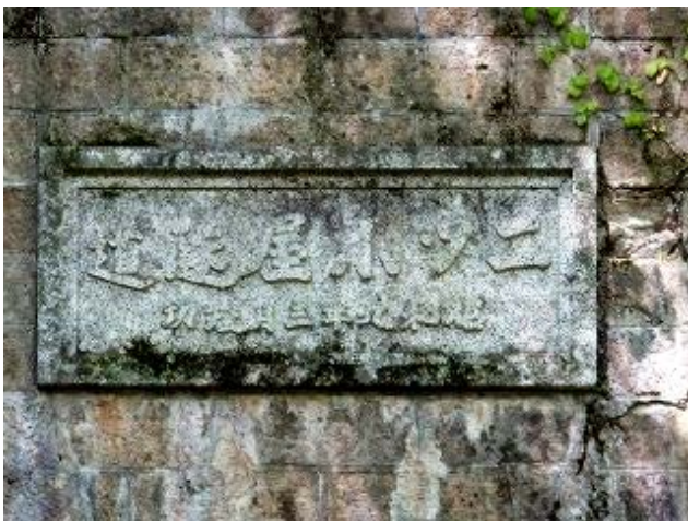
写真-16 ニツ小屋隧道トンネル銘板・福島側坑口、「ニツ小屋隧道 昭和九年三月竣工」東北地方整備局第8代坂本丹治局長（内務省仙台土木出張長）揮毫
