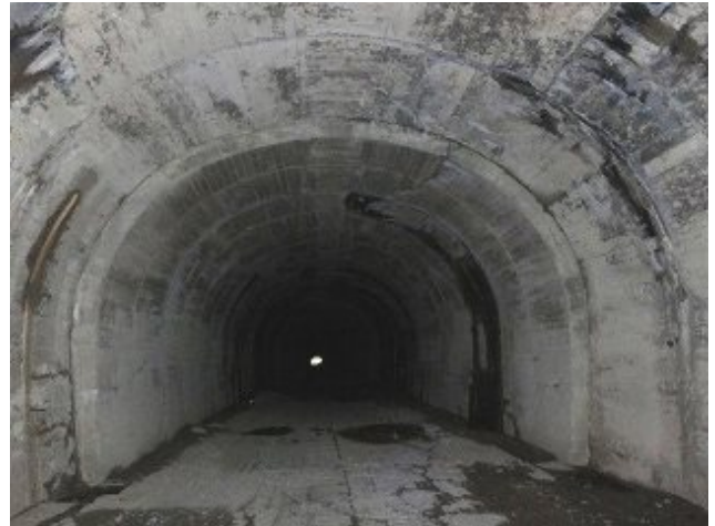
写真-13 福島側坑口から約 55m 付近、奥側仮称第 2 号内巻補修箇所（昭和 28 年頃補修）。手前コンクリート巻立は、昭和 9 年施工時のもの。福島側から米沢側を望む。中央の白丸は米沢側坑口。
