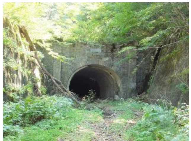
写真-15 第2代目二ツ小屋隧道 米沢側坑門、福島側と同一構造。倒木あり。坑口補修コンクリート(内巻)崩落進む。右側袖擁壁接続部コンクリート擁壁崩落。
