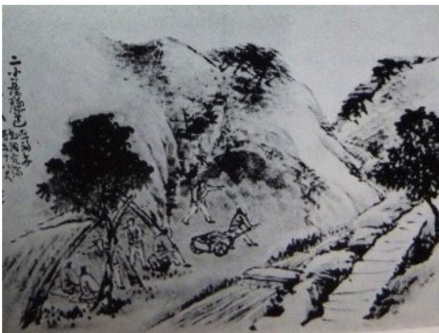
参考写真-21① 初代二ツ小屋隧道米沢側坑口、右上に白竜沢(仮称)が見える。菅原白龍図『栗子トンネル工事誌』から転載
