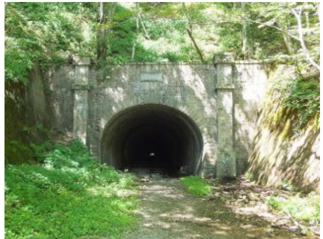
写真-14 第2代目二ツ小屋隧道 福島側の華麗なる坑門。アーチ石積坑口、面壁は切石積。門柱が配置されている。
