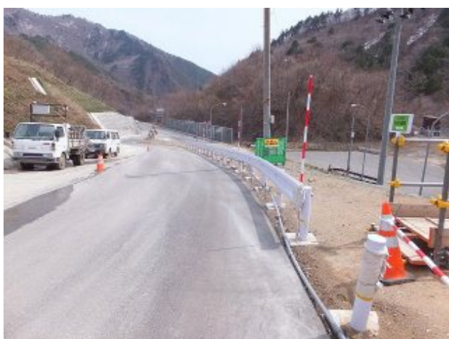
参考写真-7② 新に完成した旧万世大路連絡路(換気坑工事用道路・管理用通路)13号国道出入口を望む。写真奥国道13号、左上が福島側。写真右側手前が米沢側で東栗子トンネルに至る。H260420
