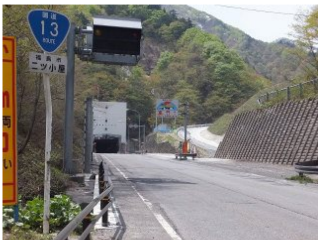
参考写真-7① 旧万世大路連絡入り口(東栗子トンネル福島側坑口)。トンネル左側が駐車帯。H270429
