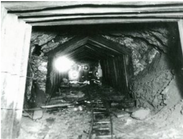
参考写真-22 改修前の栗子隧道坑内、「昭和の大改修」栗子隧道改修工事中（昭和9年）、旧二ツ小屋隧道もほぼ同様。
