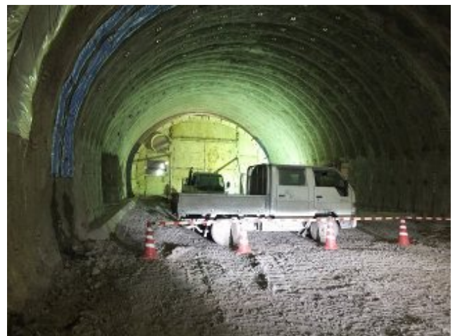
参考写真-3 栗子トンネル貫通点(式典会場付近)。清水大豊 JV 到達平成 25 年 7 月 1 日 L= 5,146 m(坑口付け、掘削開始 H220115)。平成 26 年 2 月 19 日、三井住友 JV 側到達(貫通)、L=3,826m。福島側から望む。左コンクリートはインバート(D 区間)仕切板施工中 H260328
