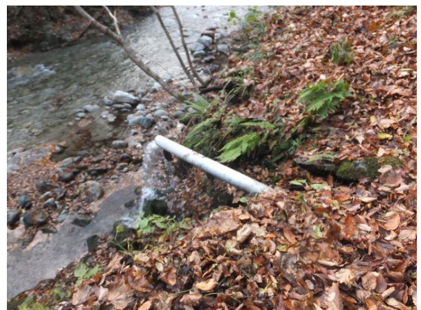
写真-11④ 旧坑道からの湧水の排水処理と思われる。
