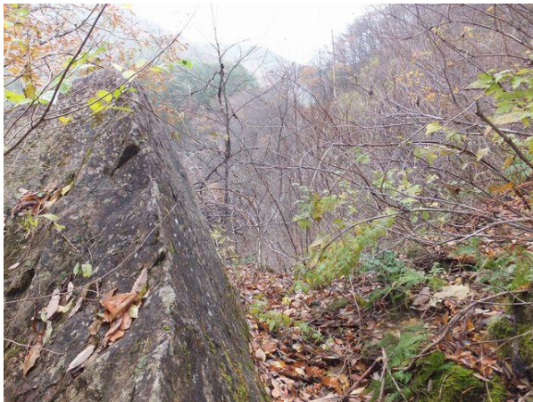
写真-3① 大桁がんげ・崩壊箇所米沢側から福島側(電柱箇所)を望む。左側転石(大石)は参考写真-1に見えるもの。がんげの高さは全高推定約 100m。
