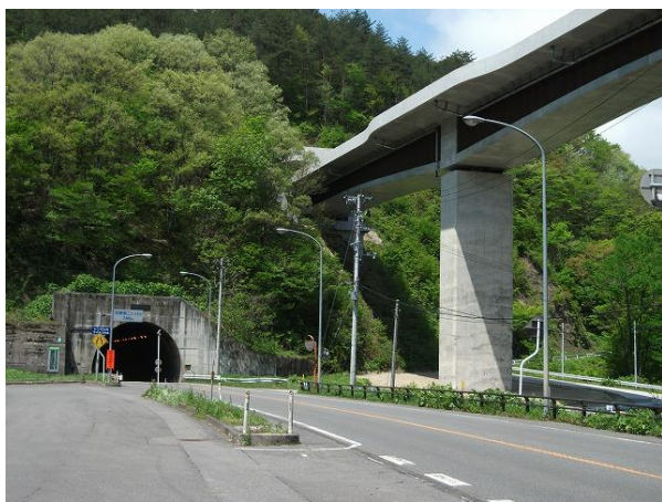
写真-1① 国道13号中野第2トンネル福島側坑口（字出来沼）。右側東北中央自動車道（E13）中野大橋橋脚P7、その奥が旧国道、約300m先大桁がんげ、崩壊箇所
