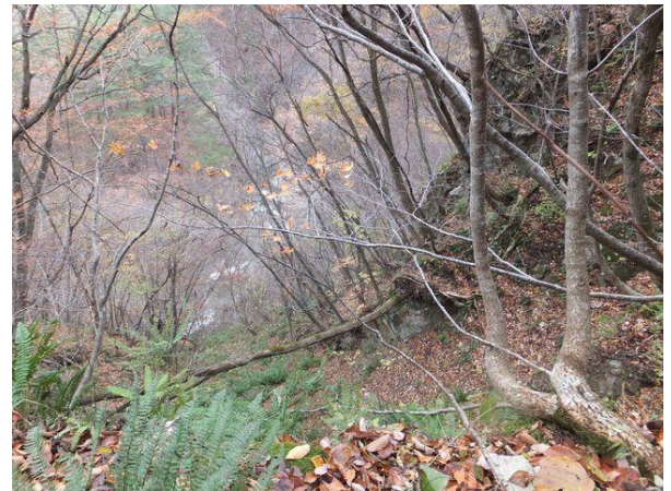
写真-3② 大桁がんげ・崩壊箇所米沢側手前の断崖状況。石積付近から、眼下の小川を望む(高さ推定 70~80m)。
