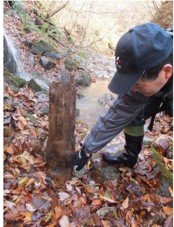
写真-13② 木橋橋脚(橋杭)遺構と思われる木柱、切り欠きが見える(方杖(ほうづえ:斜めの支柱)用か)。
