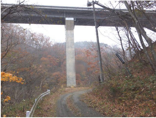
写真-14① 旧国道13号(万世大路)、現国道13号: 中野第2トンネル米沢側坑口から約200m地点のカーブ箇所。正面の橋脚は東北中央自動車道(E13)朴沢大橋P3橋脚。
