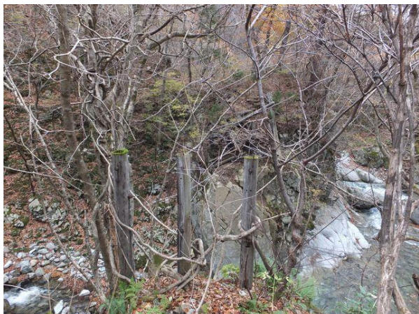
写真-15① 手前小川右岸、西側鉢山道路木橋遺構全景、左岸対岸に橋台部・上部工部材が残存。その奥の左右に鉢山道路が見える。
