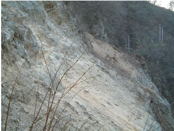
【参考写真-2】大桁がんげ崩落箇所延長約 100m、福島側から望む。写真奥電柱箇所は旧国道(万世大路)米沢側、当該箇所から約 100m先が東側鉾山道路入口。H160417 dark-RX 様提供
