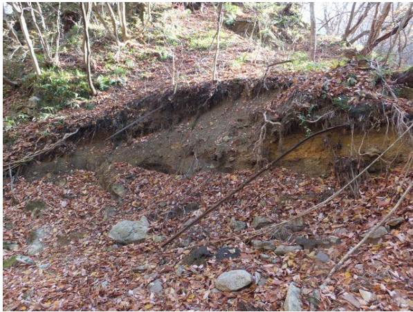
写真-9③ 右岸(手前流出箇所)、トロッコ線路終点か、線路が残存。写真中央上は鉱石運搬坂路、右側は鉱石集積所と想定される。
