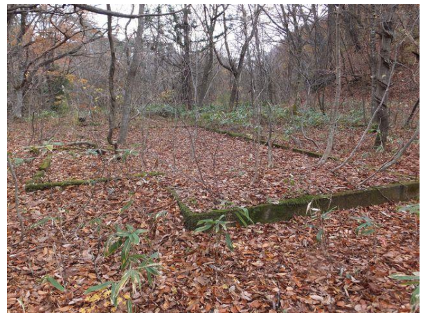
写真-7② 平地中央の建物基礎、鉱山事務所跡か。
