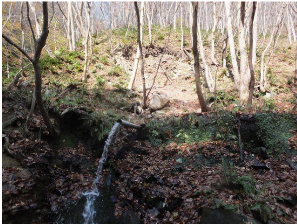
写真-11① 写真中央転石(大石)箇所、閉塞された零番坑(通洞坑)跡。その下、排水パイプで湧水を処理。小川河原から望む。
