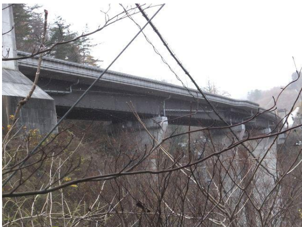
写真-17① 朴沢大橋。旧万世大路大桁地区から望む。
