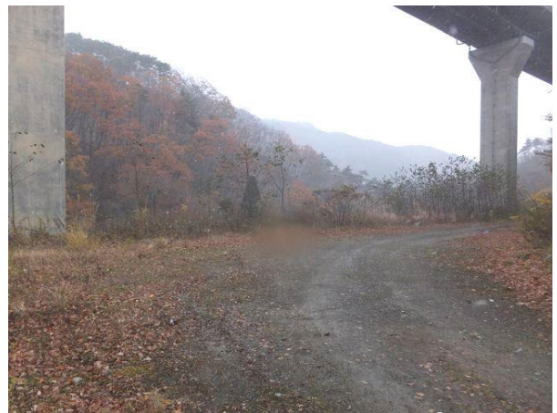
写真-14② 旧国道13号(万世大路)カーブ箇所(復原)、E13朴沢大橋左側P3橋脚、右側P2橋脚。旧西側鉦山道路はその中間付近に取り付いていた。改変され往時の面影はない。
