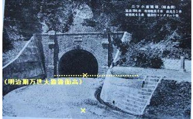
写真15 「昭和の大改修」で改修されたニツ小屋隧道福島側坑門と移転された石碑(写真右端「鳳駕駐蹕之蹟」)。移転前は、現道路面×印箇所約2m上方の明治期万世大路(上方の×印箇所、移転先とほぼ同じ高さ)に建立されていた。旧設置位置(上方の×印箇所)は、明治天皇が御小休所された福島県土木出張所跡。隧道の拡幅(掘り下げ)に伴い前後の道路も掘り下げられたものである(下、写真⑬参照)。
