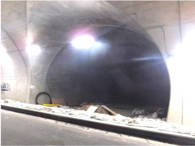
写真-4③ 車道用兼用電気室(非常駐車帯 L=80m、非難通路)施工中。福島坑口から約 4610m。換気坑付近。
