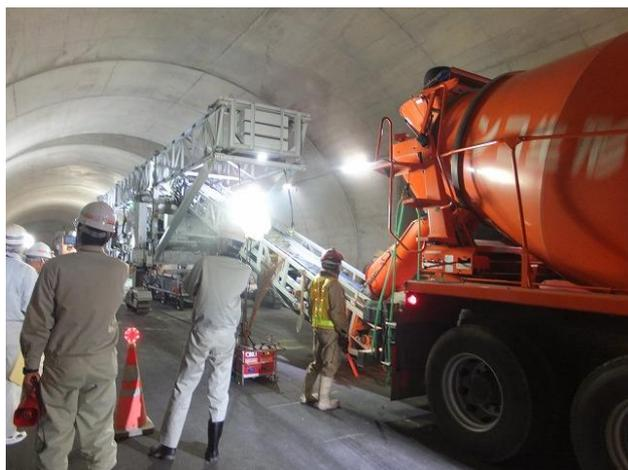
写真-5⑤ アジテータ車(生コン運搬車)による縦取機への生コン補給。
