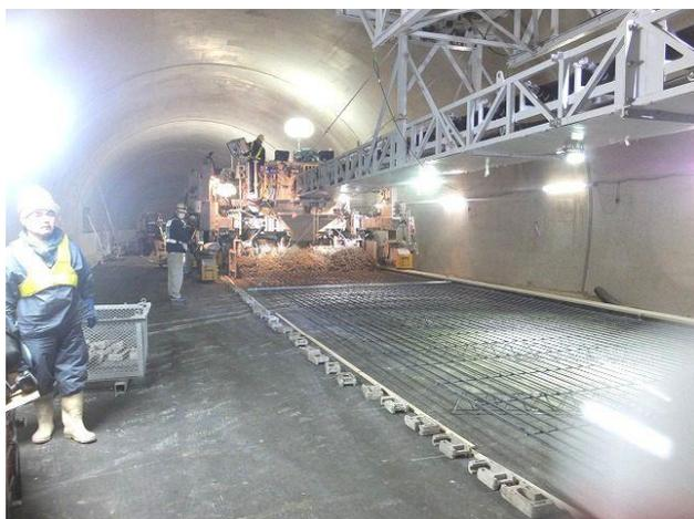
写真-5④ 縦取機(右上ベルトコンベア)によりスリップフォームペーパー(奥の機械)に生コンが送られ、敷均し締め固め成形などがおこなわれる。
