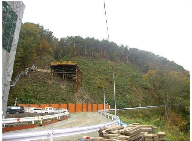
参考写真-5② 工事中の中野トンネル福島側坑口。急峻な地形。手前左側では中野第1橋の橋脚工事中。写真右側の道路が旧国道で工事用トンネル(横坑)に至る(旧大桁隧道)。H19.11頃
