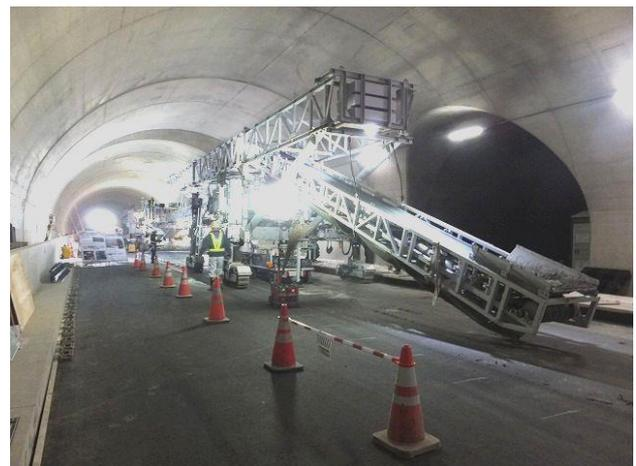
写真-5② 舗装工事の全体構成。スリップフォームペーパー(奥の機械)と縦取り機(手前)。
