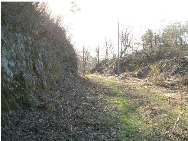
参考写真-5③ 旧大桁隧道崩壊跡の掘割箇所(推定)。石積端が福島側坑口と想定される。この掘割が埋められ作業ヤードとなる。福島側から米沢側を望む。H160417. dark-RXさん撮影提供
