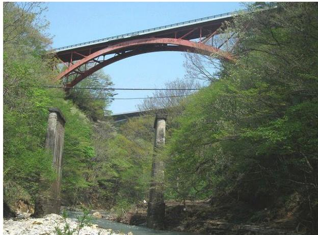
参考写真-9② 4代に亘る山神橋。下から初代・2代目(下部工遺構)、4代目(東北中央自動車道中野第1橋)、2代目(現国道13号) H240506
