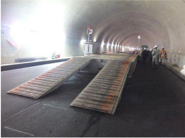
写真-5⑧ ターンテーブル。アジテータ車を荷台に載せ180度回転し方向転換させる装置。バックで縦取機へ。
