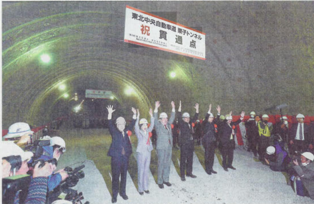
東北最長となる東北中央自動車道栗子トンネル(仮称)。貫通点を示す白線上で、山形県側を向き万歳する佐藤知事(左)ら
