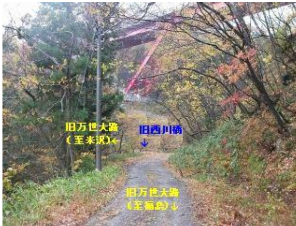
7 旧西川橋（旧国道 13 号・万世大路）と 現国道 13 号西川橋（上）
