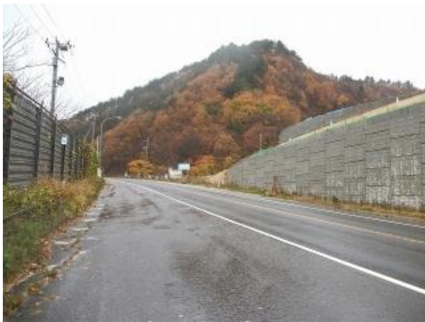
33 全山紅葉、大滝共同墓地を望む。右側の擁壁は 工事中の東北中央自動車道（チェーンベース箇所）。
