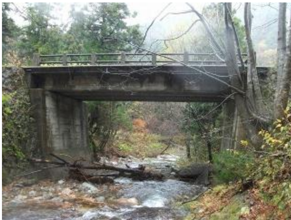
21 旧大滝橋、上流から望む
