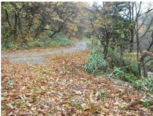
9 旧西川橋福島側から大滝集落方向を望む。
