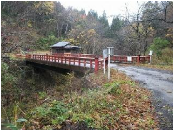
27 旧葭沢橋、福島側から米沢方面を望む
