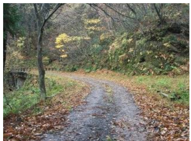
16 手前「入イラ澤橋」から「いら沢橋」・福島方面を望む
