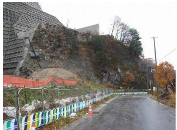
30 復活旧万世大路（大滝集落進入路）。 現国道13号からの入口を米沢側から望む。 左側旧栗子国道改築工事原石山跡、右側奥は 架設中の新長老沢3号橋（東北中央自動車道）。
