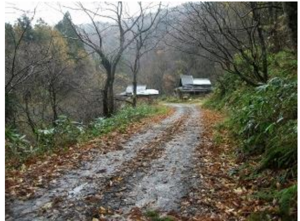
26 米沢側から旧葭沢橋方面を望む
