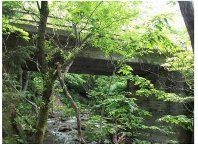
大滝橋 下流右岸から望む H240629 撮影
