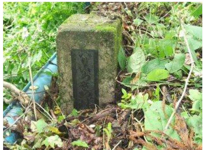
入イラ澤橋 親柱終点右側：ひらがな橋名「いりいらさわばし」 H240620 撮影
