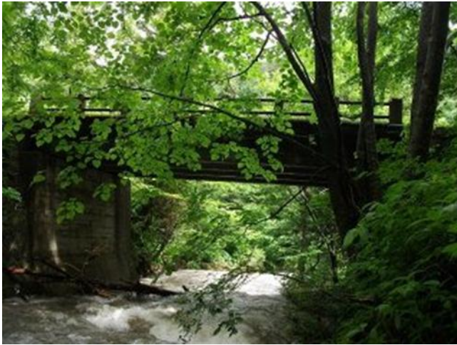
大滝橋 上流右岸側から望む H240620 撮影
