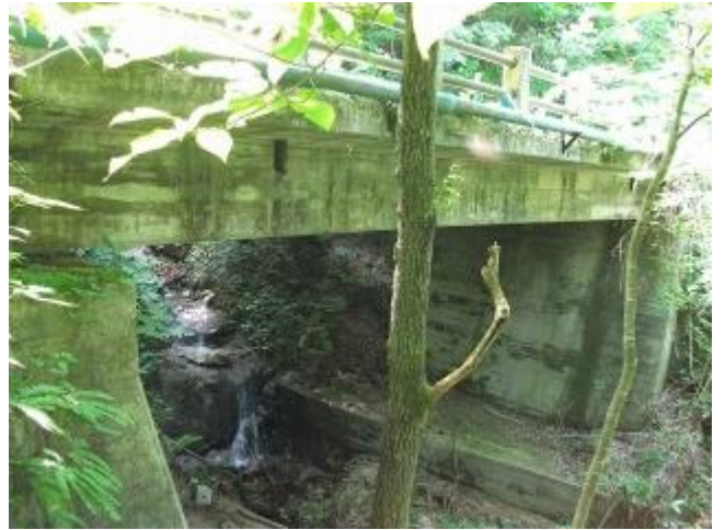
いら沢橋 下流右岸から望む
