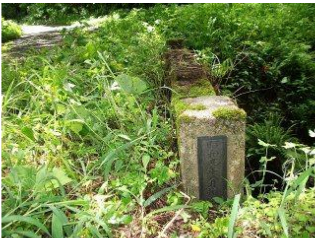
入イラ澤橋 親柱終点左側：竣工年月日「昭和 9 年 8 月」 H240620 撮影
