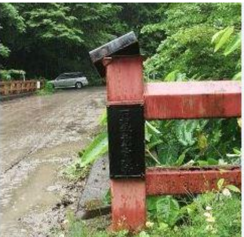
葭沢橋 親柱終点左側：竣工年月日：「昭和 53 年 3 月」 H240616 撮影
