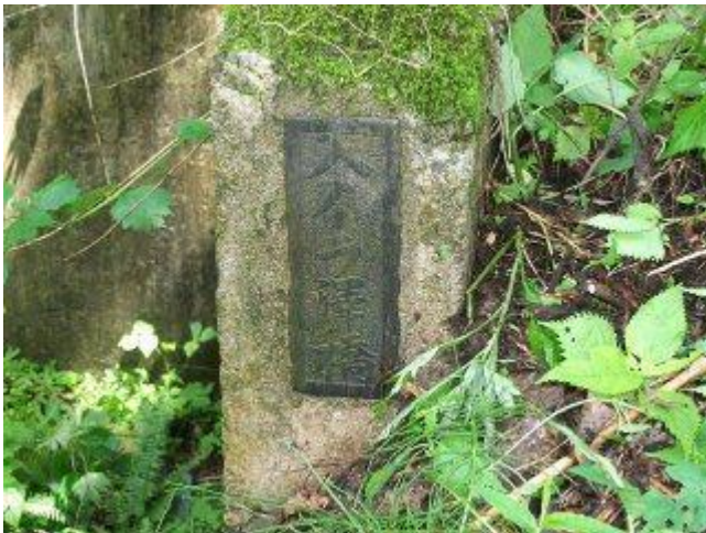
入イラ澤橋 親柱起点左側：漢字橋名「入イラ澤橋」 H240620 撮影
