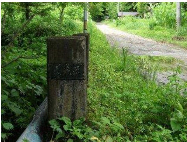
大滝橋 親柱起点左側：漢字橋名「大滝橋」（横書） H240620 撮影
