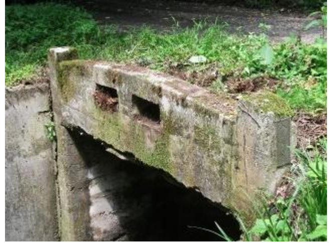
入イラ澤橋 飾付高欄、上流右岸側から望む。 約 80 年前の貴重な土木遺産。 H240629 撮影
