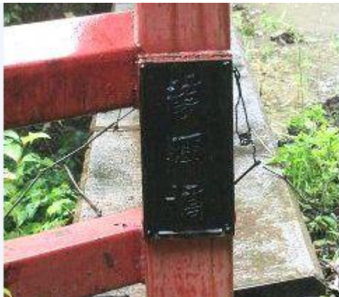
葭沢橋 親柱起点左側：漢字橋名「葭沢橋」 H240616 撮影
