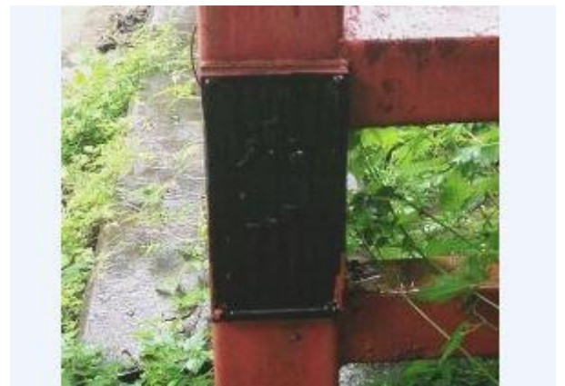
葭沢橋 親柱起点右側：河川名「小川」 H240616 撮影
