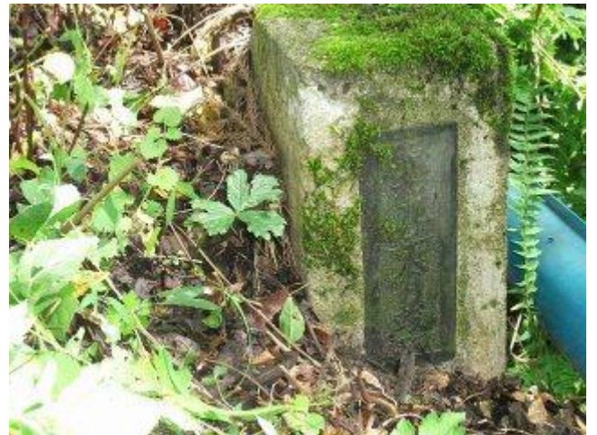
入イラ澤橋 親柱起点右側：竣工年月日「昭和 9 年 8 月」 H240620 撮影
