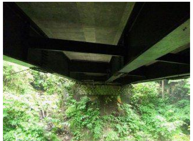
写真-2 葭澤橋・単純鋼H桁橋(1978年(53)3月) H24.06.16撮影
