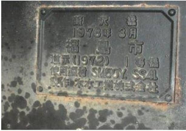
写真-3 葭沢橋・橋歴版 1978年(S53)3月制作・木本工業(株) H24.06.16撮影
