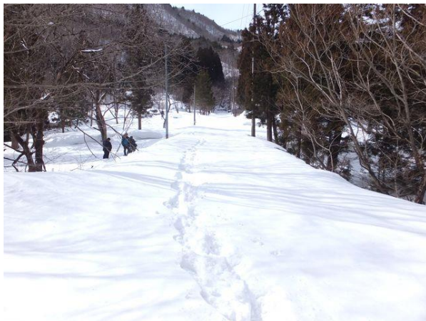
写真-5① 大滝地区、旧大滝橋(3代目、S40.10完) L=10.5m、w=5.5m。米沢側を望む (取材風景)。
