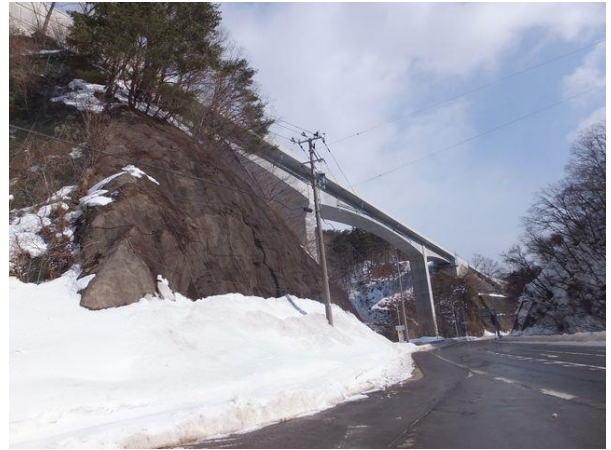
写真-1② 国道 13 号大滝集落入口から望む E13 大滝大橋(L=201m、H25.10 完)。 下は国道 13 号葭沢橋(L=49.4m 拡幅 H5 完)、福島側を望む。
