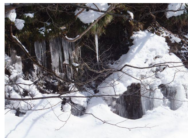
写真-5③ 旧大滝橋上流側(右岸)に見られた 氷柱。
