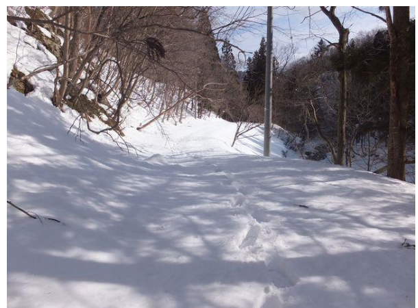
写真－13⑧ 旧西川橋左岸付近から福島側を望む。
