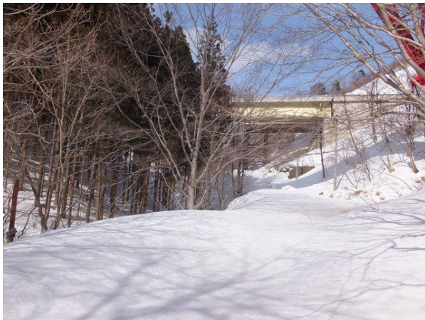
写真－13⑦ E13 東北中央自動車道、4代目新西川橋(L=77m、H20.10完)、旧西川橋付近から望む。 下の道は蛇体道。
