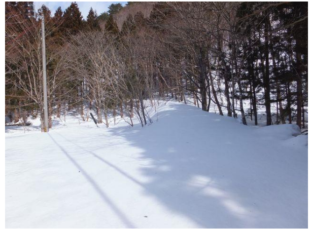
写真－9⑥ 国道 13 号への取付道路。米沢側を望む。
