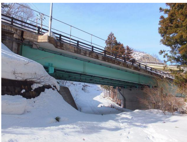
写真-1⑤ 現国道 13 号大滝橋(L=165m、H2 完)、 上は E13 東北中央自動車道新大滝橋。
