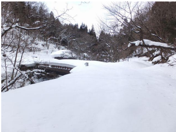
写真-2③ 葭沢橋(3代目、L=22.4m、W=5.5m、 S53.3 完)下流左岸から望む。
