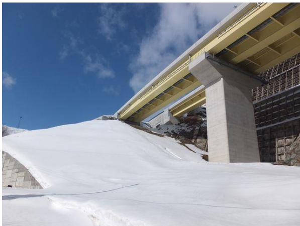
写真-1③ 国道 13 号大滝集落入口から望む E13 東北中央自動車道新大滝橋(L=113m、 H28.1 完)。
