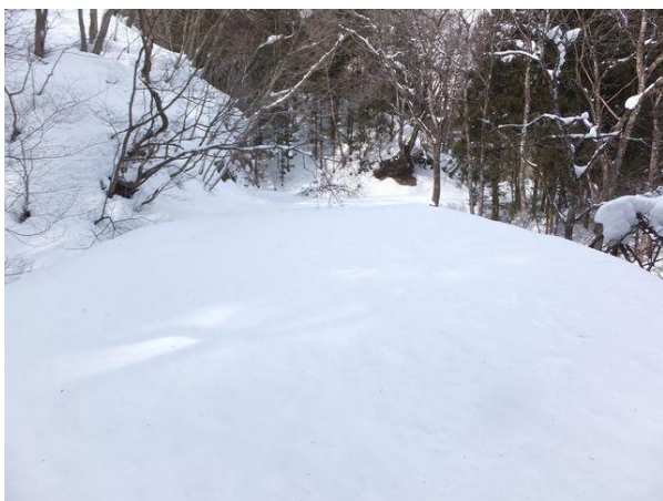
写真-8② いら沢橋(3代目、S40.10完) L=10.5m、w=5.5m。福島側から望む。
