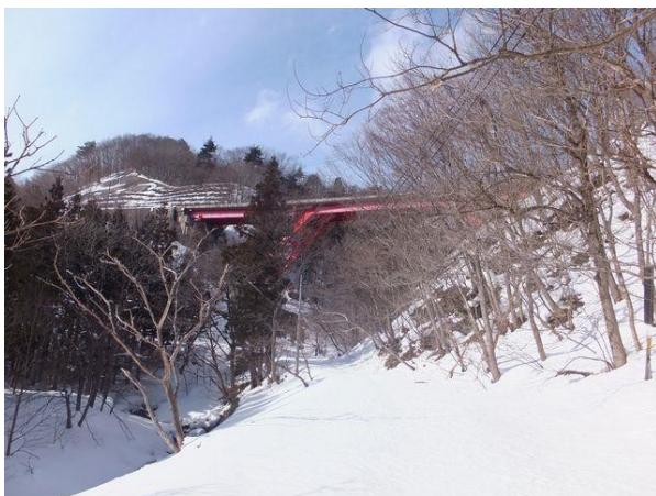
写真－13③ 旧国道 13 号から現国道 13 号 3 代目 西川橋(L=98.8m、S39.9 完、 標高 400m)を望む。
