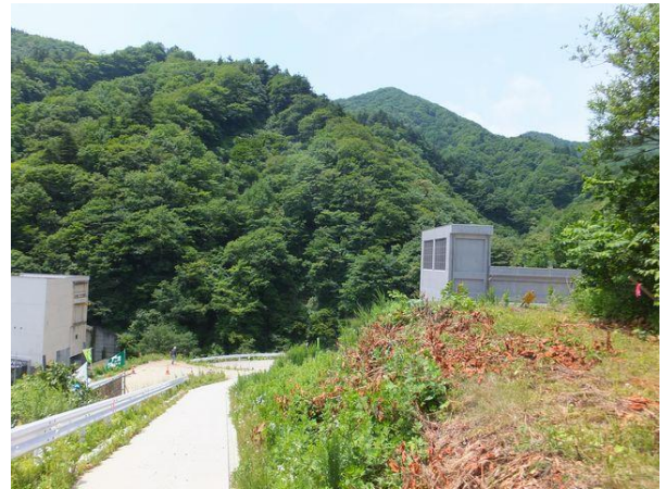
写真-8④ 連絡路取付部(換気塔管理用道路)。 右建物はE13東北中央自動車道新栗子トンネル換気塔、左側国道13号東栗子トンネル福島側旧換気塔(現在廃止)。 中央奥の山は葡萄沢山。
