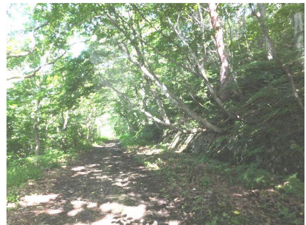
写真-11② ニツ小屋隧道手前の石積箇所。米沢側を望む。
