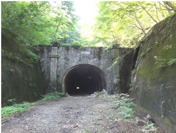
写真-13⑥ ニツ小屋隧道米沢側坑口
