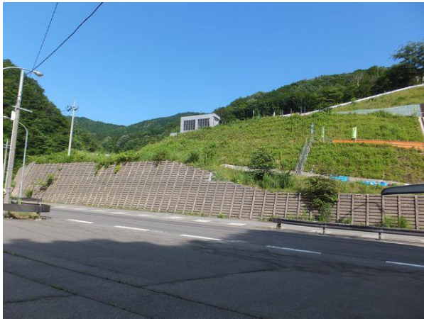
写真-8③ 万世大路連絡路・取付部(換気塔管理用道路)その2。 東栗子トンネル福島側駐車帯から望む。
