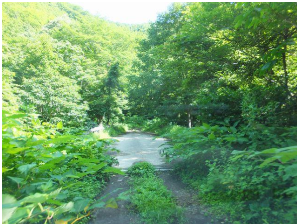
写真-14② D 烏川橋、福島側から米沢側を望む。
