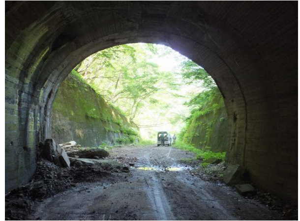
写真-13⑤ 米沢側坑口手前から米沢側を望む。
