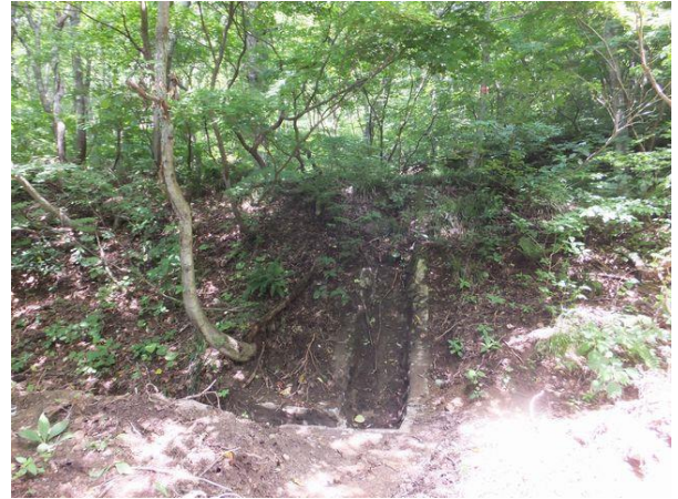
写真-10② 昭和の大改修(S8.4～S12.3)施工の竖溝(たてこう)。写真上は明治期万世大路「七曲」第1カーブ箇所。
