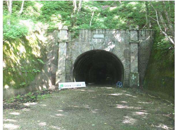
写真-13① ニツ小屋隧道福島側坑口
