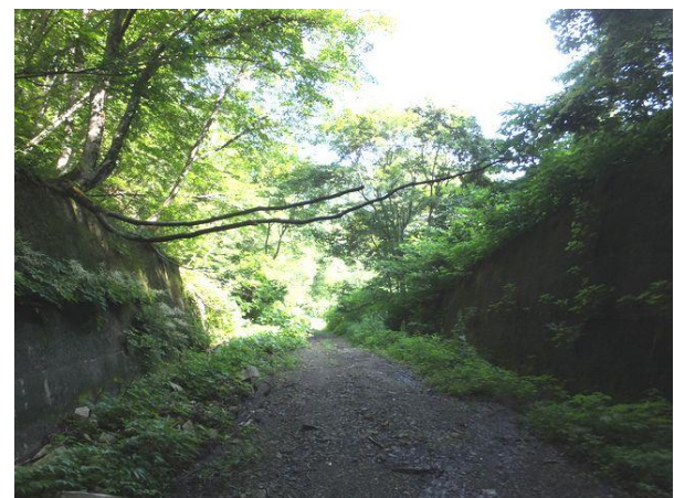
写真-14① 米沢側坑口から米沢側を望む。
