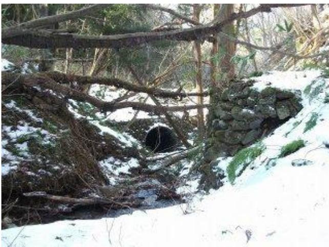
③(参考)大滝川右支川首尾戸沢に架かる赤岩道旧道の橋梁遺構、上流から望む。右岸野面石積の橋台、左岸橋台崩壊。正面は現赤岩道下の暗渠(コルゲートパイプ)。H241223 撮
