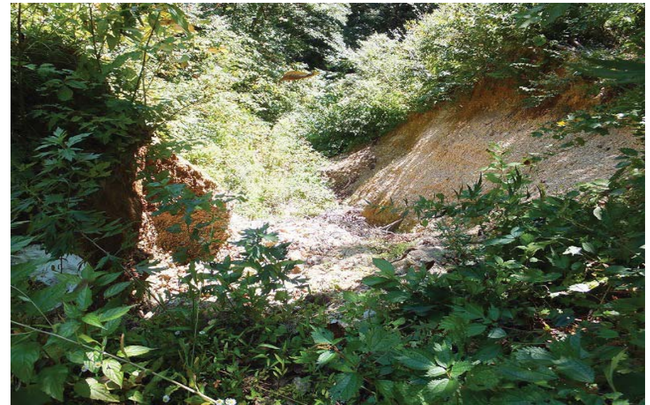
【崩壊箇所全景】 18
