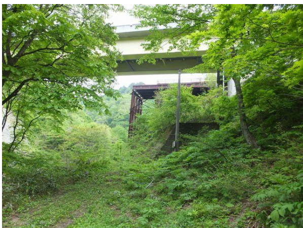
写真-1② 集合地点(国道13号西川橋)から蛇体道(クビト側)入口の新西川橋(東北中央自動車道E13)を望む。
