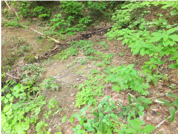
写真-3③ 小さな沢が蛇体道を横断。約 1.1km 付近
