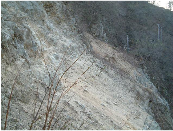
【参考写真-1④】 大桁がんげ崩落箇所約 100m、福島側から望む。写真奥電柱箇所は旧国道(万世大路)当該箇所から約 100m先が鉾山道路入口。H160417 dark-RX 様提供
