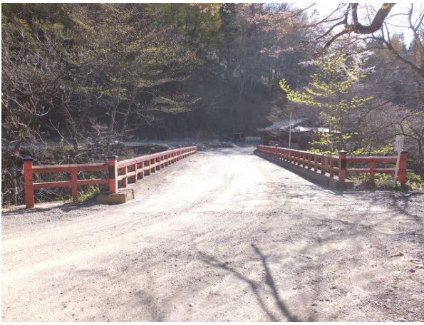
【写真-6①】 大滝集落入口、葭沢橋(L=22.4m、W=5.5m、昭和 53 年 3 月完成、福島市役所)、福島側から望む。この下流(左側)百数十 祀 に大滝鉱山。 H290428
