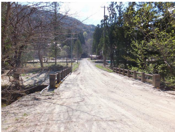
【写真-8】現在の大滝集落大滝地区(無人)、大滝橋から米沢側を望む。右の小屋(大滝会事務局)の奥が吾妻定さん宅跡、その道路向が旧大滝分校入り口(桜が咲いている)。大滝橋(L=10.55m、W=5.5m、S40.11完) H290428
