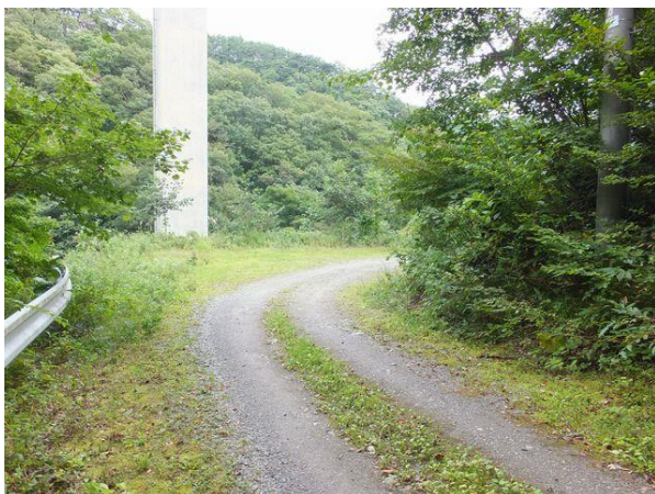
【写真-2①】 現国道13号中野第2トンネル米沢側から旧道に100mほどの地点。旧鉾山道路(西側)は前方橋脚(朴沢大橋)の辺りが入口だったと思われる。H290916
