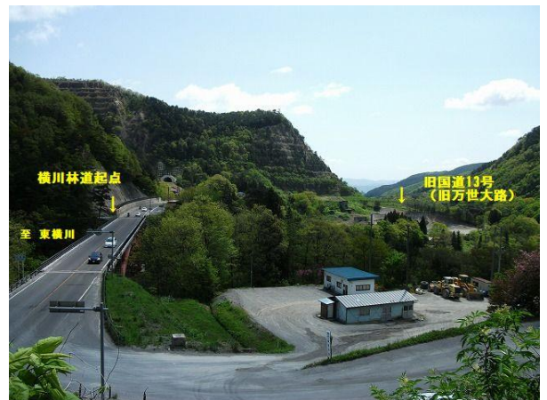
【写真-7②】 現在の杉ノ平地区全景(写真中央)、福島側を望む。左側、現国道 13 号山神橋。奥のトンネルは現高平隧道(トンネル) H240513
