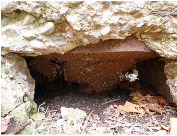
写真-6③ 風呂の焚き口、崩れ落ちている底板(鉄板)。いわゆる五右衛門風呂の一種であろう。鉄筋が見える。
