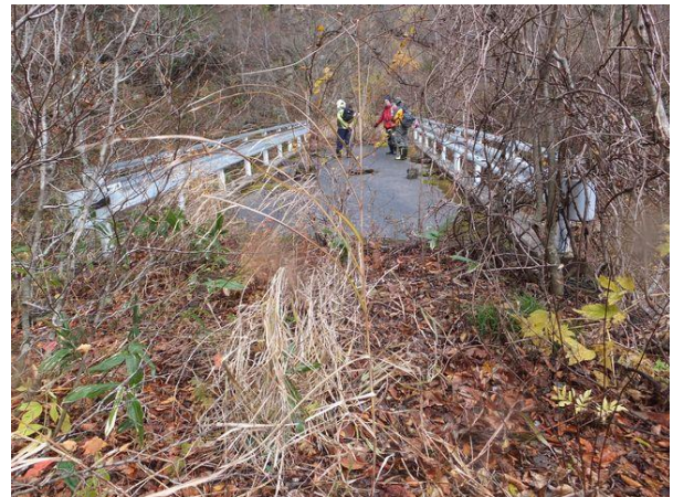
写真-1② 烏川林道「枯松支線」烏川橋(S51.9 完成)左岸から望む。
